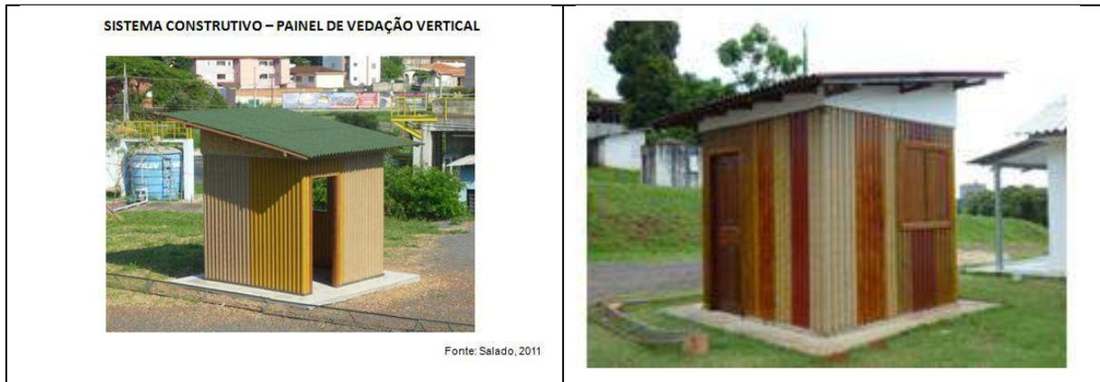
Figura 6 e 7 : Protótipos Tubos de Papelão. Fonte: Salado (2011); Salado (2014)
