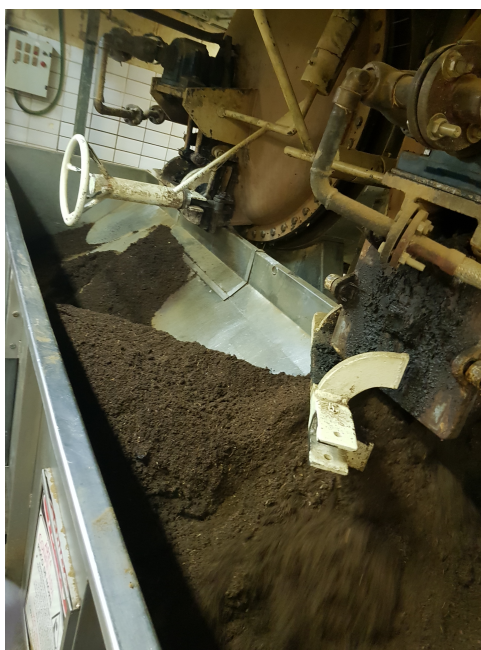
Figura 7 – Saída dos digestores para o percolador.
