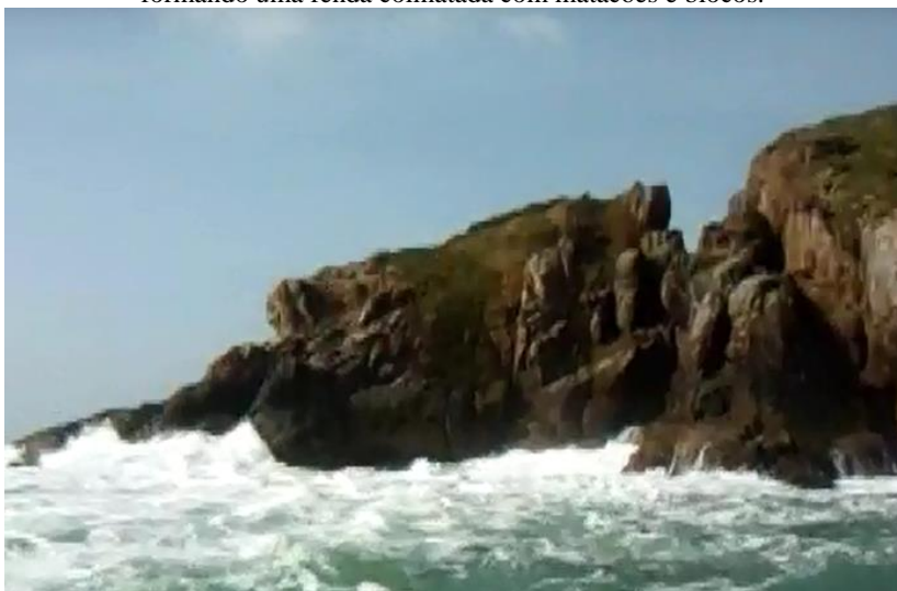
Figura 131 - Vista para sudoeste observando-se a diáclase no embasamento formando uma fenda colmatada com matacões e blocos.
