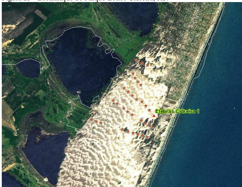
Figura 25 - Localização do Parque Eólico Cidreira, RS.
