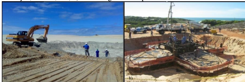
Fonte: CORTEZ ENGENHARIA, 2008.
