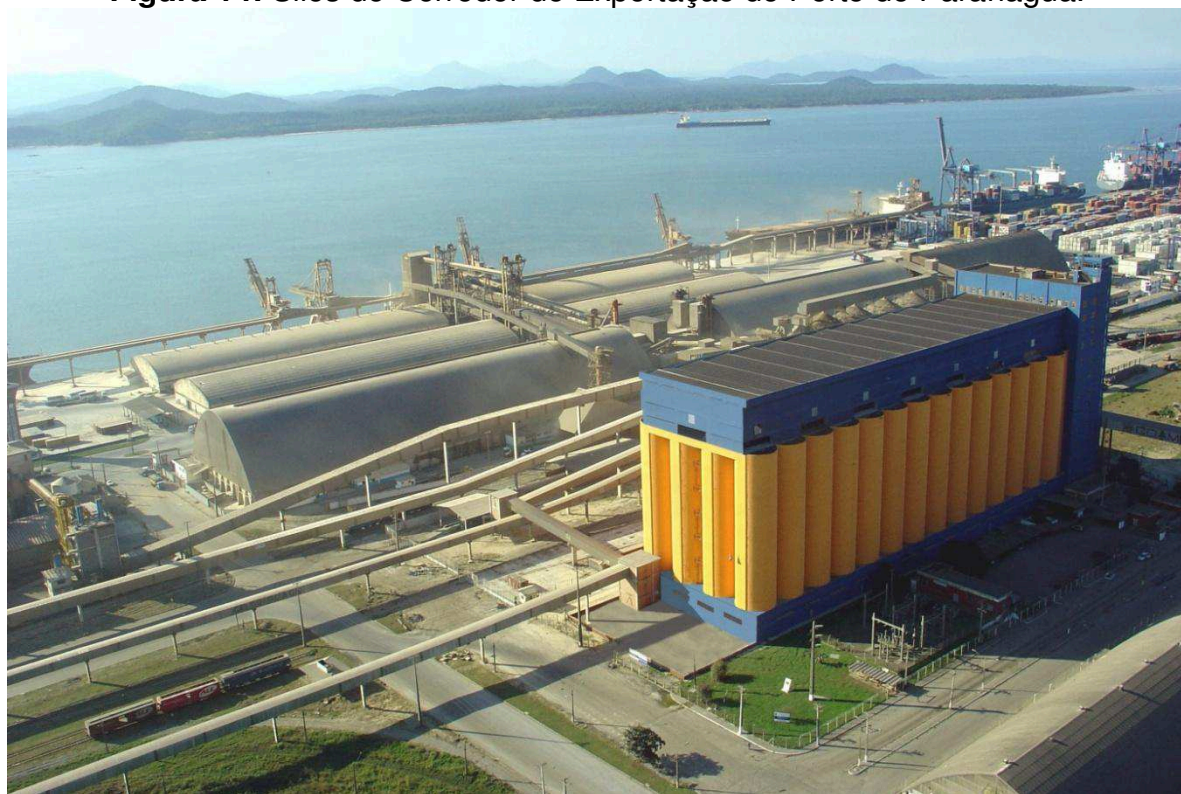
Figura 14: Silos do Corredor de Exportação do Porto de Paranaguá.
