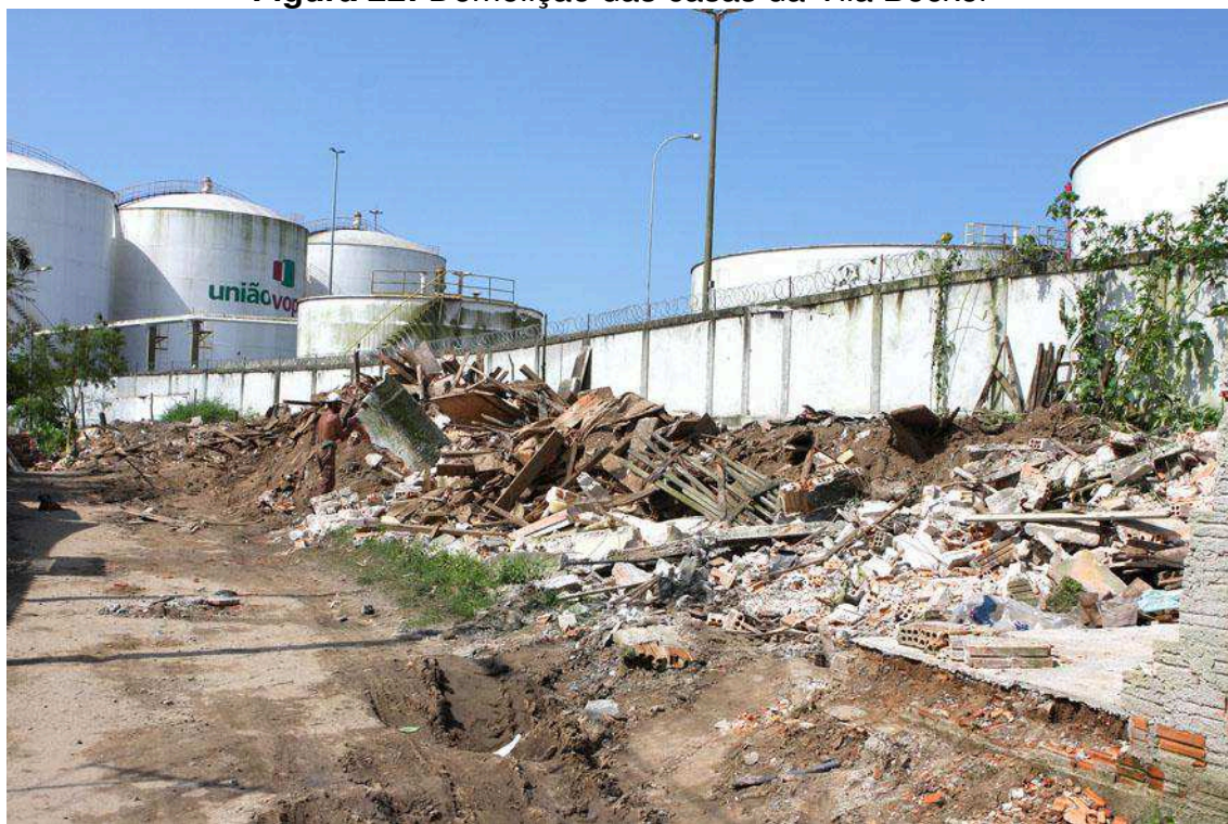
Figura 22: Demolição das casas da Vila Becker
