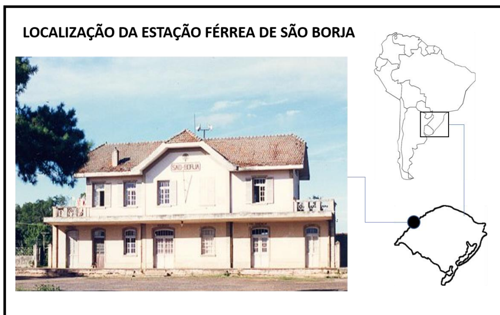
Figura 6: Estação Férrea de São Borja em 1996.
