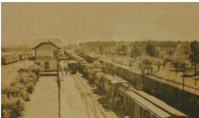
Figura 7: Comboios de carga na Estação Férrea de São Borja, data desconhecida.
