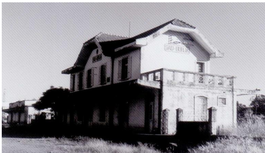
Figura 8: Estação Férrea de São Borja em 2002.
