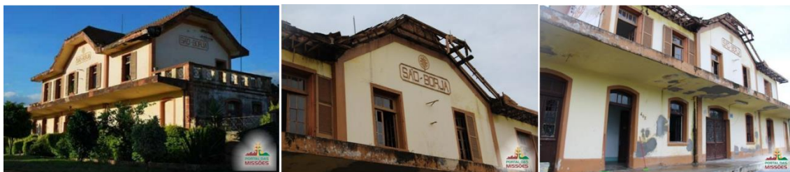
Figura 10: Nível avançado de degradação da Estação Férrea de São Borja, data desconhecida.
