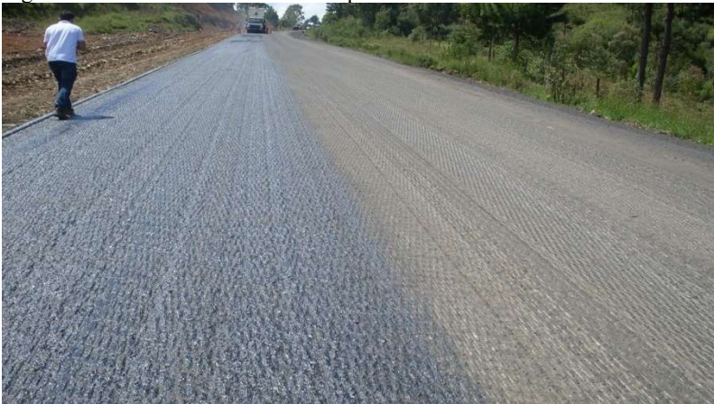
Figura 18 - Pista fresada recebendo a primeira camada – SAMI.
