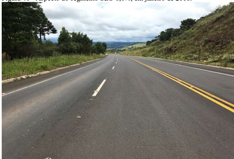
Figura 40 - Aspecto do segmento SBS-6,0%, em janeiro de 2018.
