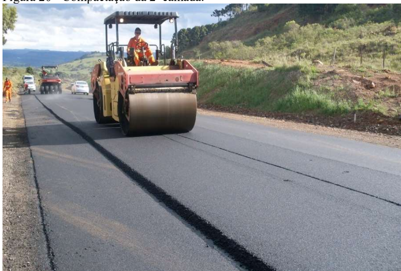
Figura 20 - Compactação da 2ª camada.
