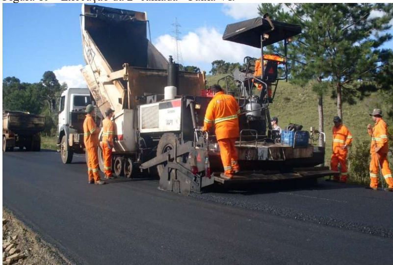
Figura 19 - Execução da 2ª camada - Faixa VI.
