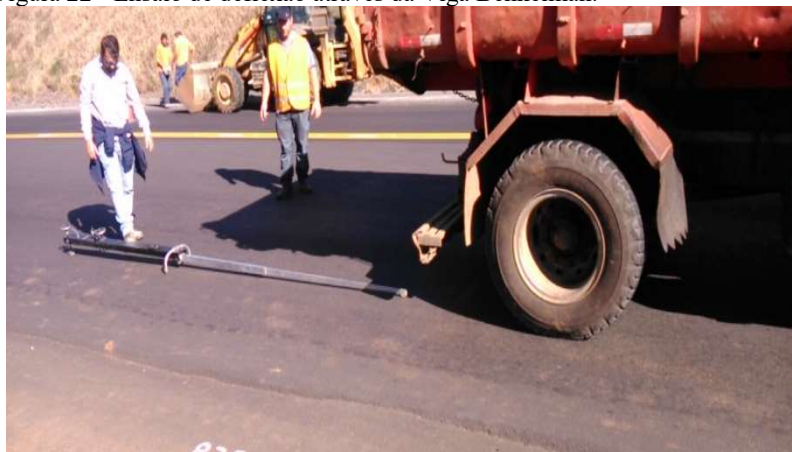
Figura 22 - Ensaio de deflexão através da Viga Benkelman.
