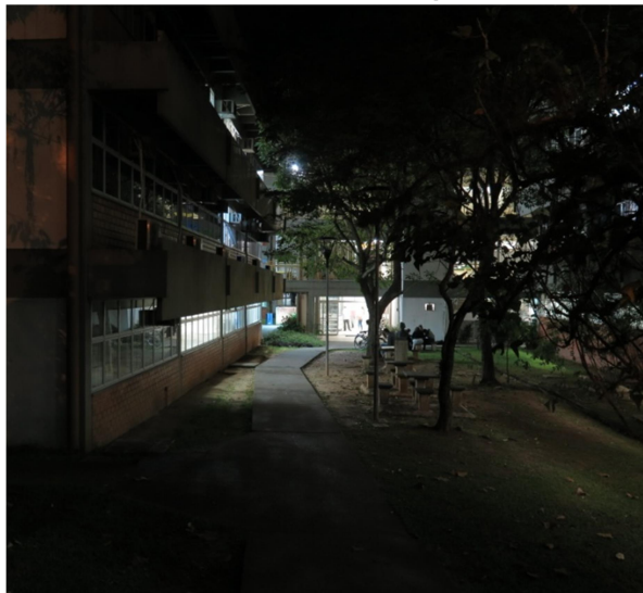
Figura 22: Vista da escadaria em direção ao bloco do CSE com salas de aula térreas com lâmpadas acesas
