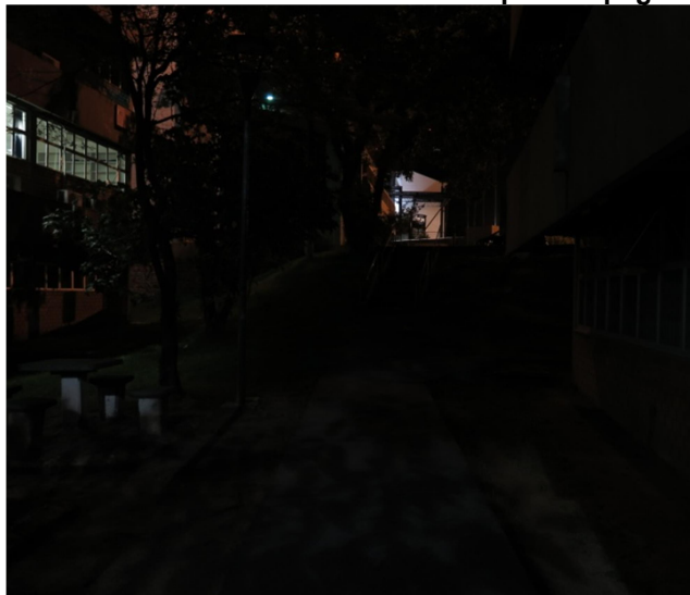
Figura 21: Vista do meio do percurso para a escada de acesso ao CCJ com salas de aula térreas com lâmpadas apagadas
