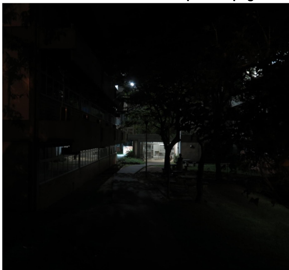
Figura 23: Vista da escadaria em direção ao bloco do CSE com salas de aula térreas com lâmpadas apagadas
