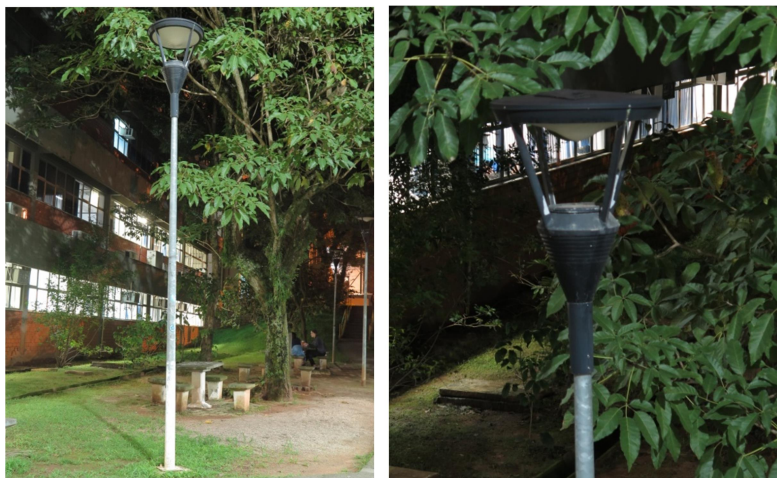
Figura 17: Poste com luminária que estava instalada no local
