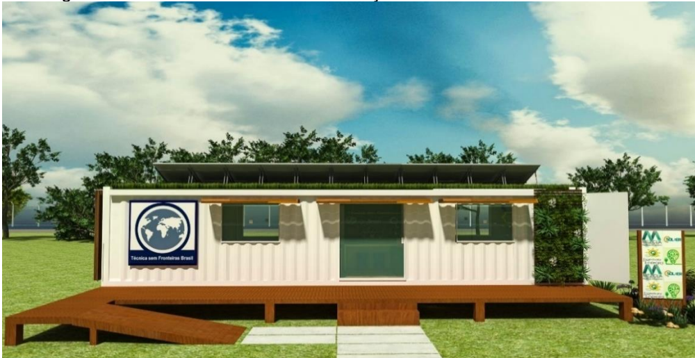
Figura 9 – Fachada da sede da associação Técnica sem Fronteiras Brasil.
