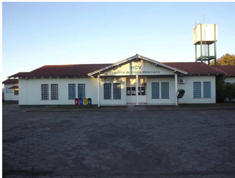
FIGURA 5 – Hospital de Clínica Veterinária na UDESC em Lages-SC.
