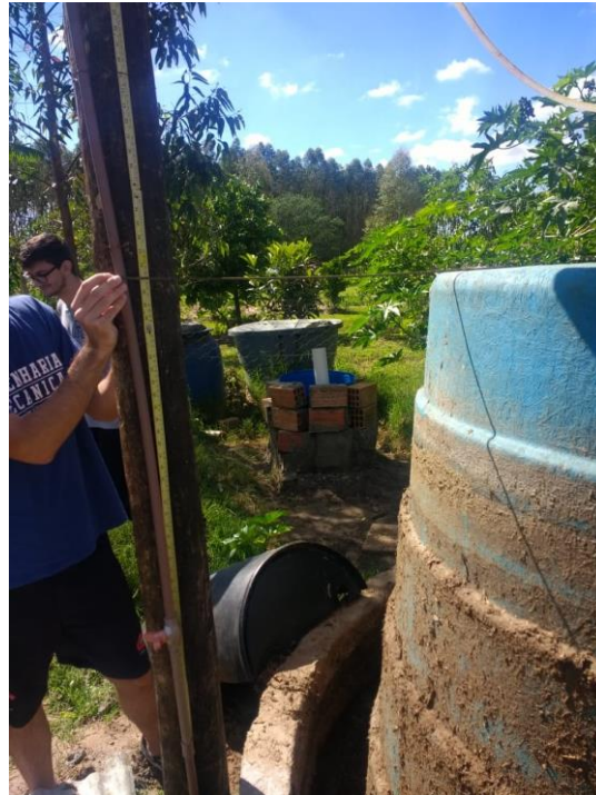
Figura 6 – Método para monitoramento da elevação do gasômetro
