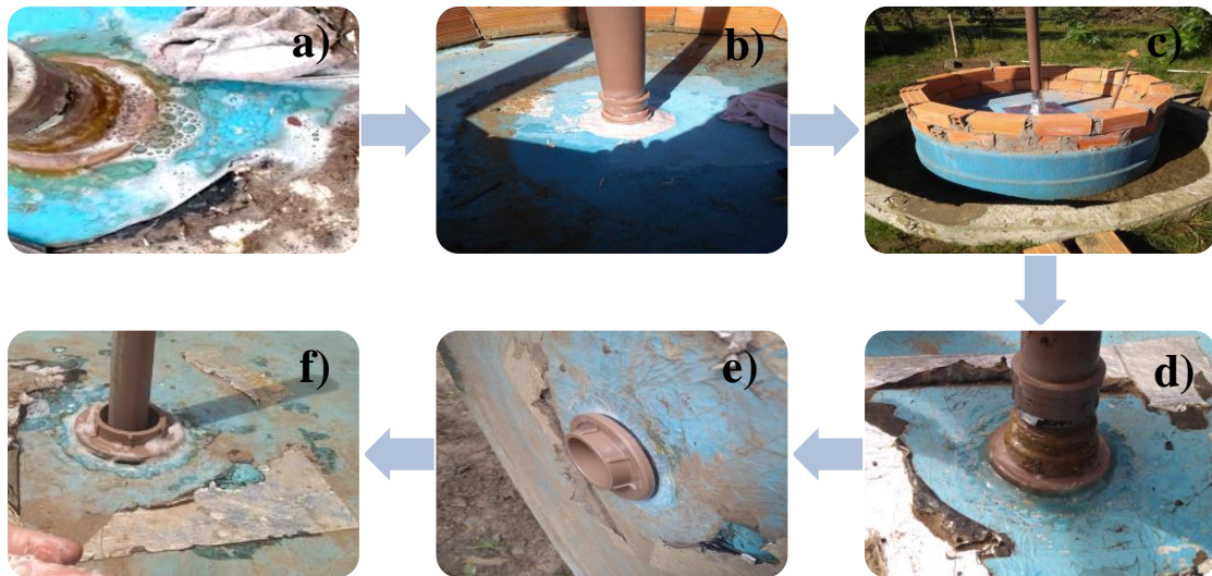
Figura 9 – Identificação e reparos do vazamento no gasômetro: a) vazamento identificado; b) aplicação de cola Durepox; c) aplicação de fita asfáltica; d) aplicação de cola Epóxi; e) flange de 60 mm novo; f) Teste negativo para vazamento, após substituição do flange
