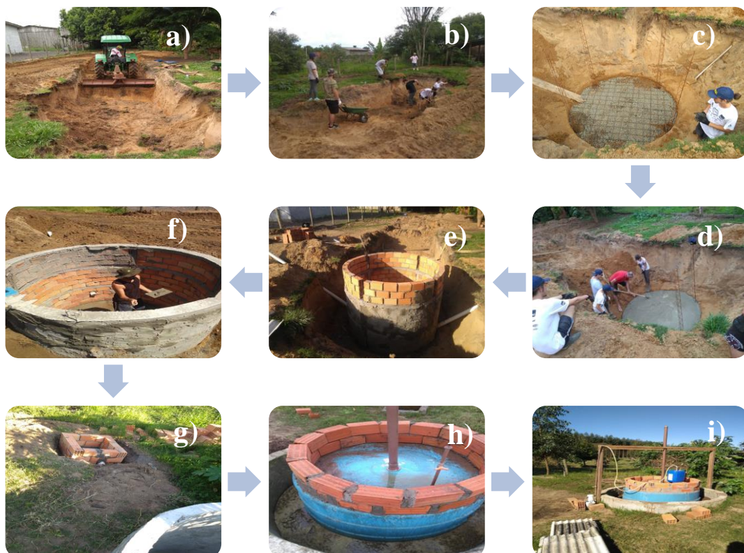
Figura 7 – Fluxograma das etapas de construção do biodigestor de baixo custo: a) e b) abertura do buraco; c) e d) construção da base do tanque de fermentação; e) elevação das paredes do tanque de fermentação; f) reboco dos lados interno e externo do tanque de fermentação; g) Caixa de entrada; h) Instalação do gasômetro e do sobrepeso; i) Instalação do filtro de água e do batente
