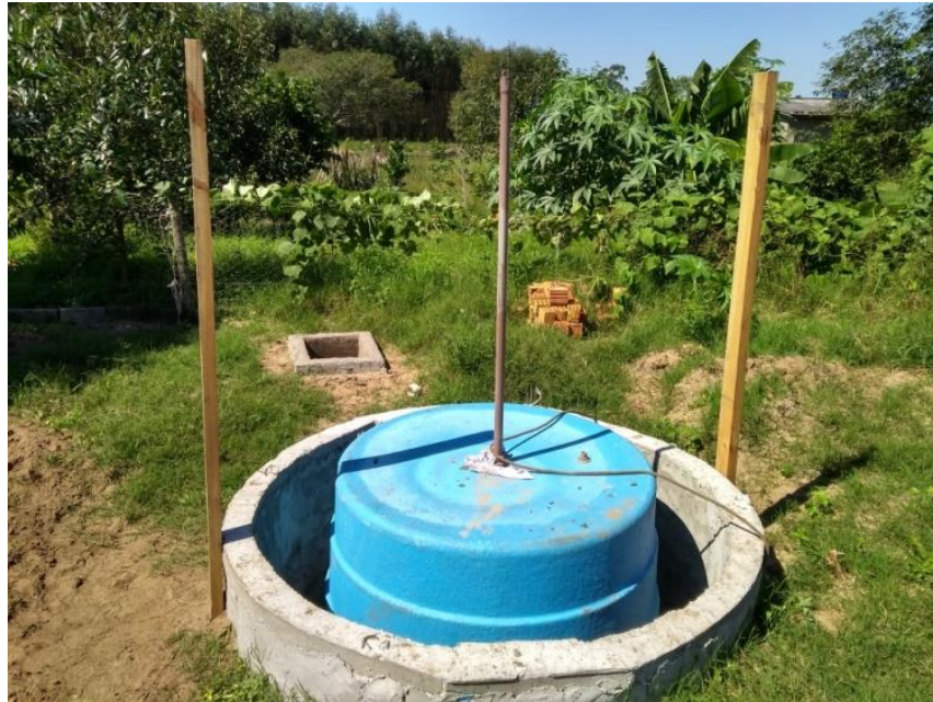
Figura 8 – Instalação do gasômetro
