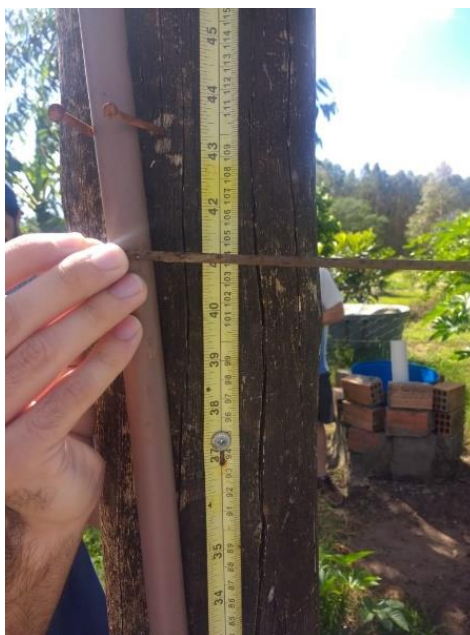
Figura 10 – Verificação da elevação do gasômetro
