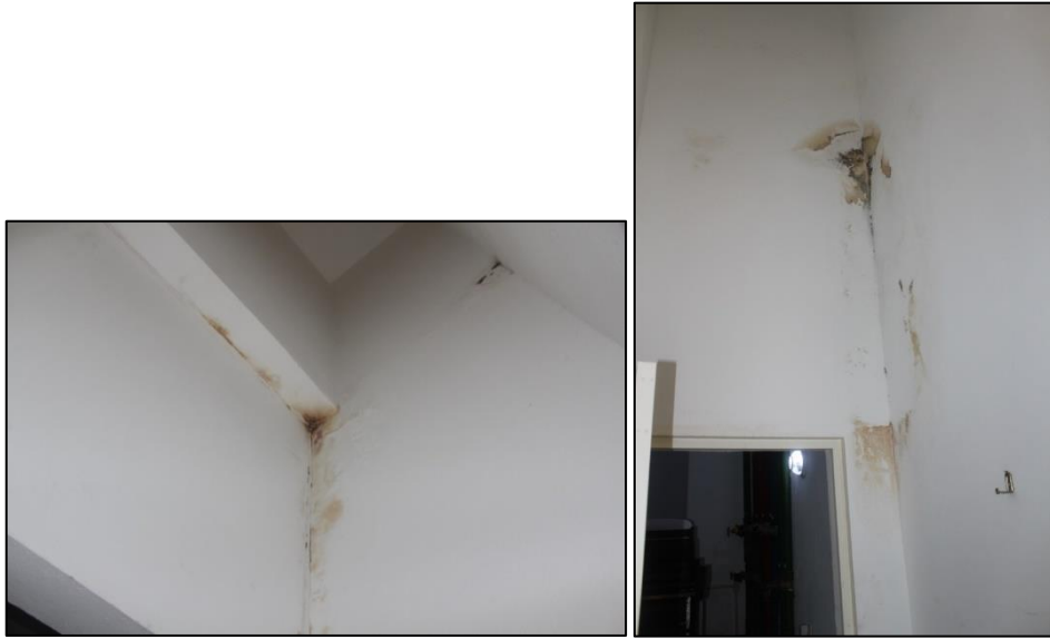
Figura 48: Manchas de umidade acima da escadaria, na base do reservatório.
