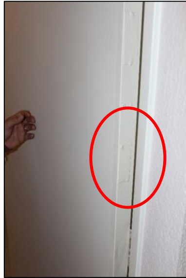
Figura 45: Demonstração de uma PCF que não está devidamente identificada.
