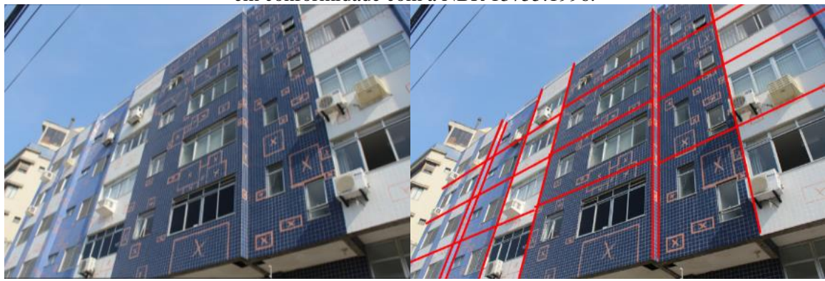
Figura 4: Mapeamento de peças cerâmicas soltas e demarcação de locais onde deveriam haver juntas, em conformidade com a NBR 13755:1996.
