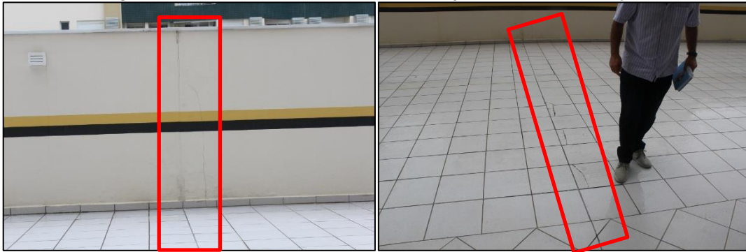
Figura 58: Fissuras decorrentes da falta de junta de movimentação.
