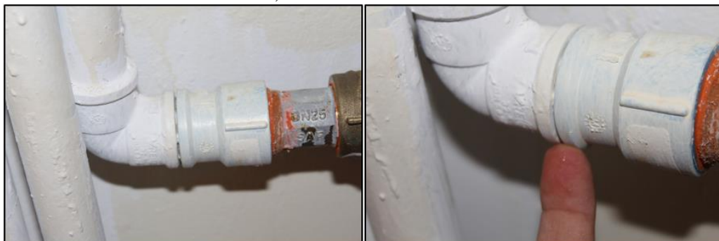
Figura 43: Em uma instalação há a execução de dois conectores praticamente sem tubulação entre eles, e há incidência de vazamento.
