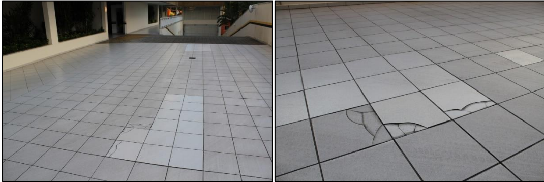
Figura 21: Alguns pisos instalados estão com as tonalidades de diferentes das demais.
