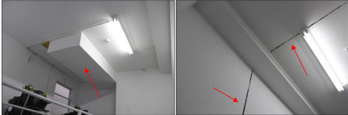
Figura 50: As juntas passam no meio da Casa de Máquinas. Acima, ela representa a divisão entre os reservatórios superiores.
