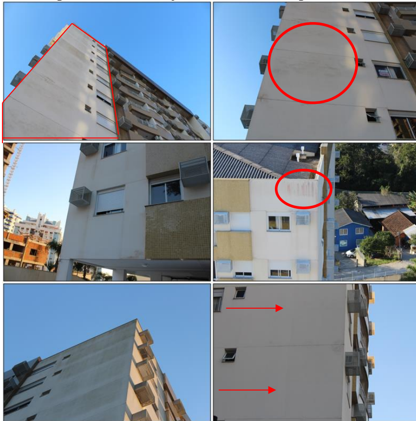
Figura 56: Fachadas apresentando manchas generalizadas.
