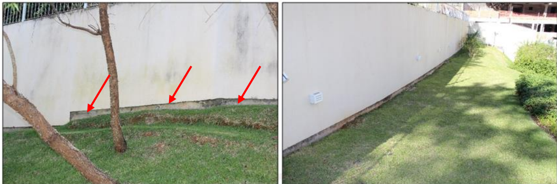
Figura 27: Formação de ondas de terra devido ao cedimento de material do solo.
