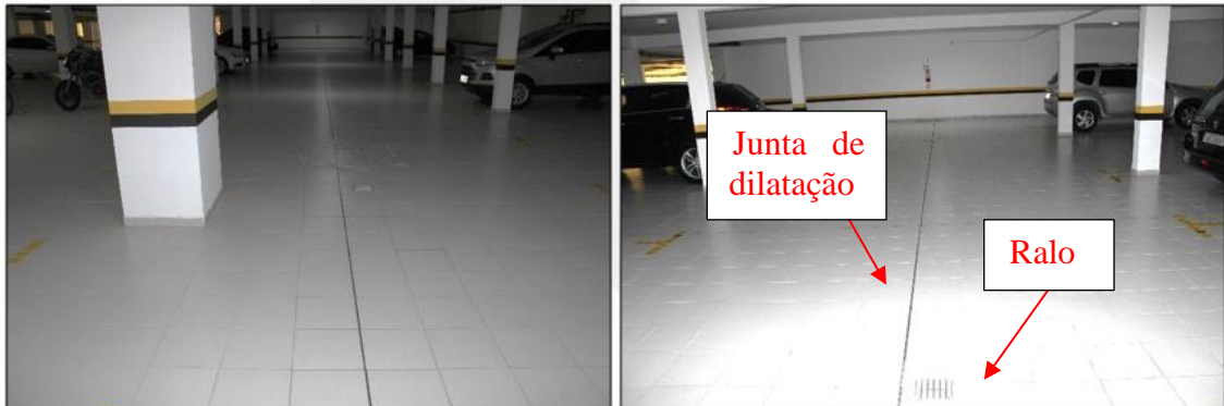
Figura 17: Execução de juntas próximas ao ralo, possibilitando a infiltração nas mesmas.
