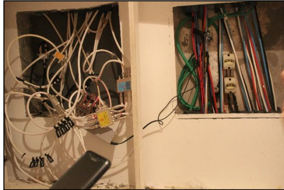
Figura 40: Exemplo não isolado das instalações lógicas desorganizadas.
