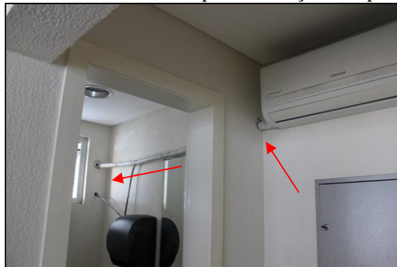
Figura 14: Falta de infraestrutura para instalação do Split na Guarita
