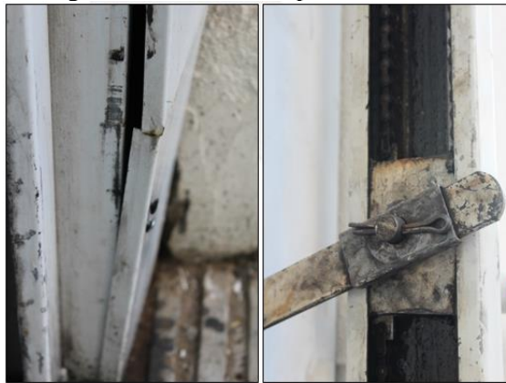
Figura 13: Detalhes do portão de acesso.
