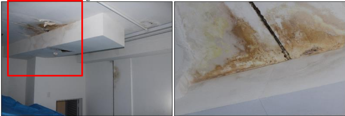
Figura 47: Manchas de umidade no teto do Barrilete.
