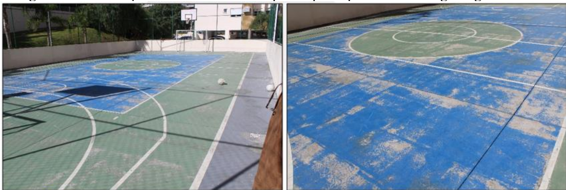
Figura 26: A condição do revestimento da quadra poliesportiva é de desgaste generalizado.
