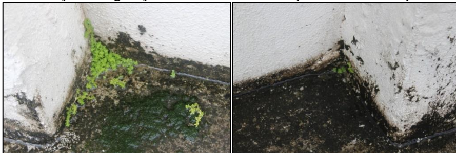
Figura 55 - Presença de vegetação nas calhas indicam problemas na impermeabilização.
