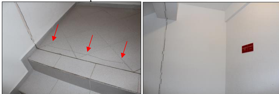
Figura 38: A maioria dos pavimentos apresentam fissuras acentuadas, enquanto em alguns as juntas estão desempenhando bem a flexibilidade necessária.
