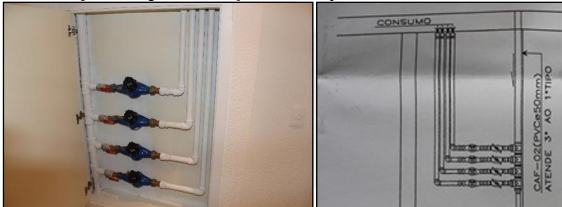
Figura 41: Algumas instalações estão adequadas e em conformidade.
