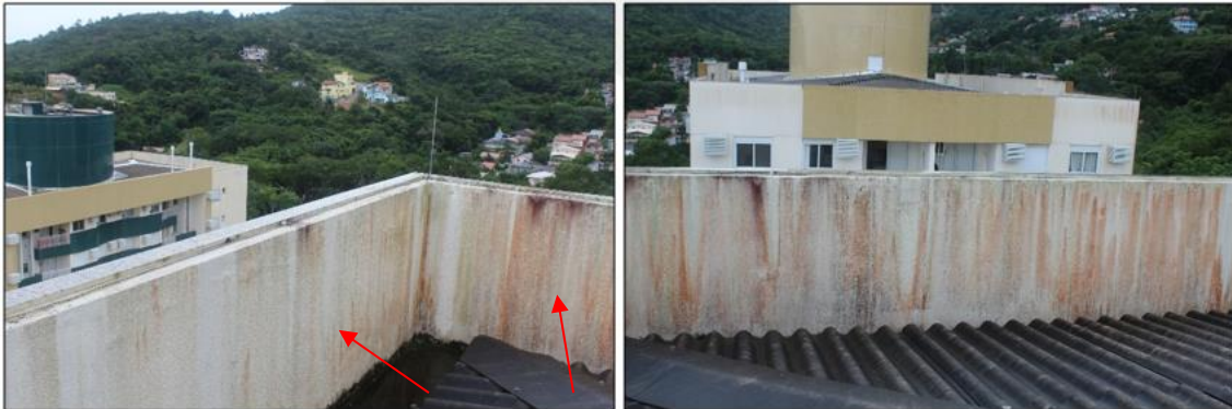
Figura 51: Manchas de umidade nas platibandas.
