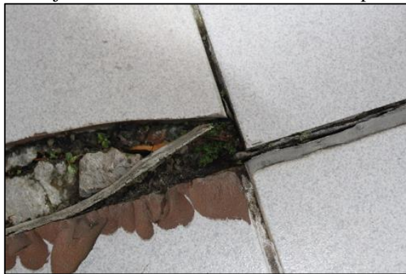
Figura 36: Detalhe das juntas executadas, não atendendo às prescrições normativas.
