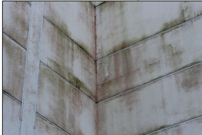
Figura 10: A fachada do estabelecimento comercial apresentava manchas generalizadas.
