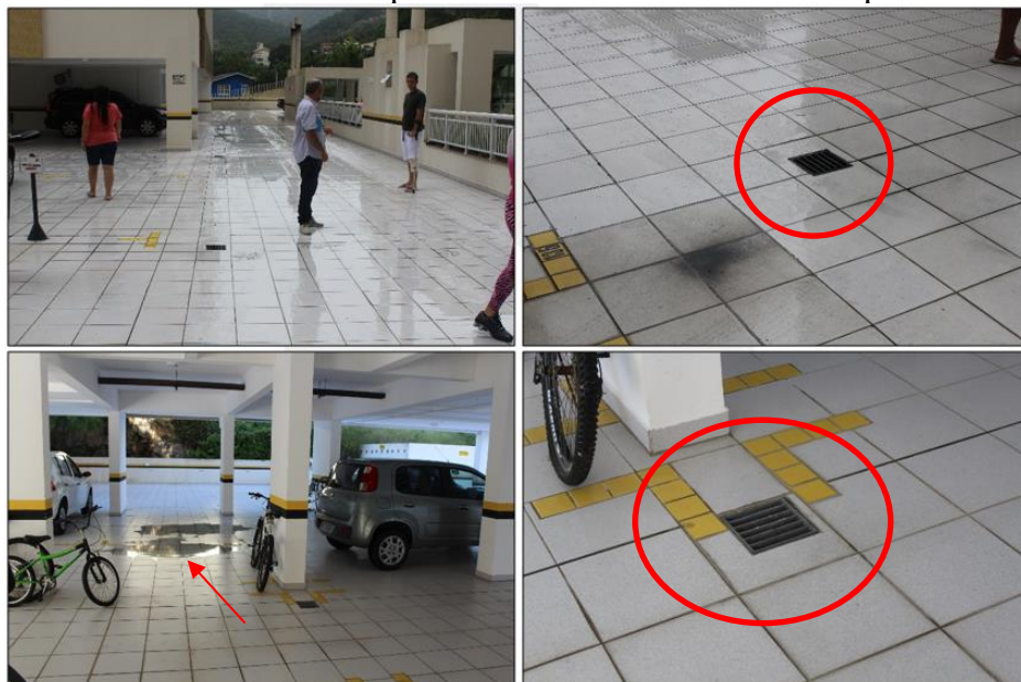
Figura 33: A formação de poças d’água próximas aos ralos demonstra a mal execução dos caimentos do contrapiso. Nota-se também a lisura do piso.
