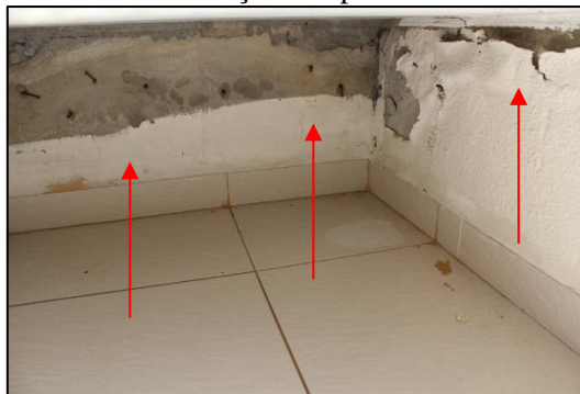
Figura 24: Problemas de infiltração nas paredes da base da churrasqueira.
