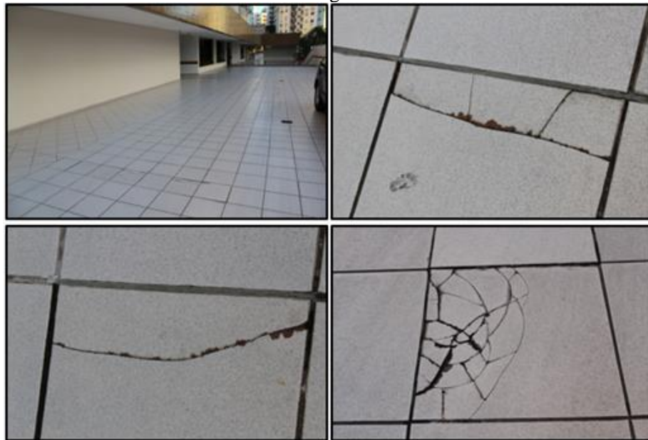
Figura 18: Exemplos de pisos com problemas, na via de acesso a ao Pilotis, ainda no Pavimento Garagem.
