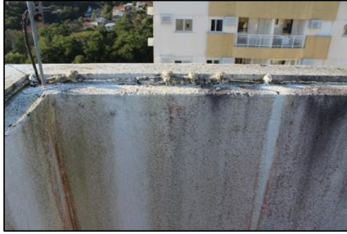
Figura 53: Furos dos ganchos do S.P.D.A.
