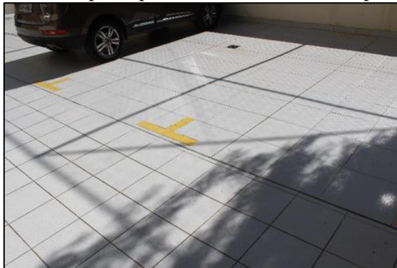
Figura 34: A Construtora retirou o piso das vagas de visitantes para reparar pisos quebrados em outras áreas, colocando outro tipo de piso também com antiderrapância inadequada.
