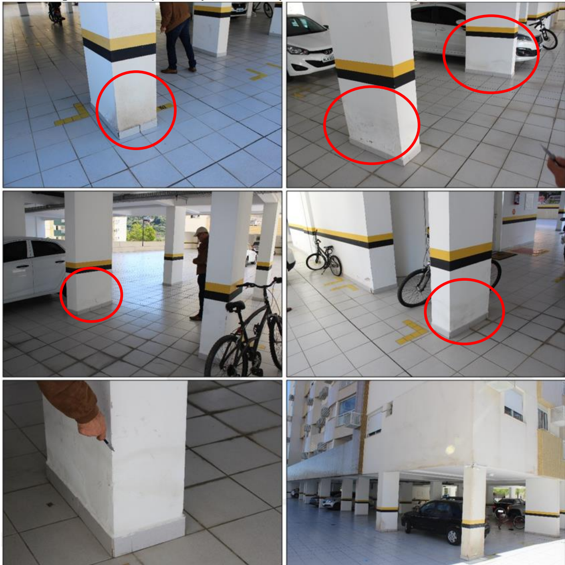
Figura 30: Exemplos de pilares com problemas de infiltração em sua base.
