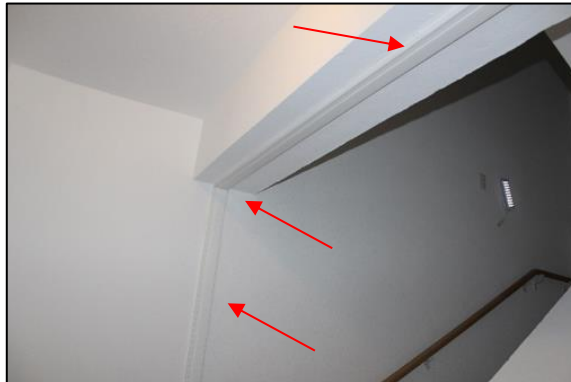
Figura 37: Apenas em um pavimento de um bloco a solução para não se ver as fissuras foi de executar uma vista.
