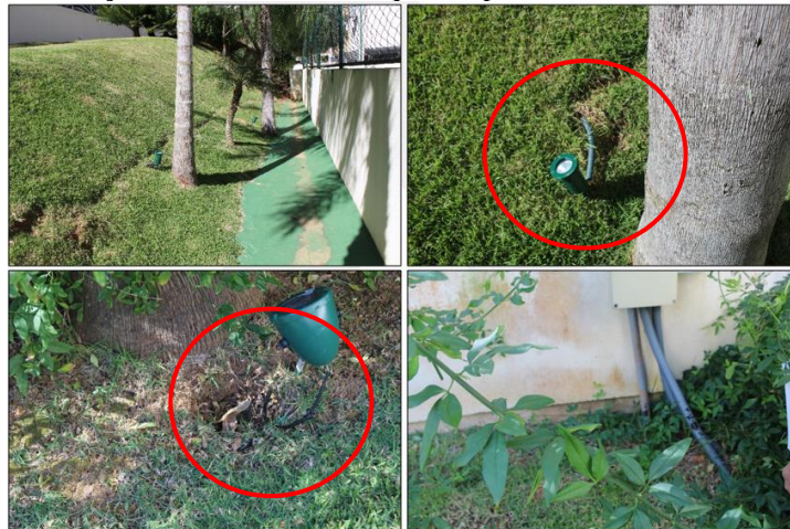
Figura 29: Instalações elétricas não adequadas para áreas externas como o Jardim.
