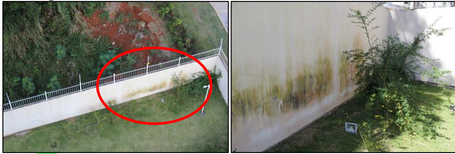
Figura 28: Mancha de umidade ascendente na face interna do muro.
