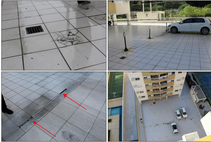
Figura 32: O piso do Pilotis apresenta fissuras generalizadas.
