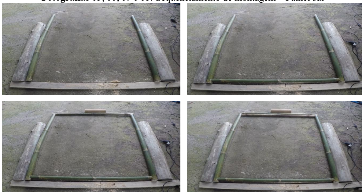
Fotografias 65, 66, 67 e 68: Sequenciamento de montagem – Painel sul
