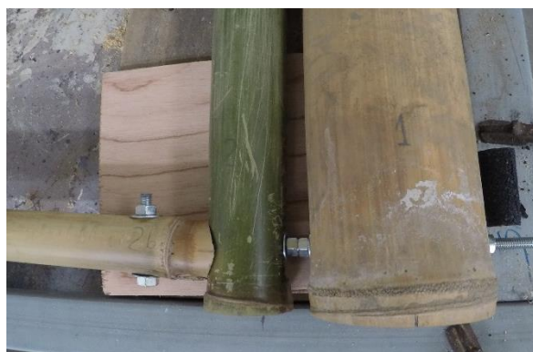
Fotografia 83: Fixação dos elementos inferiores na parte direita do painel
