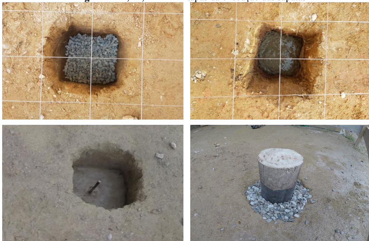
Fotografias 22, 23, 24 e 25: Etapas da execução das sapatas
