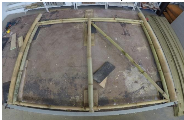
Fotografia 84: Instalação da diagonal no quadrante direito do painel.
