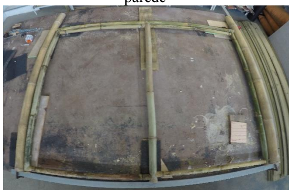
Fotografia 80: Instalação do elemento horizontal que define o limite superior da parede
