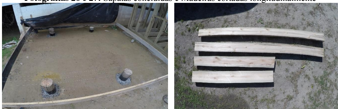
Fotografias 26 e 27: Sapatas concluídas e Madeiras cortadas longitudinalmente
