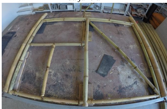
Fotografia 86: Instalação de um bambu vertical centralizado logo abaixo do beiral da janela
