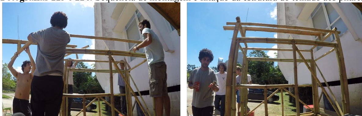
Fotografias 113 e 114: Sequência de montagem e fixação da estrutura do telhado aos pilares
