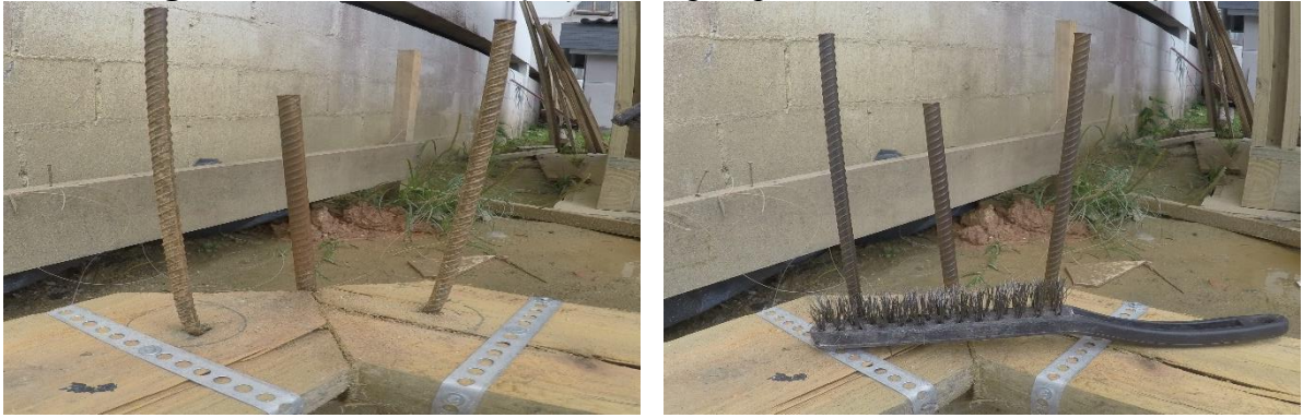
Fotografias 106 e 107: Remoção da ferrugem presente nos ferros da fundação
