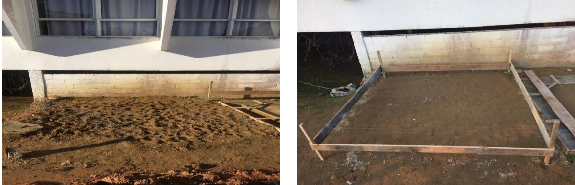
Fotografias 15 e 16: Preparação e compactação do terreno e realização do gabarito
