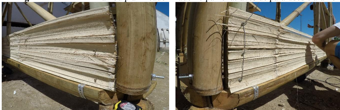
Fotografias 115 e 116: Bambu planificado fixado no painel através de parafusos e arame
