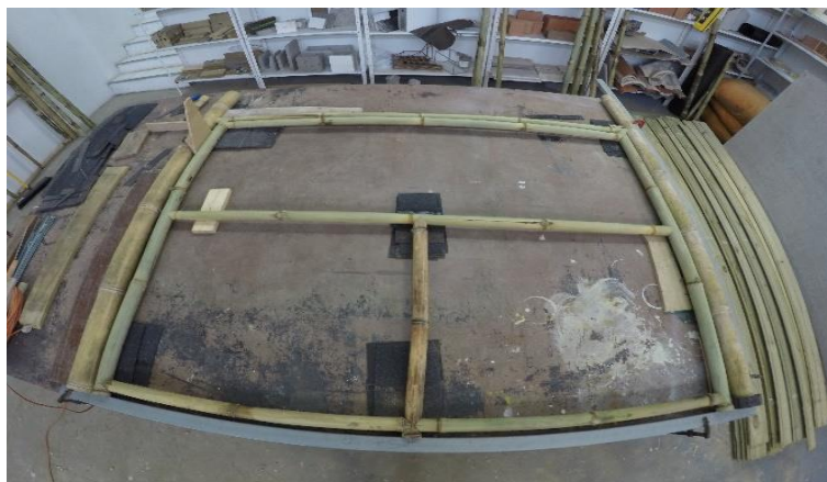
Fotografia 92: Instalação de duas peças horizontais na parte superior do painel. Uma ligando os pilares a 1,50 metros de altura e a outra delimitando o espaçamento entre os bambus verticais vizinhos aos pilares.
