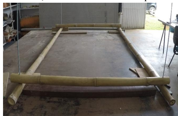
Fotografia 101: Instalação do segundo tirante a 2,00 metros de distância do primeiro
