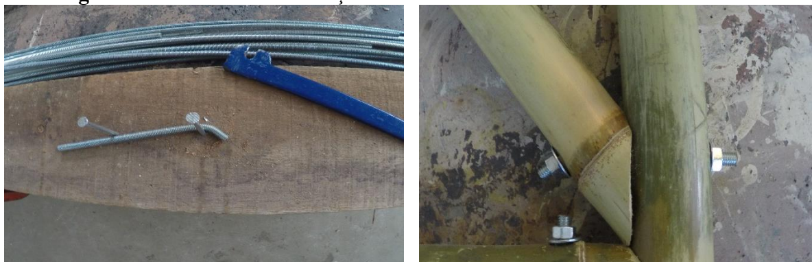
Fotografias 63 e 64: Dobra e fixação do encaixe “bico de flauta” com barra roscada.
