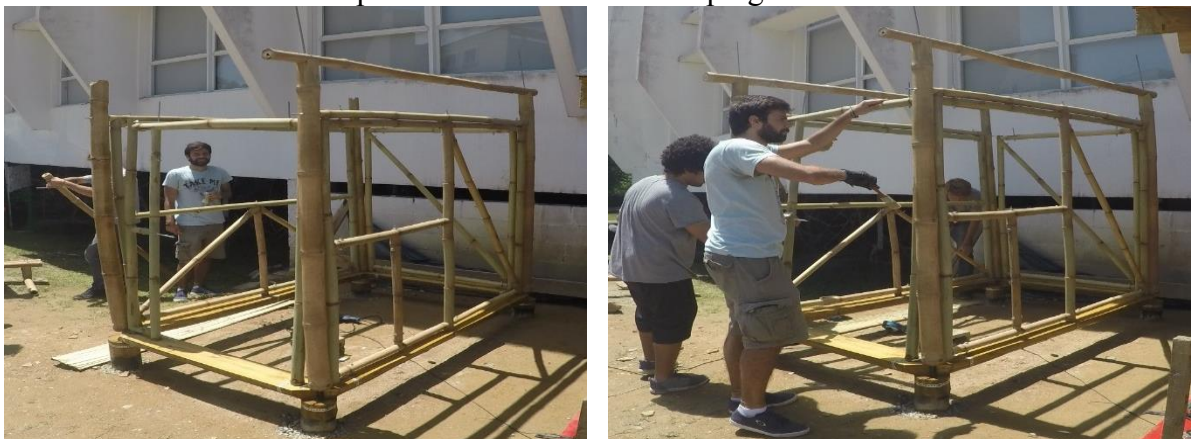
Fotografias 111 e 112: Posicionamento das duas vigas sobre os pilares e aplicação da primeira demão de stein impregnante
