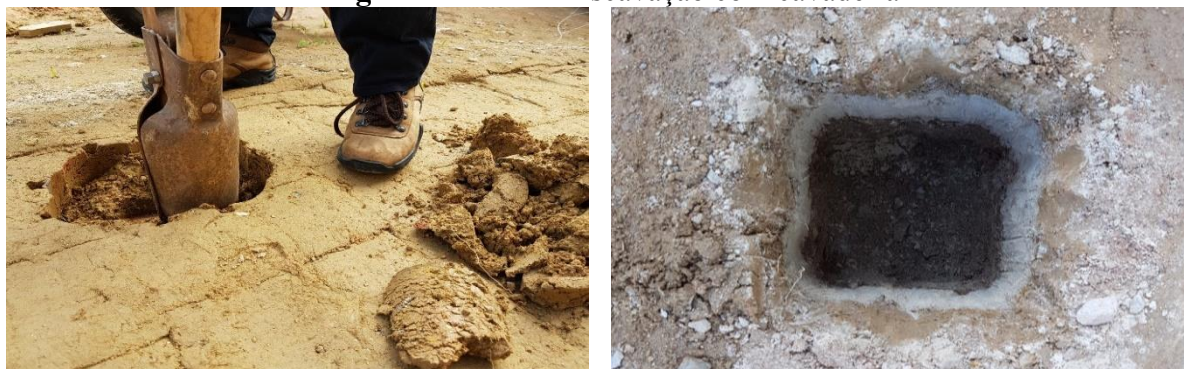
Fotografias 20 e 21: Escavação com cavadeira
