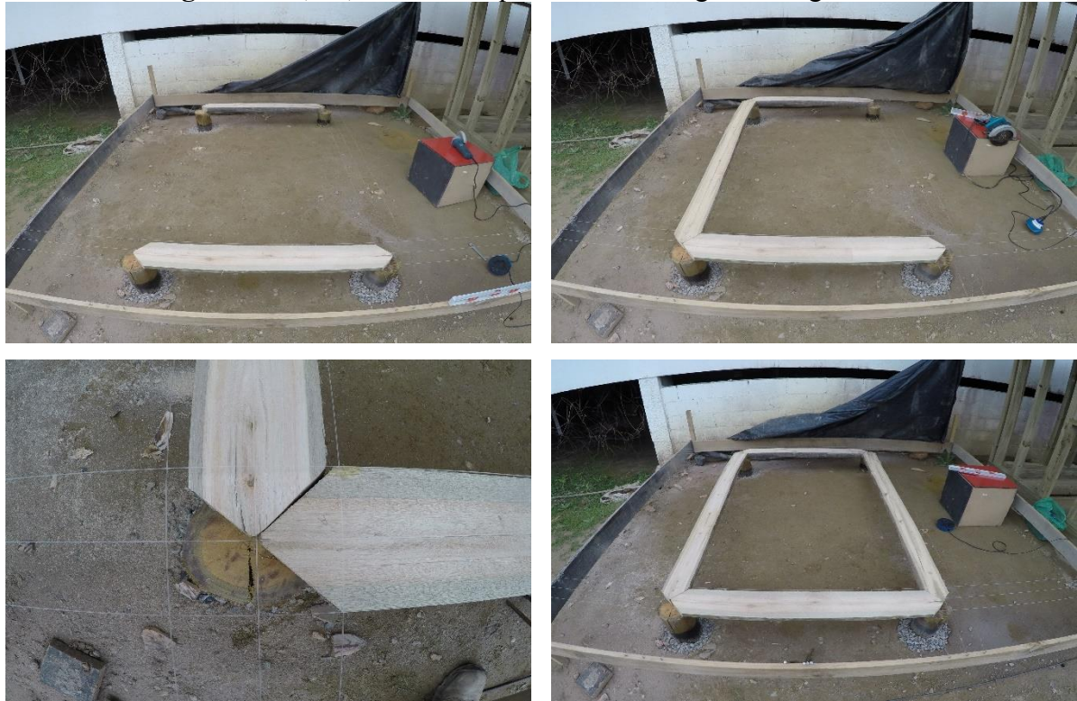
Fotografias 38, 39, 40 e 41: Sequência de montagem da viga baldrame
