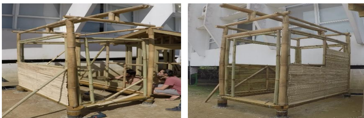
Fotografias 117 e 118: Protótipo em processo de fechamento com bambu planificado
