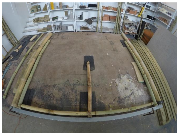
Fotografia 90: Travando a distância de dois metros entre as bases dos pilares com duas peças horizontais
