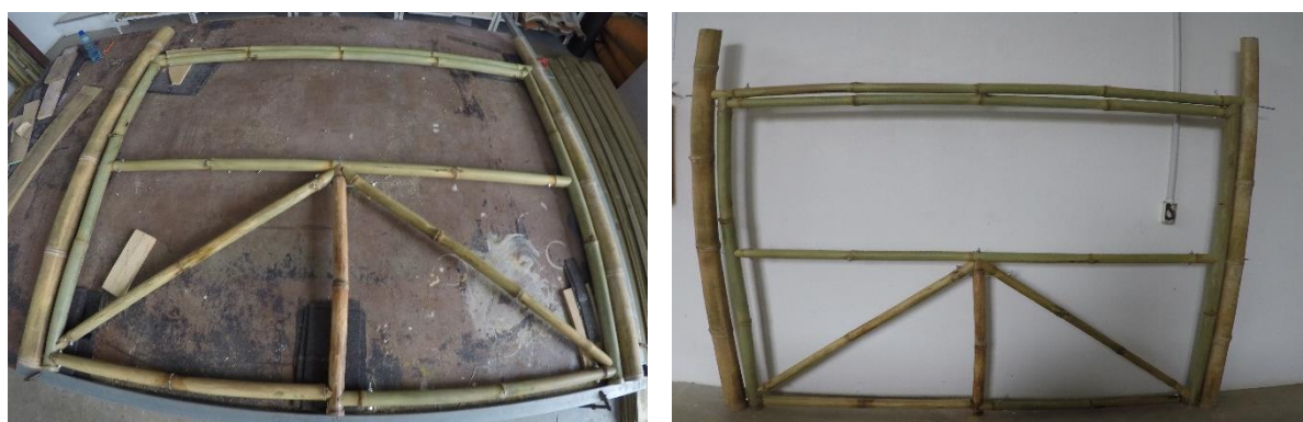
Fotografias 97 e 98: Painel leste pronto após fixação das duas diagonais do projeto
