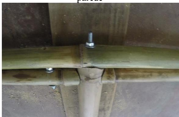
Fotografia 82: Fixação dos elementos horizontal que define o limite superior da parede
