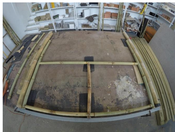
Fotografia 91: Posicionando o beiral da janela com 0,80 metros de altura
