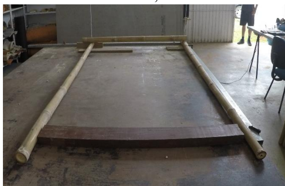
Fotografia 100: Vigas paralelas e tirante travando a medida de 1,20 metro entre elas
