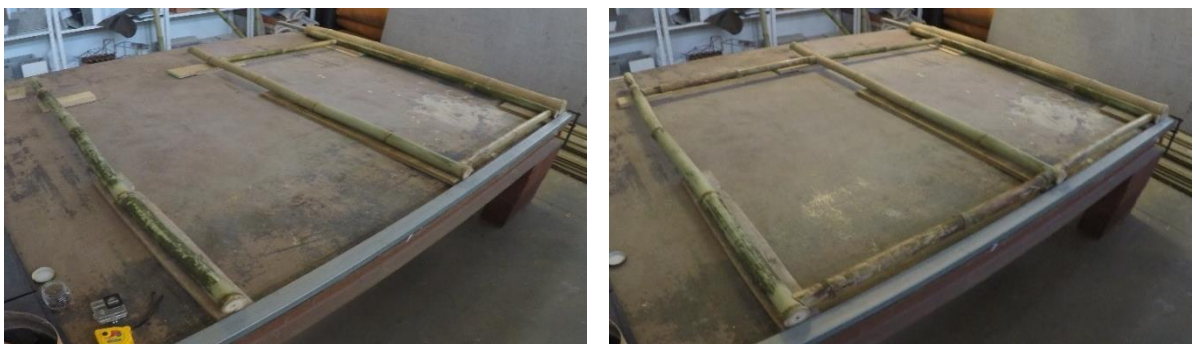
Fotografias 78 e 79: Sequência de montagem do lado esquerdo do painel
