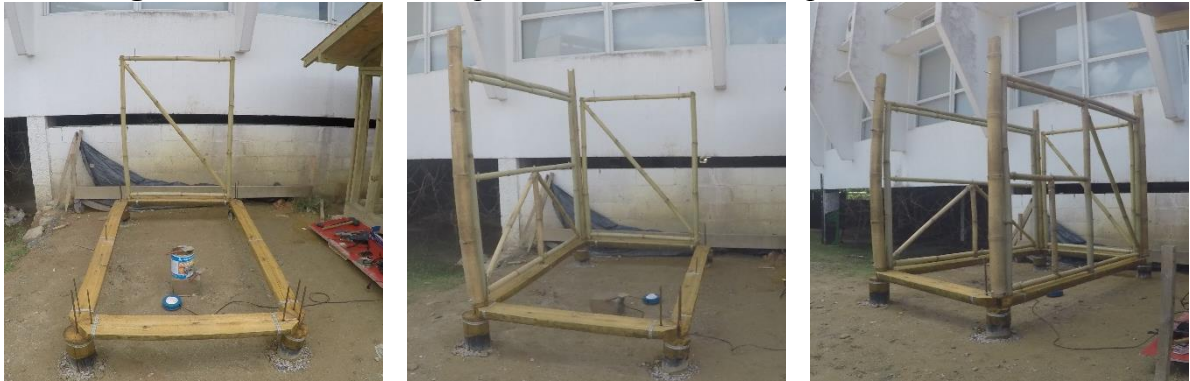
Fotografias 108,109 e 110: Sequência de montagem dos painéis sul, leste e oeste.
