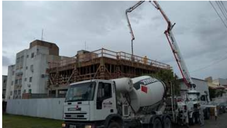
Imagem 1: Concretagem do segundo pavimento tipo.
