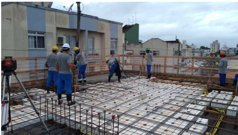
Imagem 2: Serviço de concretagem do segundo pavimento tipo
