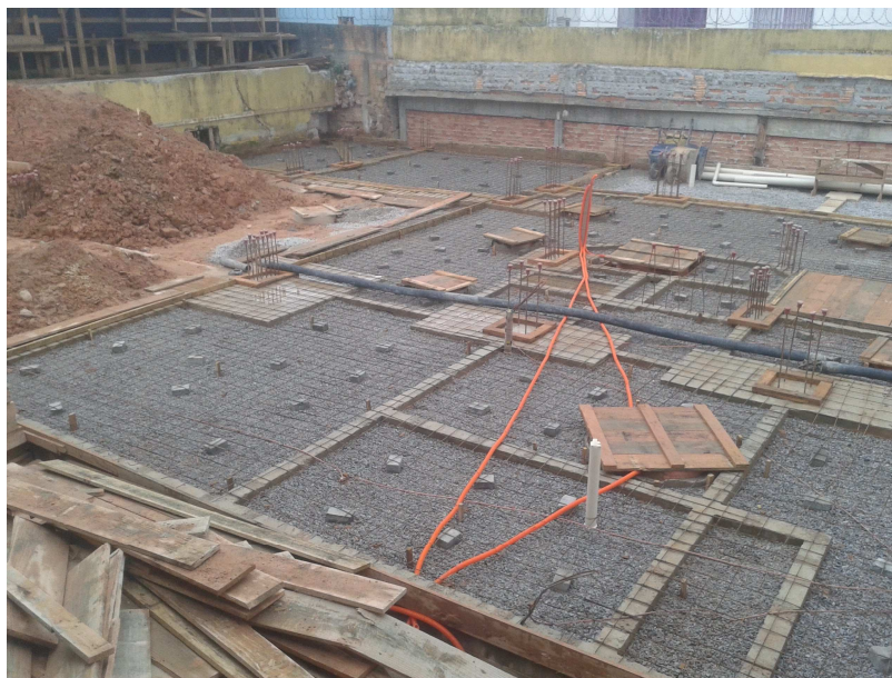
Imagem 3: Execução da etapa 03.
