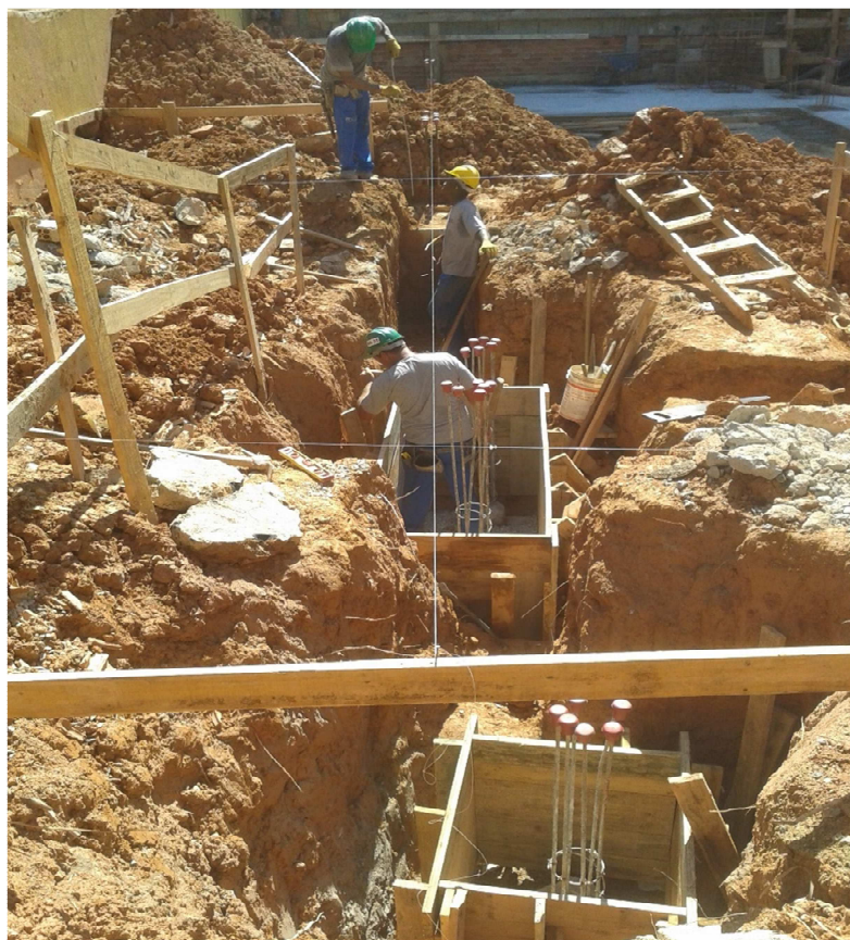
Imagem 5: Formas para execução da etapa 04.
