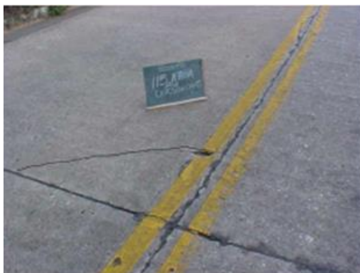
Figura 7 - Fissuras de canto
