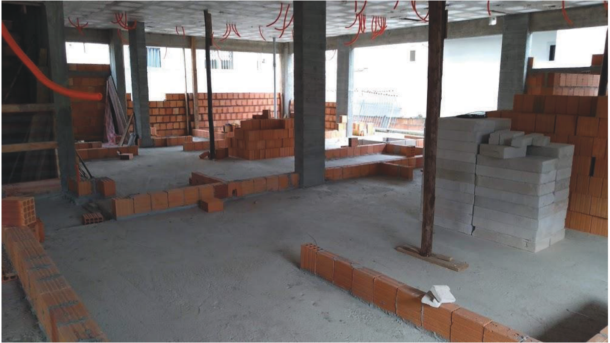
FIGURA 43 – ALVENARIA DO TÉRREO SENDO EXECUTADA
