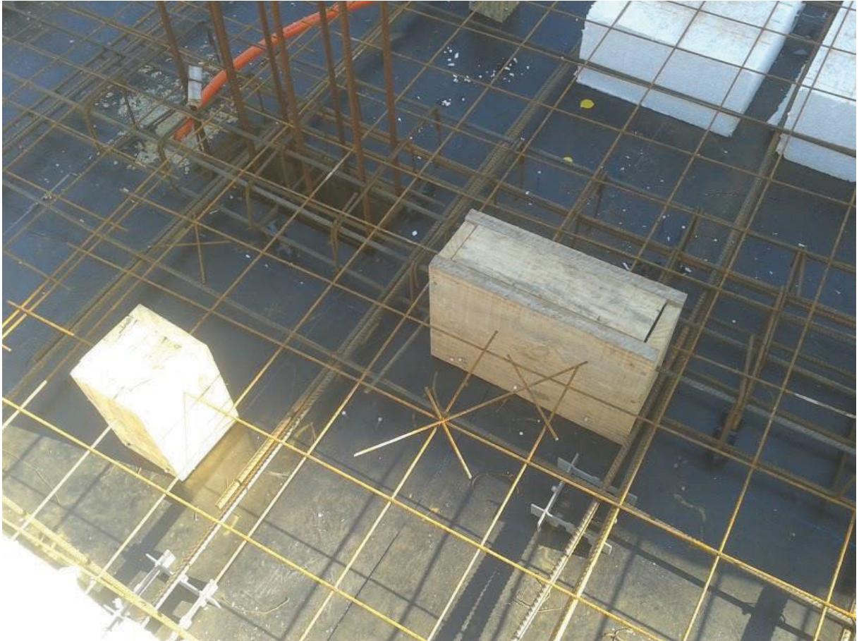
FIGURA 53 – CAIXAS DE PASSAGENS ESTRUTURAIS POSICIONADAS PARA CONCRETAGEM
