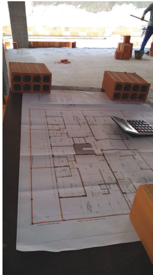
FIGURA 47 – UTILIZAÇÃO DA PRACHA DE EXECUÇÃO EM OBRA
