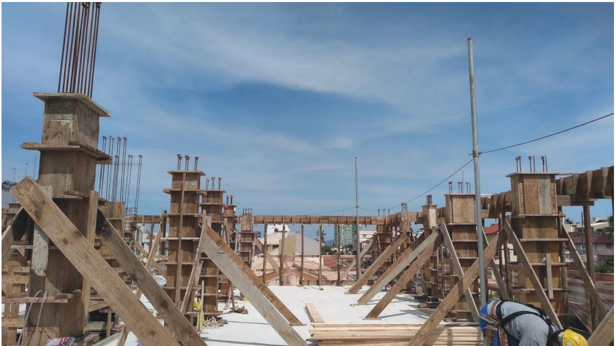
FIGURA 49 – ESTRUTURA DE FORMAS EM OBRA
