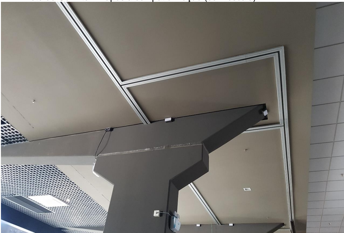
Figura 74 – Foto do Conflito B1 após a compatibilização (sem escala)
