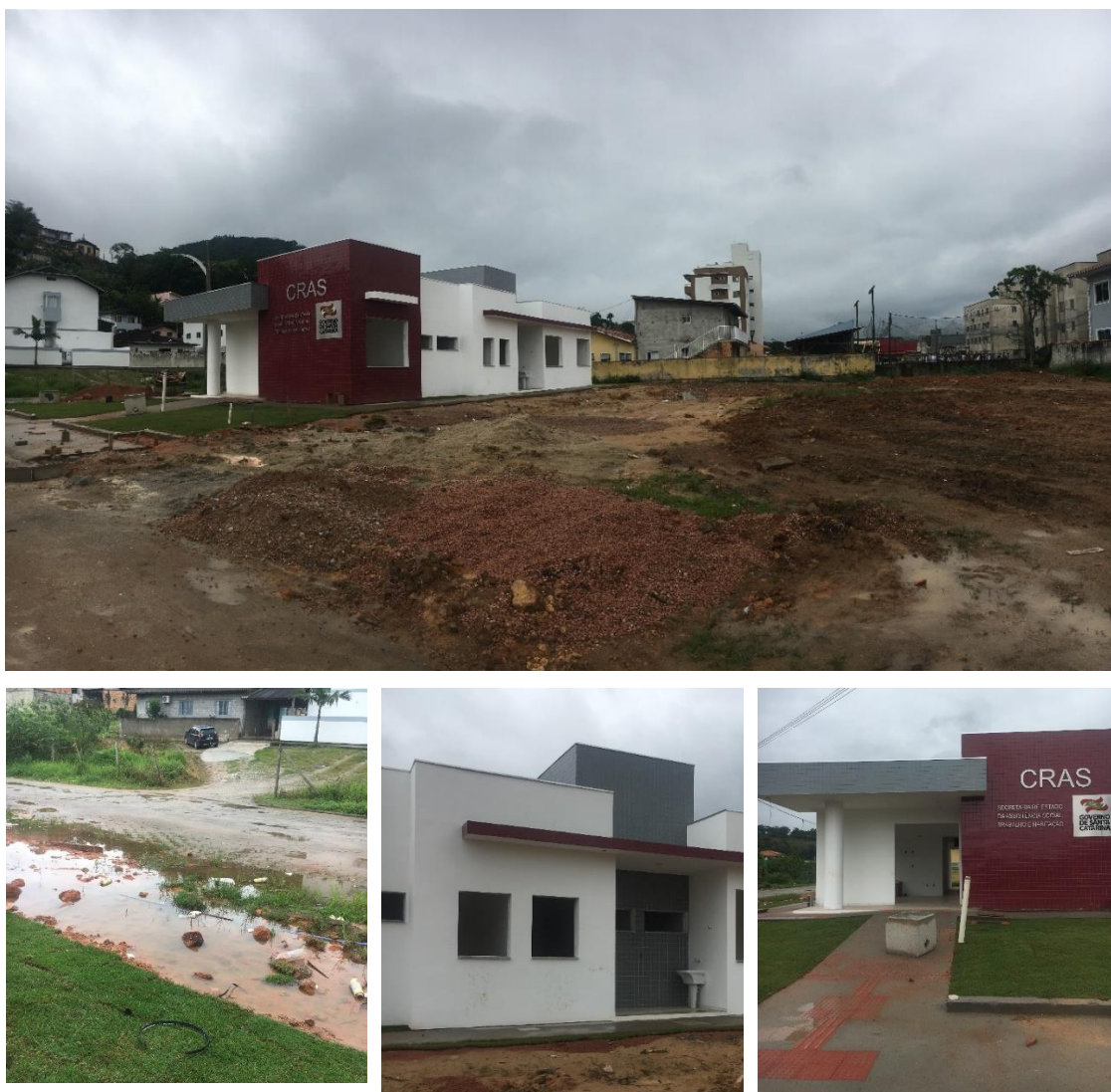
Figura 20 - Obra do CRAS de Biguaçu – 03 de outubro de 2018
