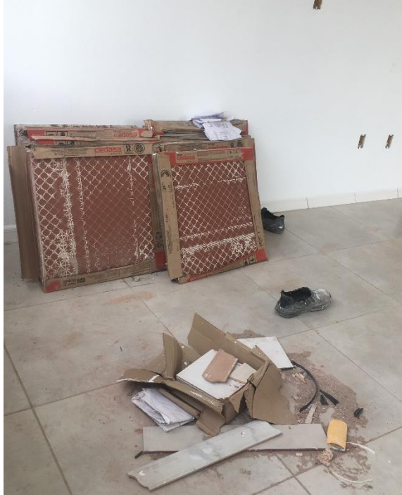
Figura 25 - Sobras de pisos cerâmicos e resíduos gerados no assentamento de uma sala
