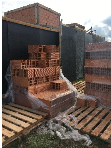
(d) Armazenamento de blocos cerâmicos
