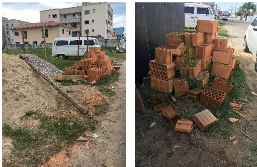
Figura 12 - Armazenamento dos tijolos cerâmicos fora dos pallets
