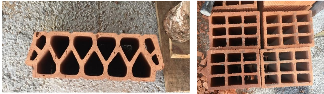
Figura 10 - Tijolo utilizado em obra para as tabelas (a) e para a alvenaria (b) (9 furos)
