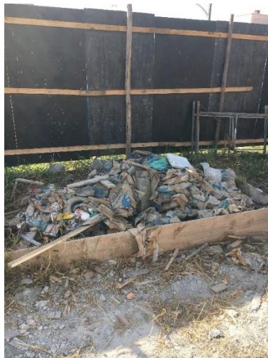
(a) Descarte de sacos de cimento
