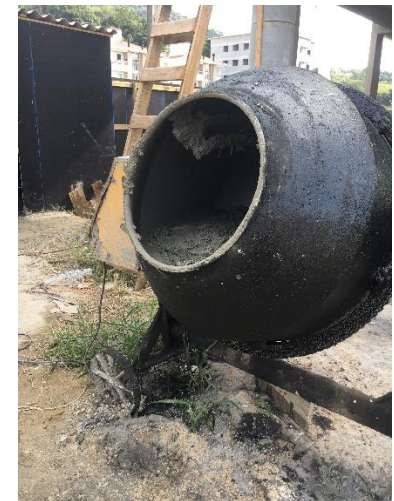
(f) Produção de concreto em obra
