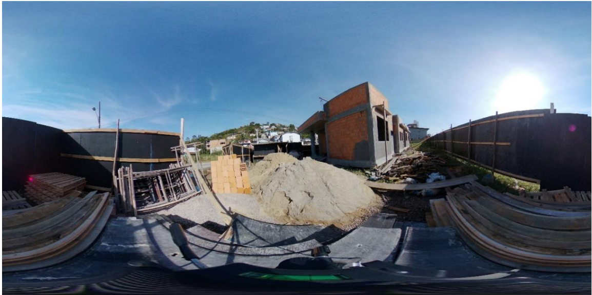
Figura 23 - Disposição de materiais no canteiro de obras
