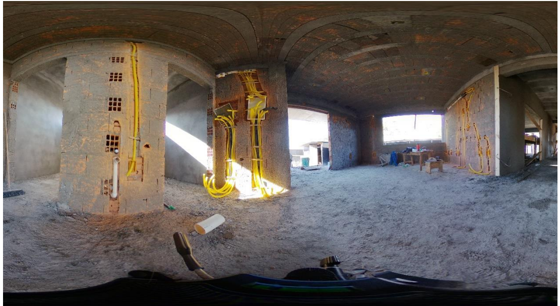
Figura 15 - Execução da alvenaria em obra
