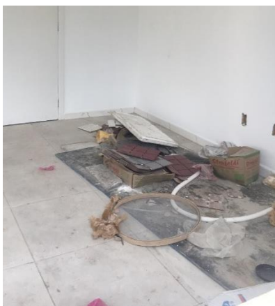
Figura 24 - Resíduos da obra após finalização
