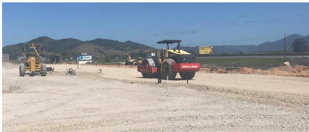
Figura 39 – Nivelamento e compactação da base
