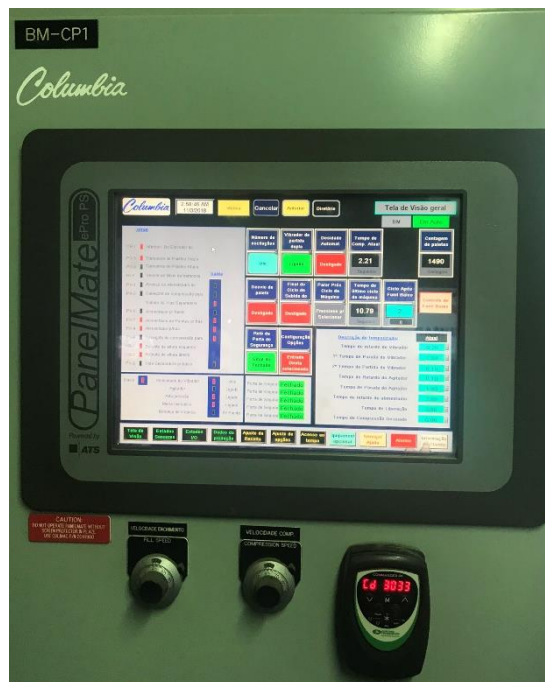
Figura 18 – Central de controle da vibroprensa marca Columbia
