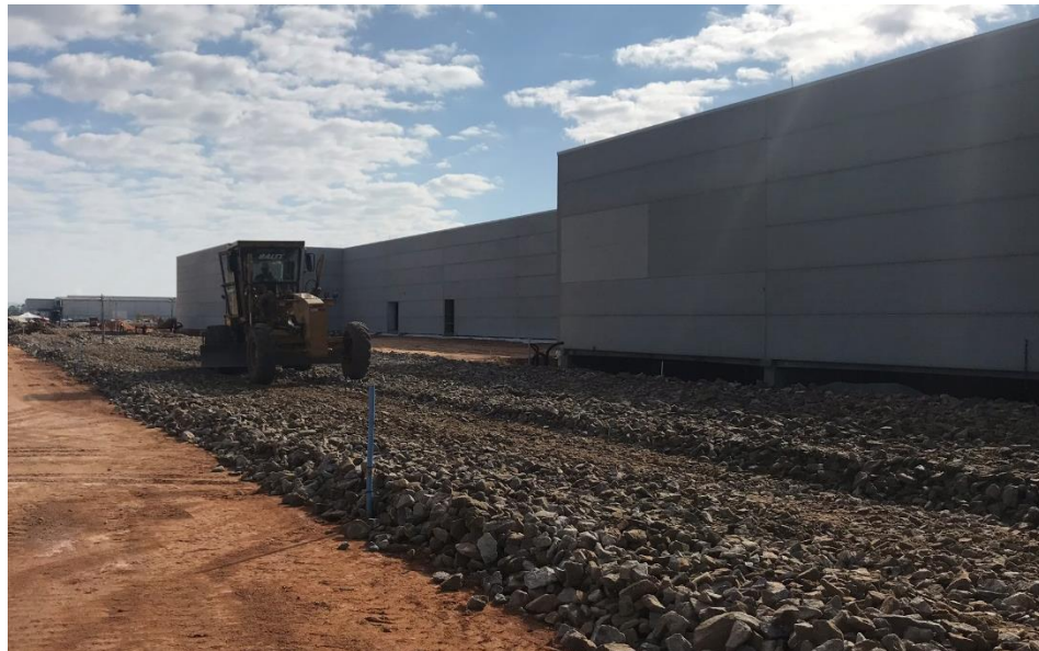
Figura 38 – Nivelamento da sub-base
