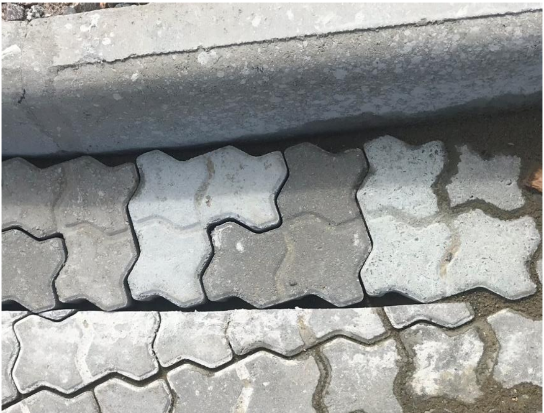
Figura 57 – Arremates com pedaços muito pequenos de blocos
