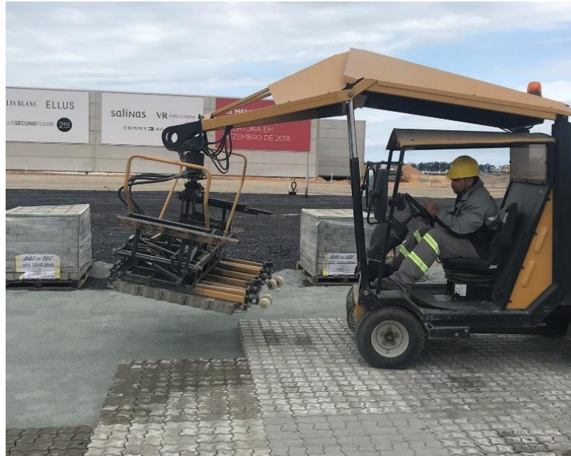
Figura 53 – Assentamento dos pavers “L” com a máquina pavimentadora
