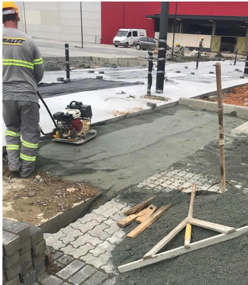
Figura 47 – Compactação da camada de assentamento
