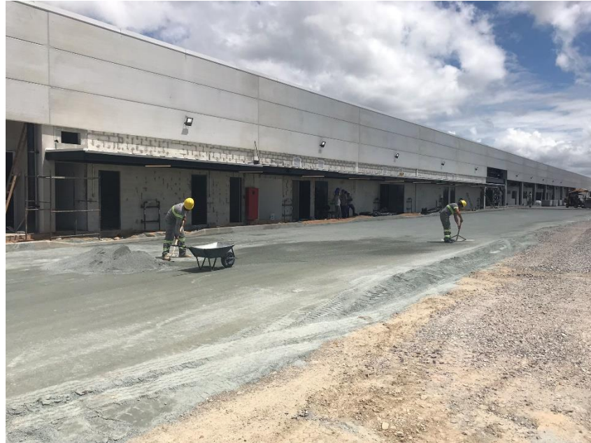
Figura 48 – Espalhamento manual da camada de assentamento
