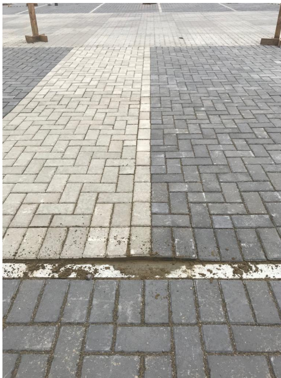
Figura 63 – Desnível maior do que 10mm
