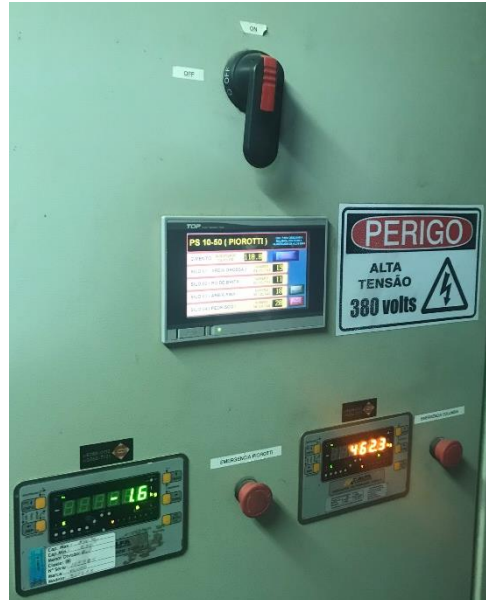
Figura 19 – Central de comando da vibroprensa marca Piorotti
