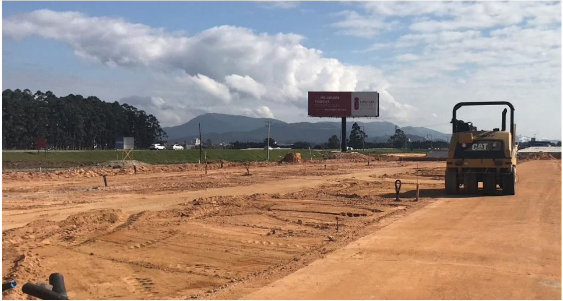
Figura 36 – Compactação do subleito
