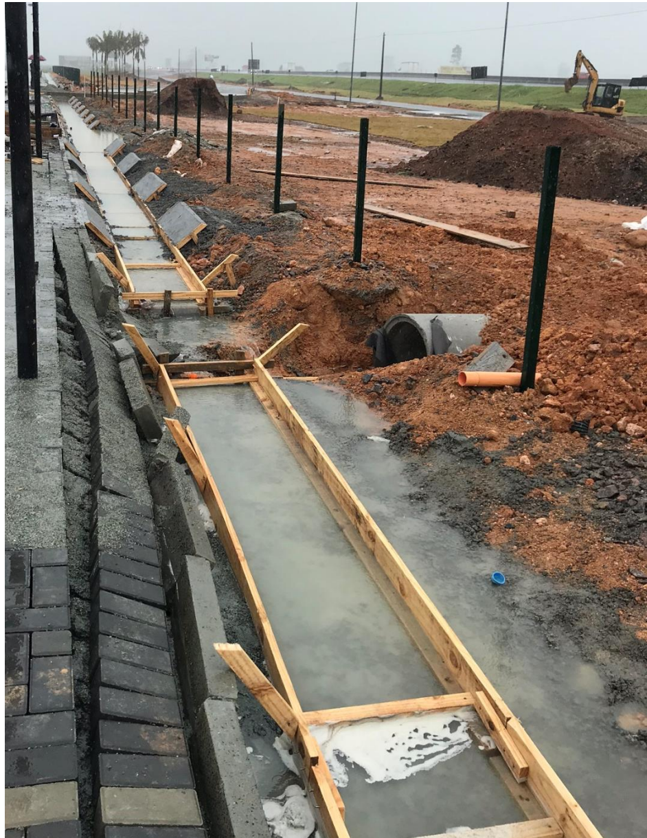
Figura 37 – Desbarrancamento do meio fio devido à escavação de valas para canaletas de drenagem
