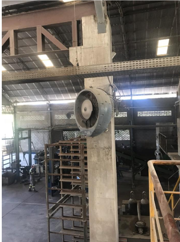
Figura 20 – Ventiladores aspersores de água na fábrica
