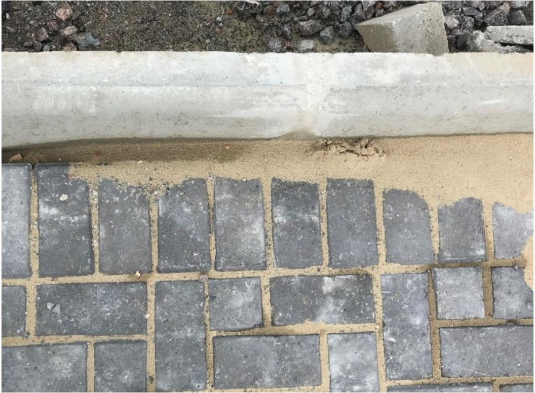
Figura 56 – Acabamento com preenchimento com areia de rejuntamento
