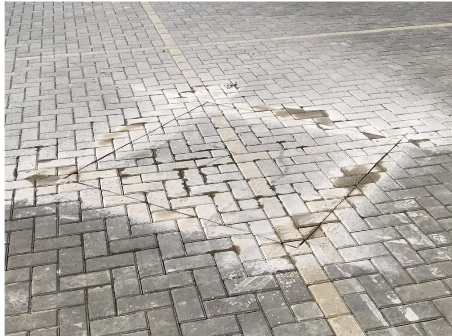
Figura 42 – Corte dos blocos já assentados para a instalação de contenções internas
