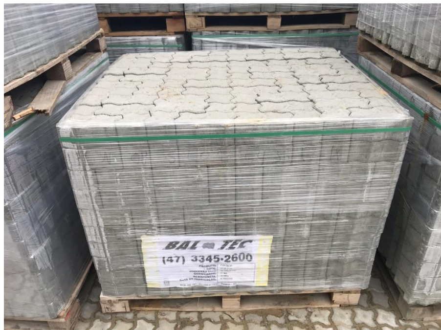
Figura 52 – Estoque de paletes de blocos na obra
