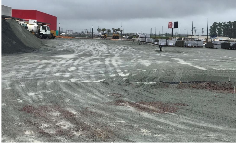
Figura 44 – Contaminação da camada de assentamento
