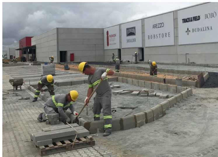
Figura 41 – Instalação das contenções laterais
