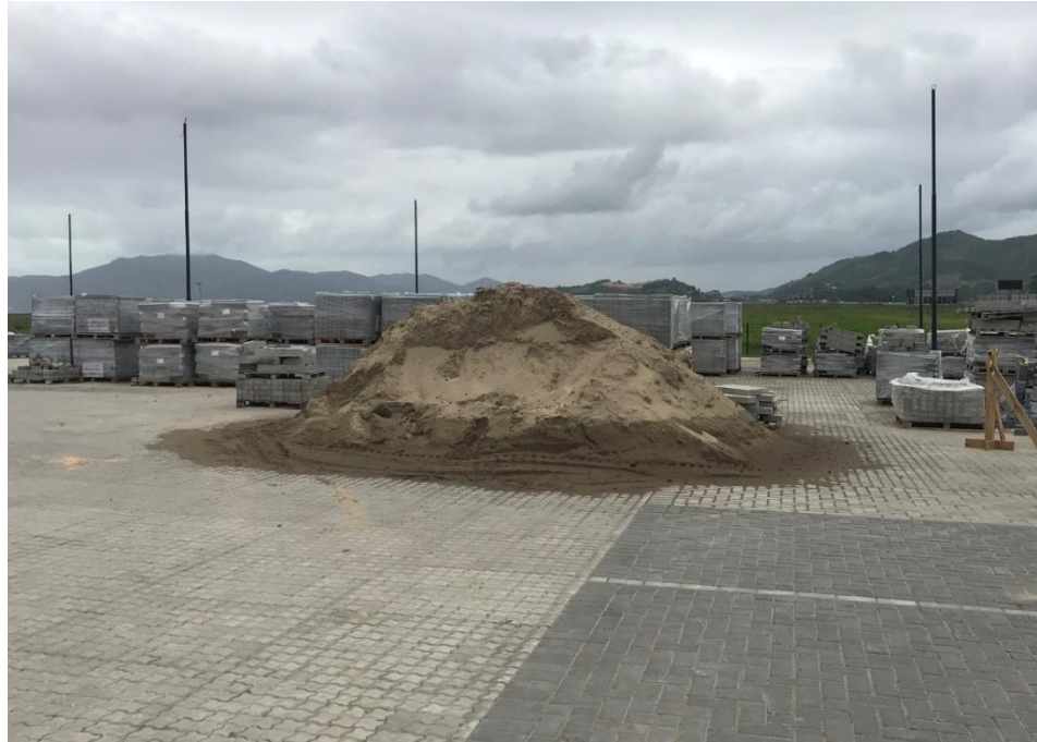
Figura 59 – Estoque de areia de rejuntamento ao ar livre
