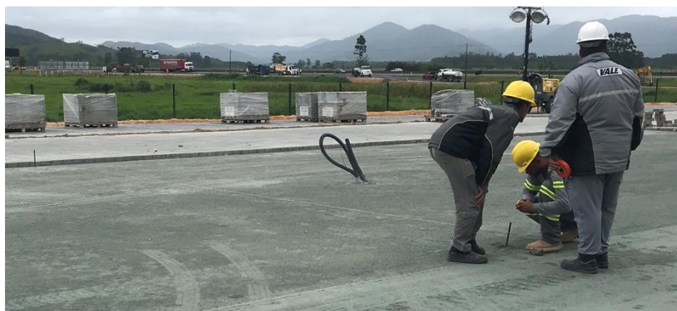
Figura 54 – Colocação de linhas-guia
