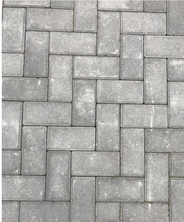
Figura 62 – Juntas parcialmente preenchidas
