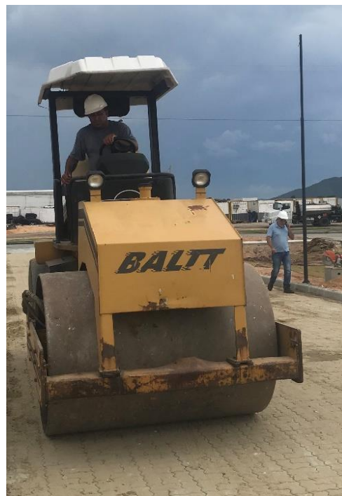
Figura 58 – Compactação com rolo compactador
