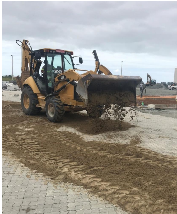
Figura 60 – Espalhamento do material de rejuntamento com retroescavadeira
