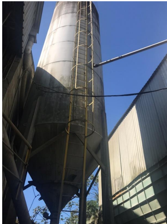
Figura 5 – Silo de armazenamento de cimento
