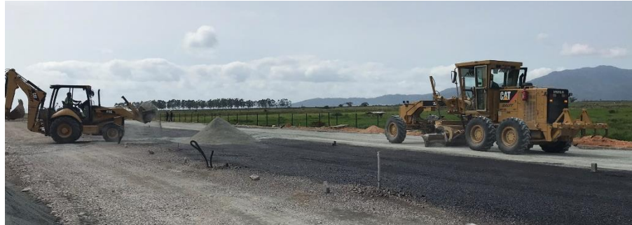
Figura 46 – Nivelamento do material de assentamento por motoniveladora
