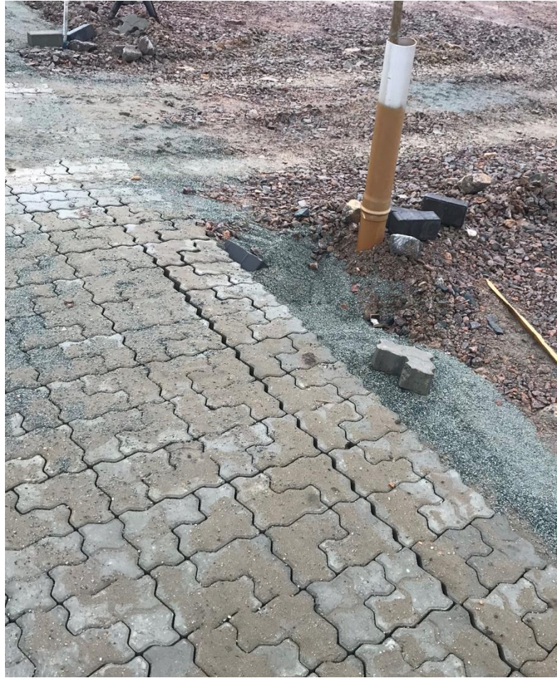
Figura 43 – Peças abertas e torcidas devido à circulação de tráfego sem travamento
