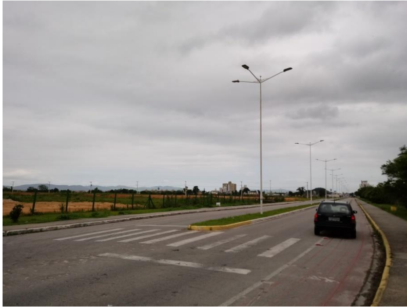
Figura 6: Extensão da Rua Bento dos Santos. Infraestrutura disponível – pavimentação, meio fio e ciclovia.
