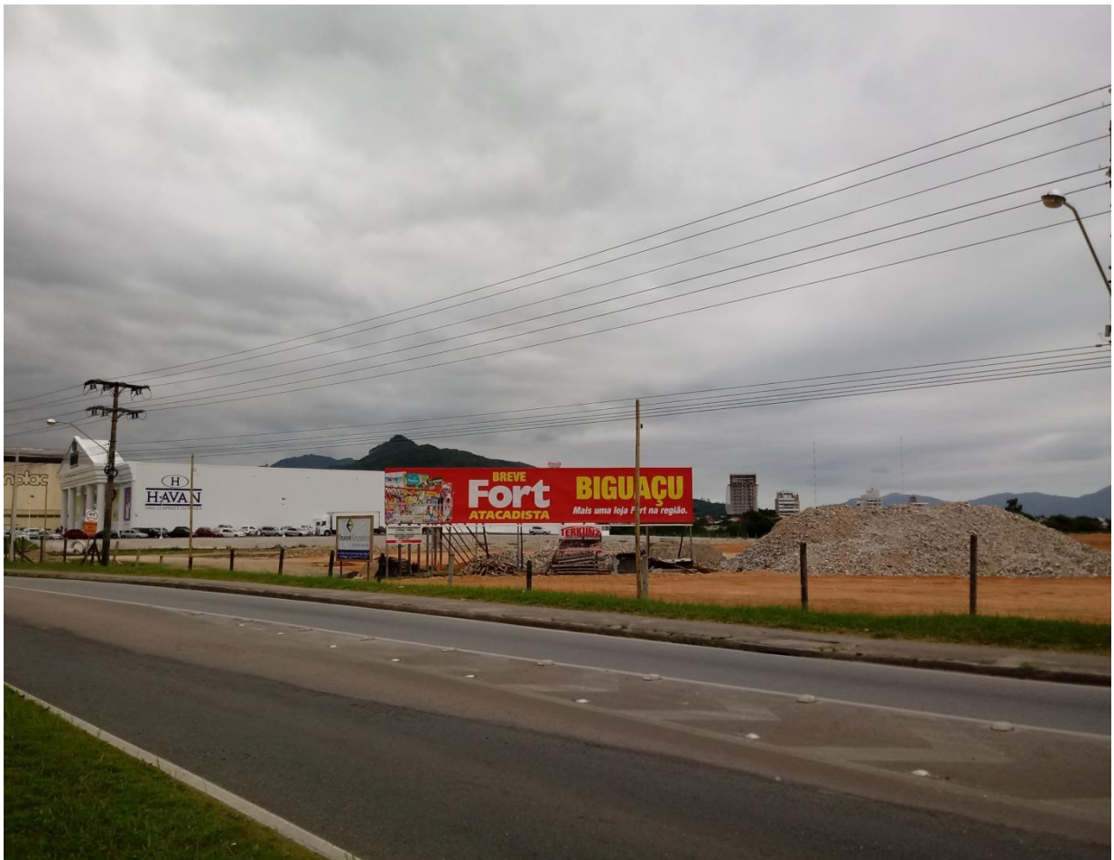
Figura 14: Megaloja Havan e obras de instalação do empreendimento Fort Atacadista, Biguaçu/SC.
