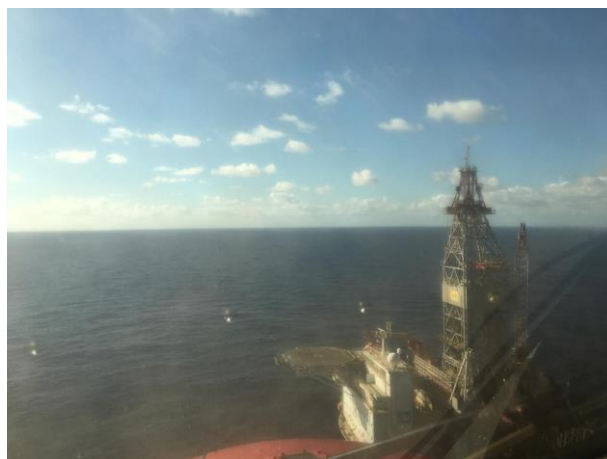
Figura 25- Helideck com boa altura vertical em relação ao mar
