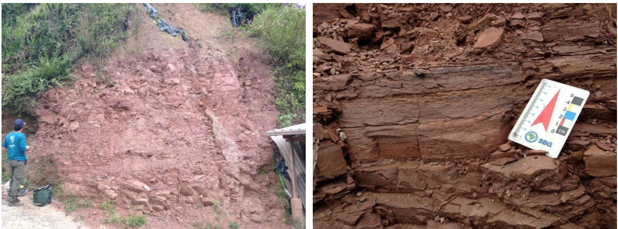
Figura 25: à esquerda, afloramento de siltito, com intercalações de arenito fino. Notar a proximidade do talude com a casa do lado direito e a grande inclinação do mesmo. À direita, detalhe do siltito avermelhado laminado (PNE034).
