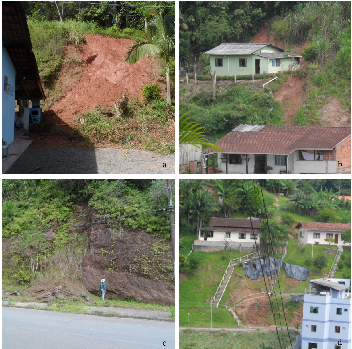
Figura 40: a) PNE001 - deslizamento translacional, observar a superfície de ruptura plana; b) PNE002 - deslizamento translacional próximo a casas; c) PNE030 - deslizamento em cunha condicionado por fraturas de direção N-S e NE-SW; d) PNE001 - rastejo em taludes artificiais, protegidos da chuva por lonas.
