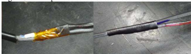
Figura 9 – Fixação dos sensores térmicos nos cabos elétricos.
