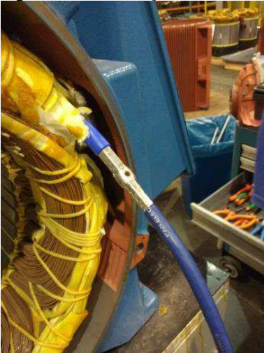
Figura 19 – Substituição dos cabos de ligação do Motor 3.
