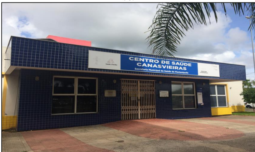
Figura 8 - Centro de Saúde do bairro Canasvieiras, município de Florianópolis, SC.
