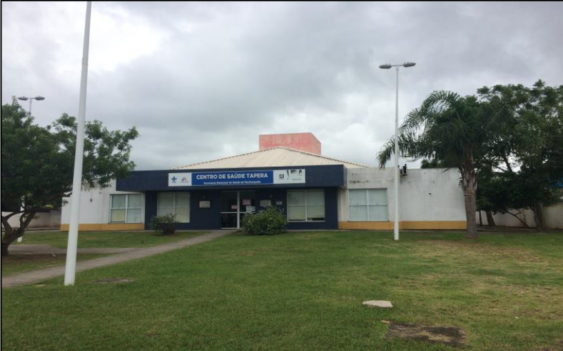
Figura 10 - Centro de Saúde no bairro Tapera, município de Florianópolis, SC.
