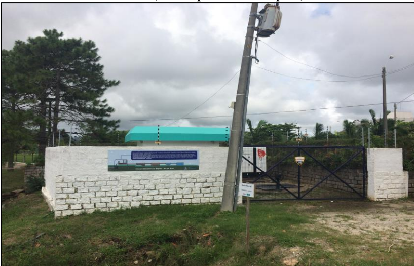
Figura 13 - Estação elevatória de esgoto ao lado do rio do Braz, bairro de Canasvieiras, município de Florianópolis, SC.
