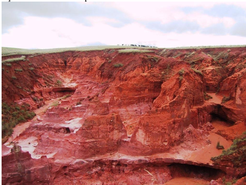
Figura 4 - Voçoroca de grandes dimensões com afloramento do lençol freático no município de São Francisco de Assis/RS.
