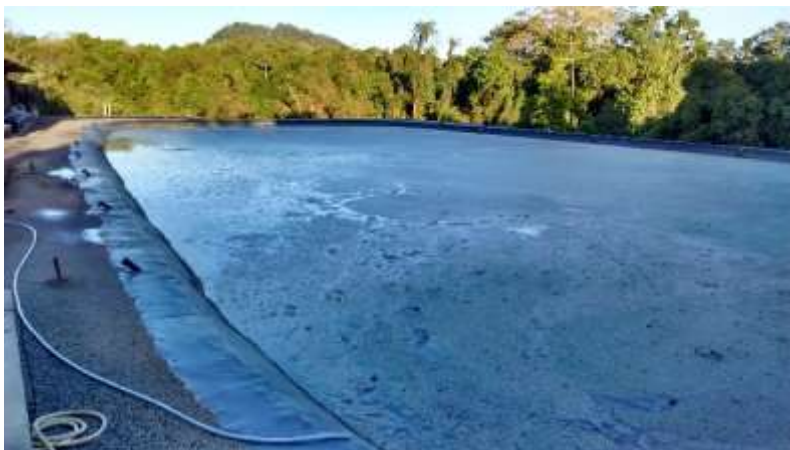
Figura 22 – Tratamento secundário: lagoa de polimento (16/07/16).
