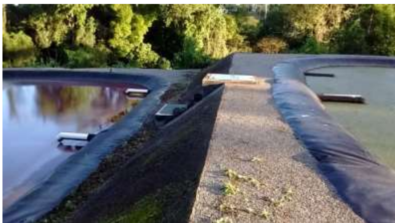
Figura 21 – Lagoa facultativa anaeróbia (direita) e lagoa de polimento (esquerda), com caixa de passagem entre as mesmas (16/07/16).
