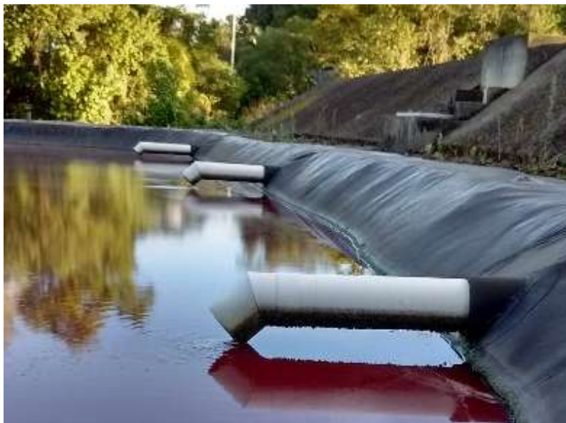
Figura 24 – Detalhe da entrada do efluente na lagoa de polimento (após lagoa facultativa anaeróbia) (16/07/16).
