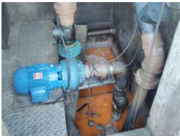
Figura 11– Poço de bombeamento (26/01/17).
