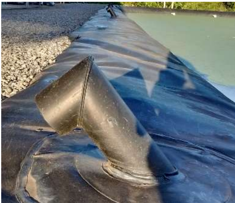
Figura 25 – Detalhe da manta geotêxtil, presente em ambas as lagoas e detalhe da canalização de exaustão de ar para instalação (16/07/16).
