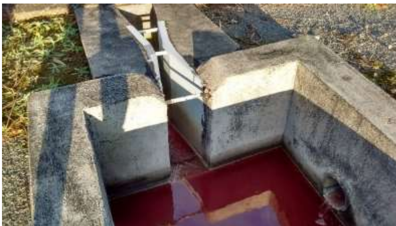
Figura 26 – Calha Parshall presente ao final do tratamento (16/07/16).
