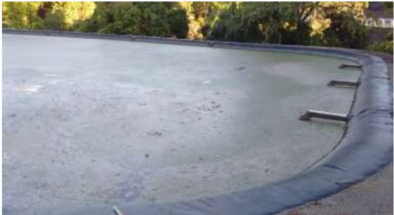
Figura 17 – Tratamento secundário: lagoa anaeróbia (16/07/16).
