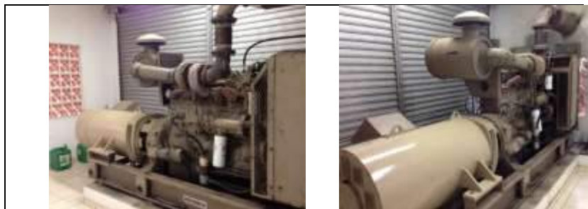
Figura 36 – Gerador de energia WEG com motor Cummins, de capacidade nominal 450 KVA.
