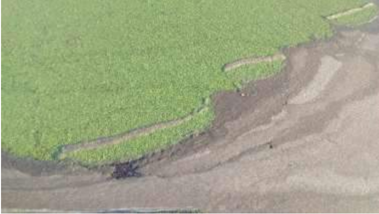
Figura 18 – Detalhe da lagoa anaeróbia, com presença de espuma e algas (16/07/16).
