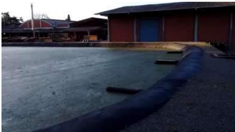
Figura 20 – Saída do efluente da lagoa anaeróbia por meio de três tubulações (16/07/16).
