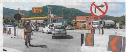
Policial rodoviário fiscaliza e controla o trânsito na obra do elevado
