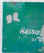
Igrejinha da UFSC (ao lado) e detalhe da assinatura de Hassis na obra que nunca passou por uma restauração (abaixo)
