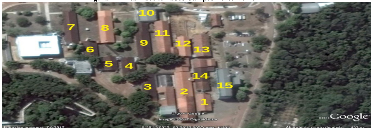
Figura 2 –Área 1 dos telhados Campus Porto Velho
