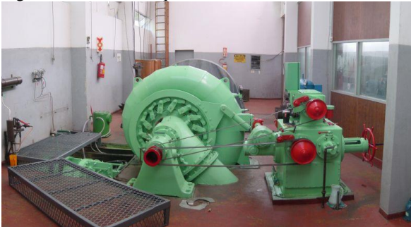
Figura 3 - Casa de máquinas.
