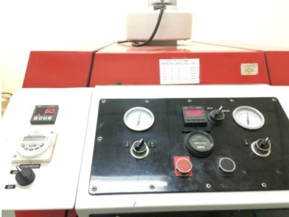
.Figura 7.34 - Temperatura das placas medida a partir do sensor
