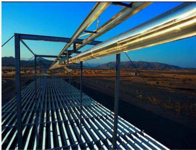
Figura 2.6: Planta com tecnologia de Fresnel
