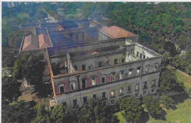
O prédio do Museu Nacional, no Rio de Janeiro, praticamente foi todo destruído pelo fogo
