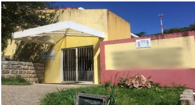
Figura 17 – Fotografia do acesso principal da escola
