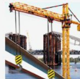
ponte construção iPlay Studio
