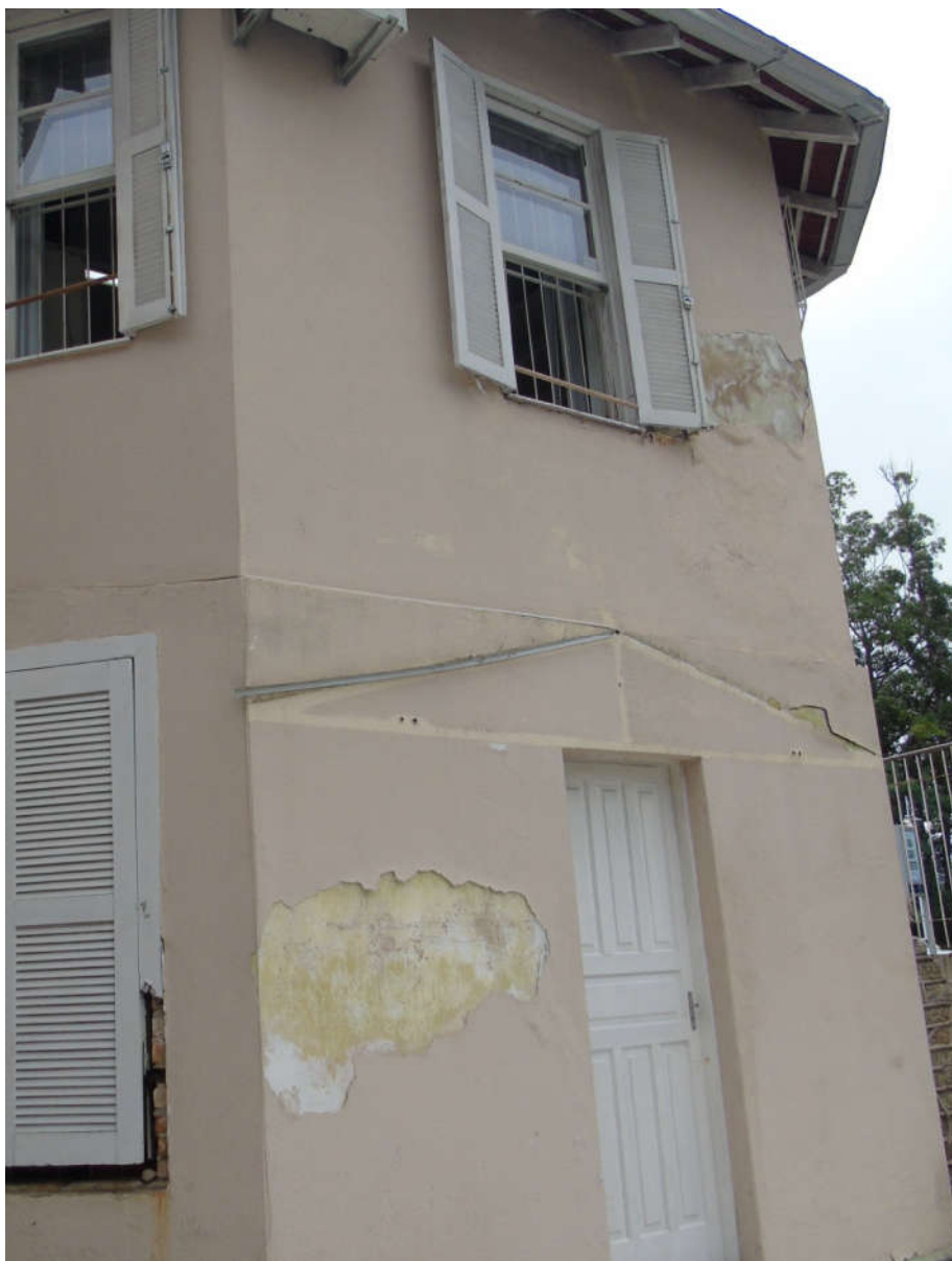
Figura 40: Pintura danificada em toda a fachada leste, foto da parte próxima à fachada norte
