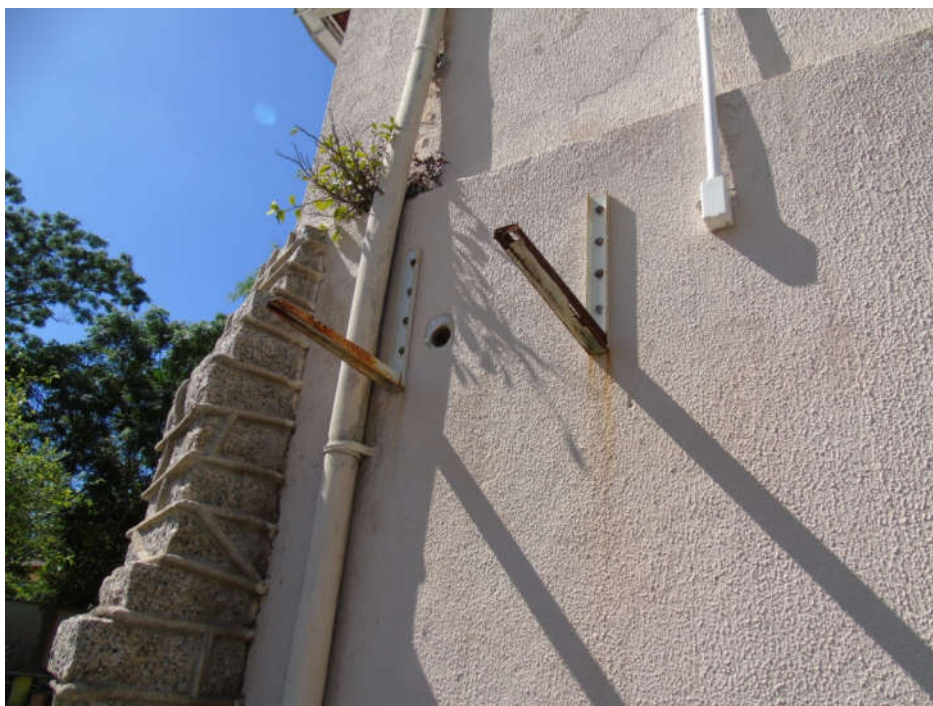
Figura 17: Pilar de pedra e dente entre viga e alvenaria
