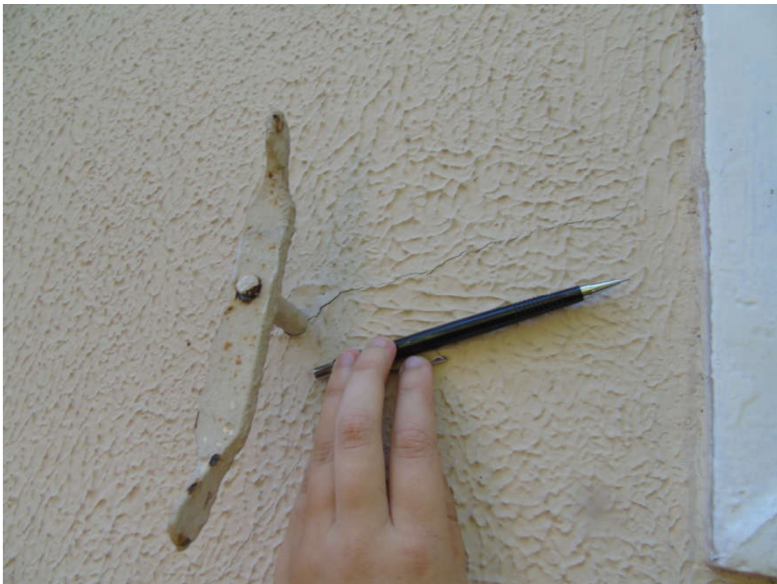
Figura 20: Fissura partindo de trava com pontos de ferrugem da veneziana
