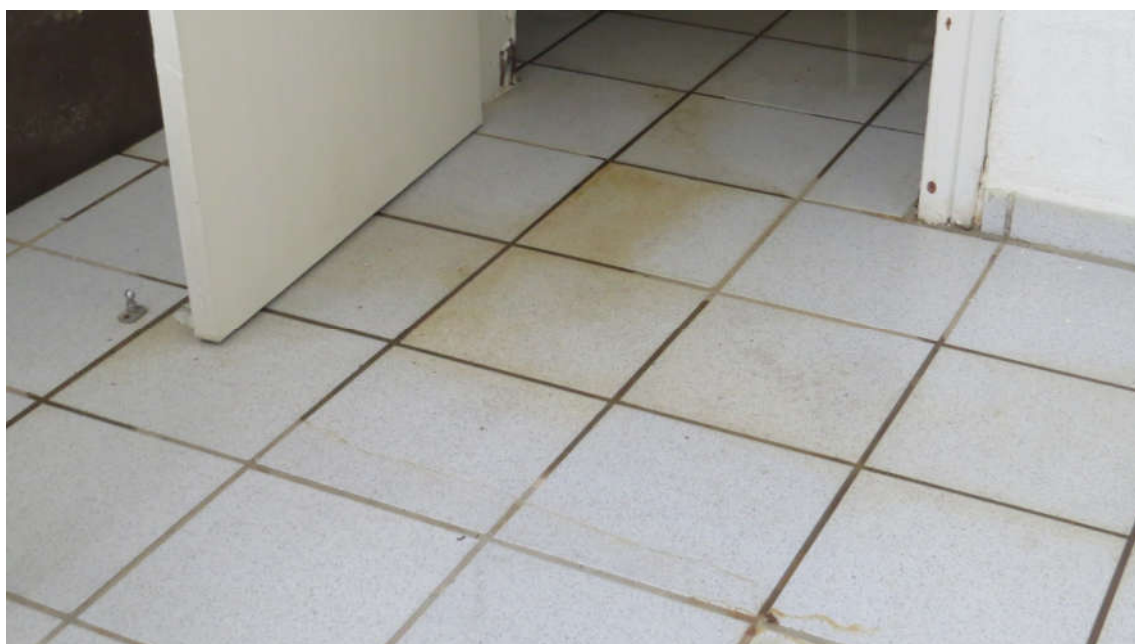
Figura 51: Alagamento em frente à sala do forno
