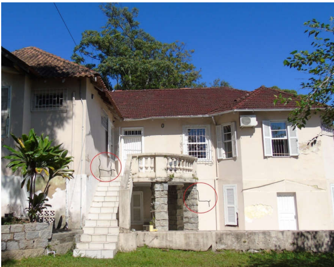
Figura 26: Localização das fissuras ao redor da varanda
