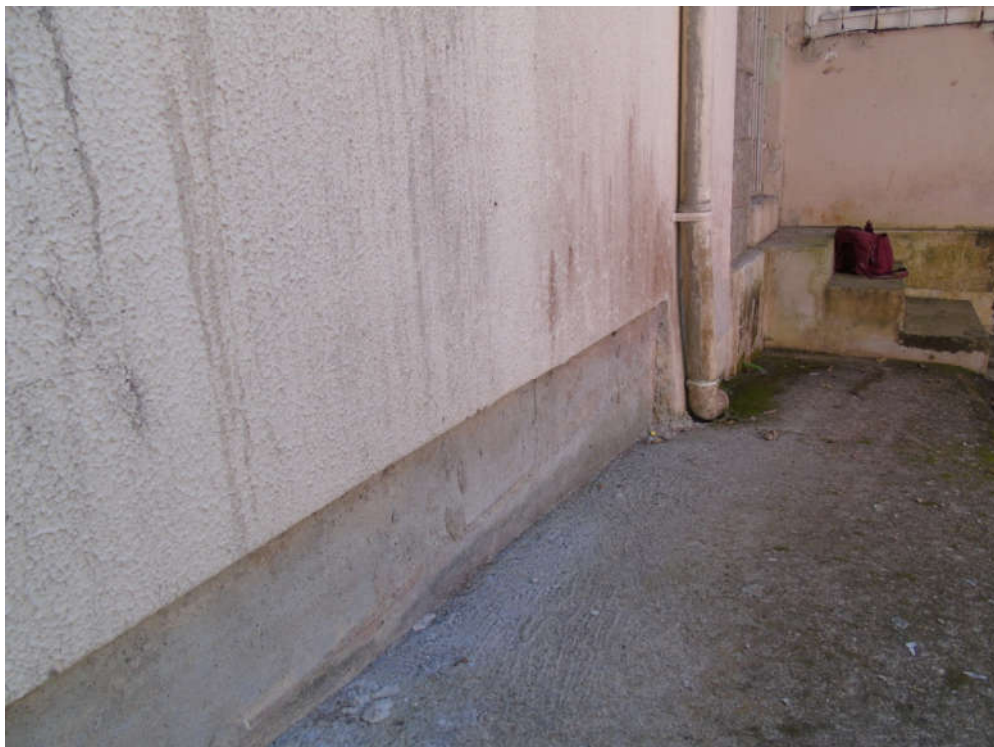
Figura 32: Coletor pluvial com destino impróprio ao lado da parede do refeitório (localizado à esquerda)
