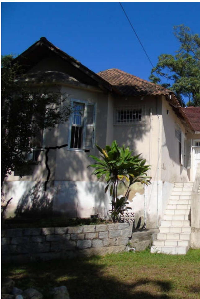
Figura 21: Localização das fssuras na fachada leste perto do canteiro
