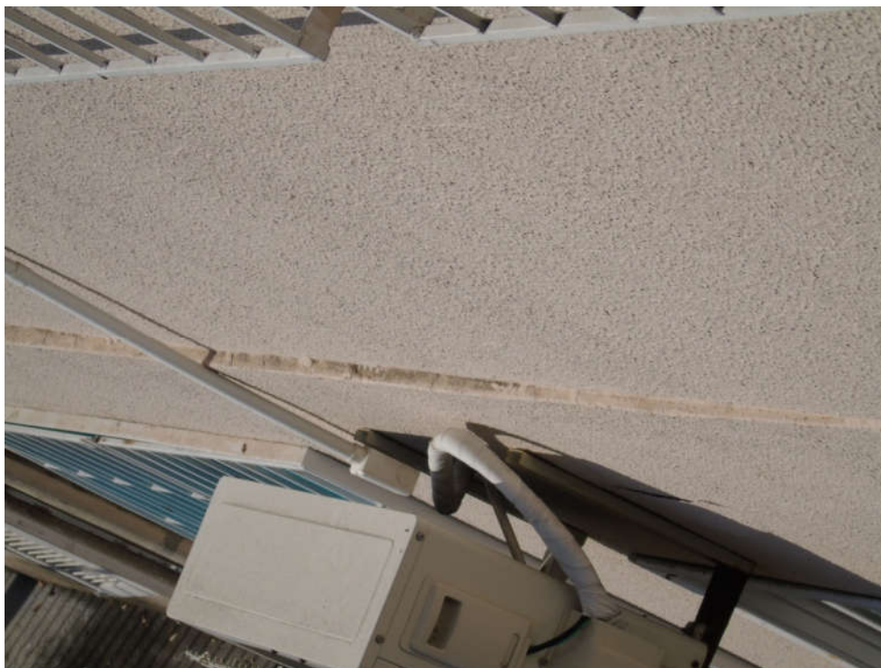
Figura 16: Desvio da parede, formando um dente na região de encontro com a viga
