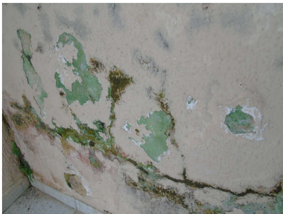
Figura 37: Fungos na parede abaixo da varanda com fissura também visível
