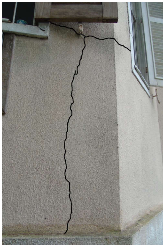
Figura 22: Detalhe ampliado das fissuras entre janelas da fachada leste
