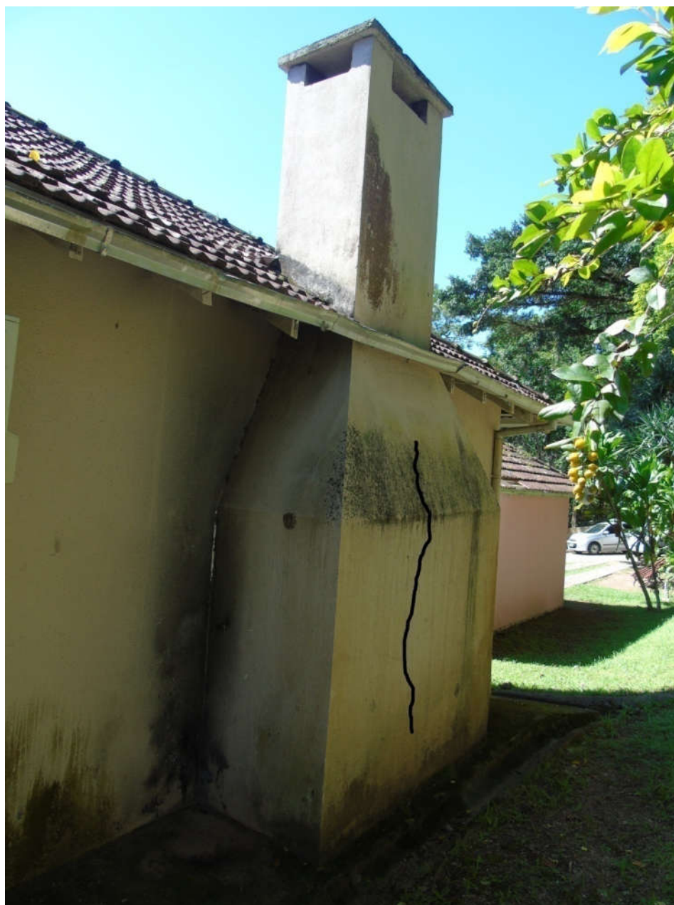
Figura 29: Fissura na chaminé na fachada oeste, atrás do refeitório
