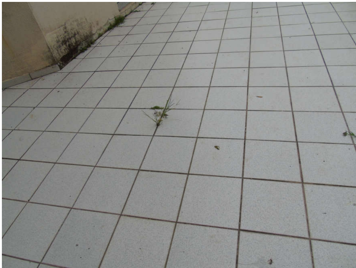
Figura 47: Revestimento cerâmico embaixo da varanda, se estendendo até o final da fachada leste
