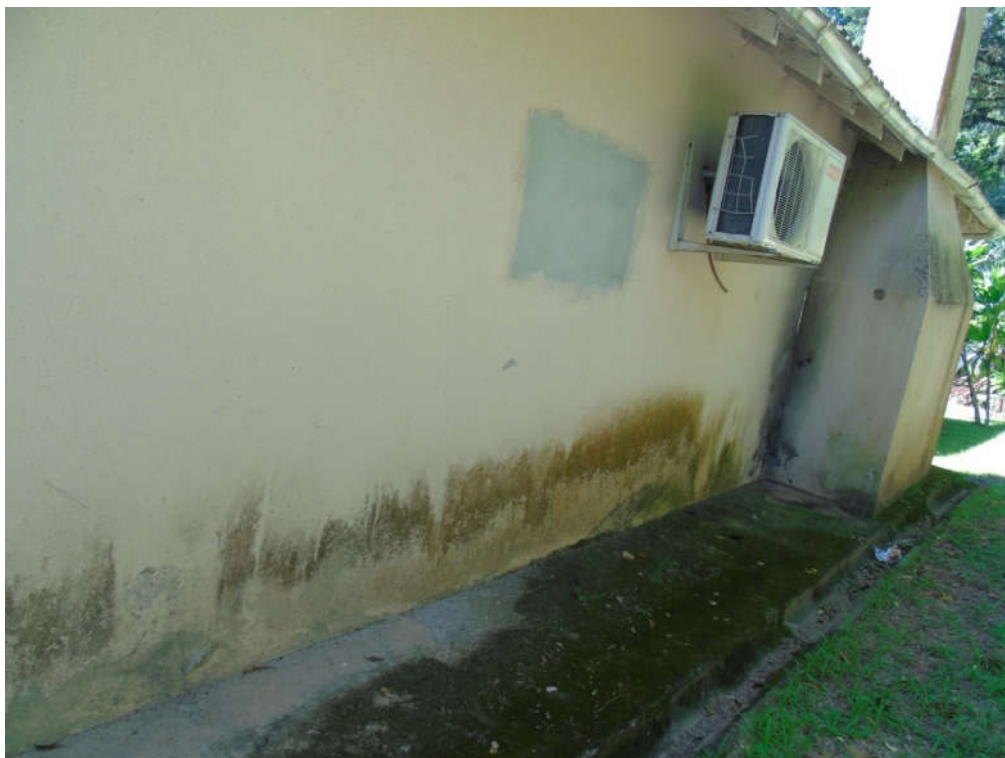
Figura 30: Fungos e algas na fachada oeste, atrás no refeitório
