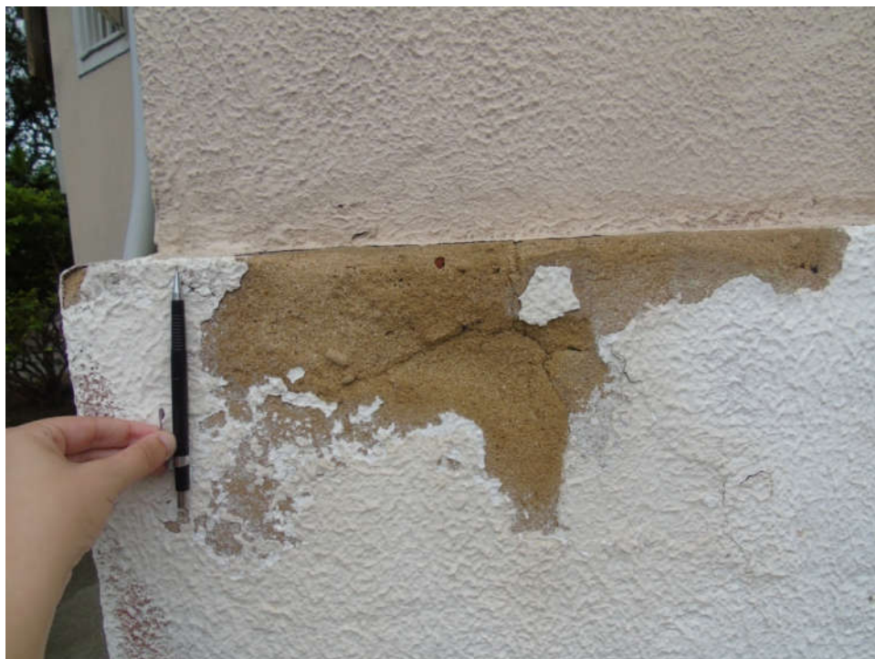
Figura 45: Argamassa de cor amarelada e muito friável ao lado da escada da varanda
