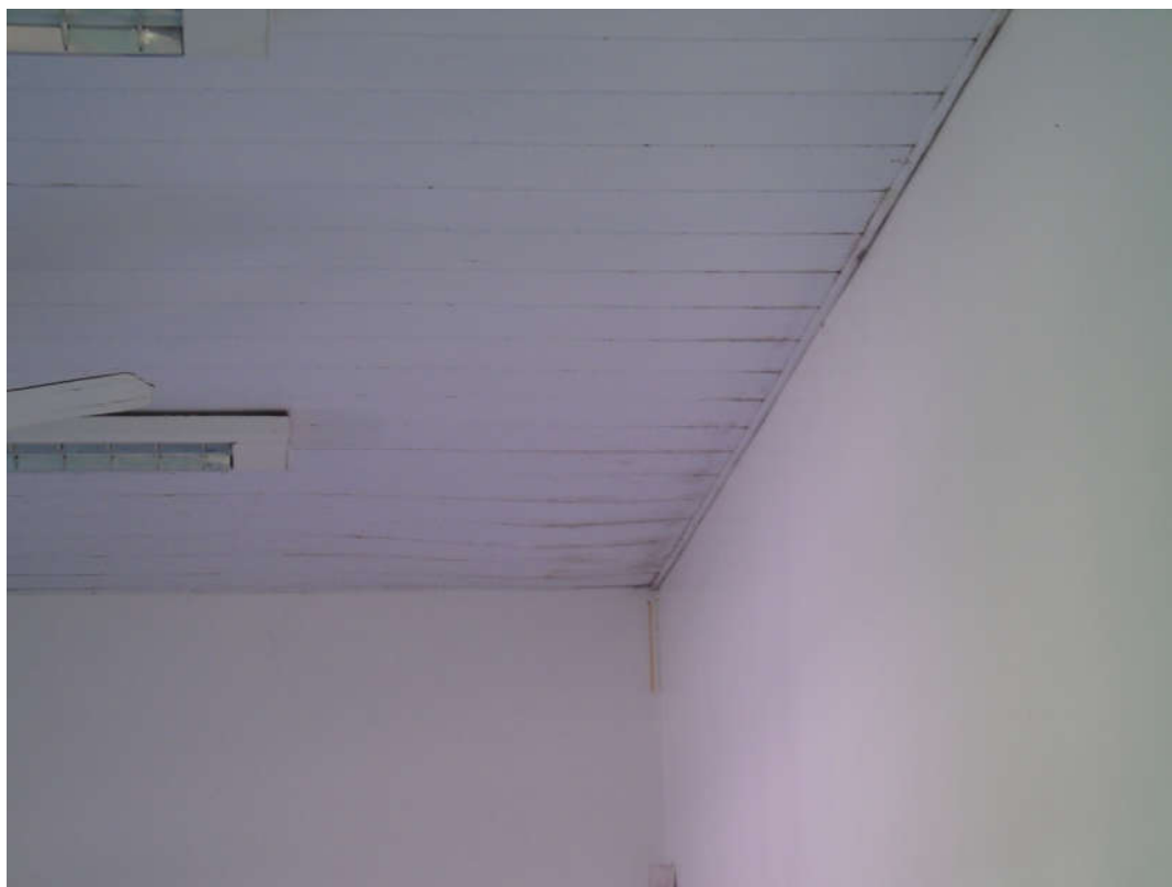
Figura 49: Fungos e manchas no forro do refeitório
