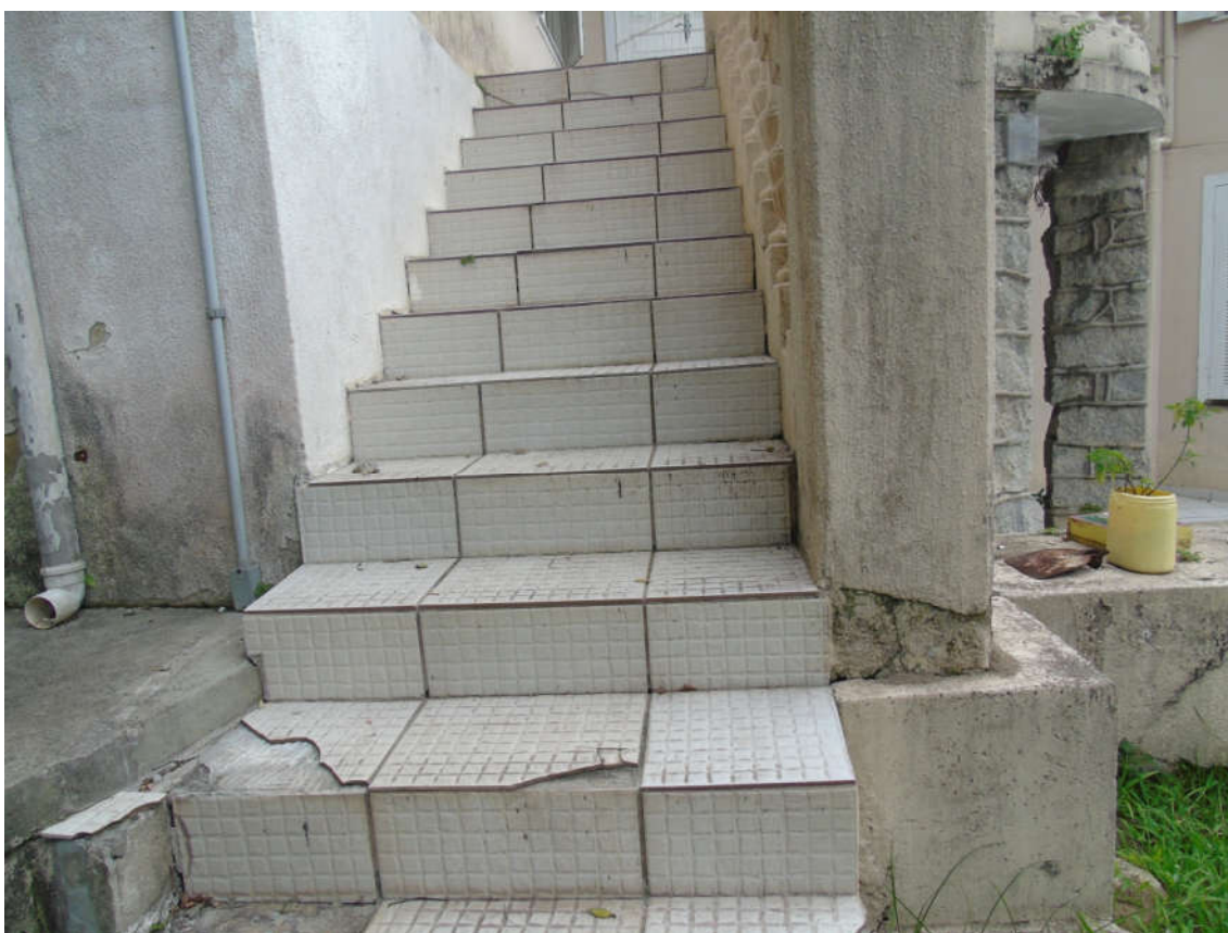
Figura 46: Fisuras no topo da escada e quebra de cerâmica na base
