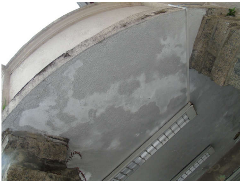
Figura 43: Mancha na parte inferior da laje da varanda
