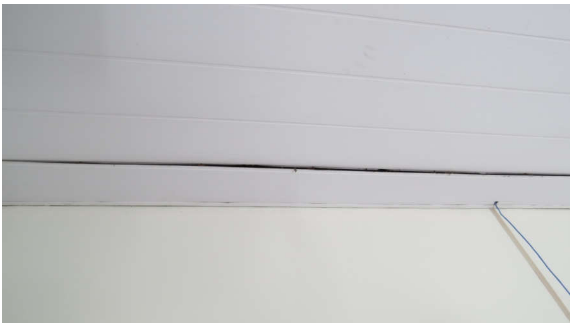
Figura 48: Forro de PVC mal colocado com fresta aparente
