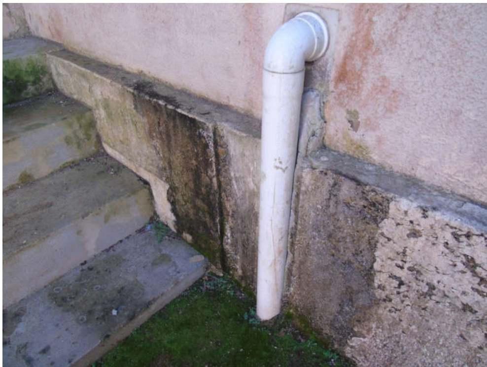
Figura 42: Mancha ao redor da canalização que vai para a caixa de gordura
