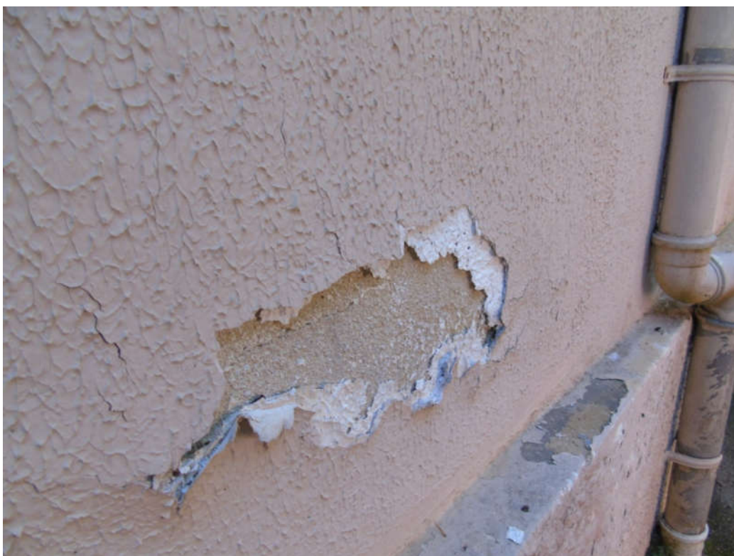
Figura 39: Descolamento da pintura na fachada oeste ao lado dos consultórios
