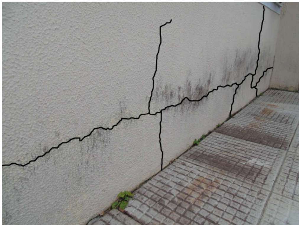
Figura 25: Fissura na parede lateral da varanda, a qual possui uma janela
