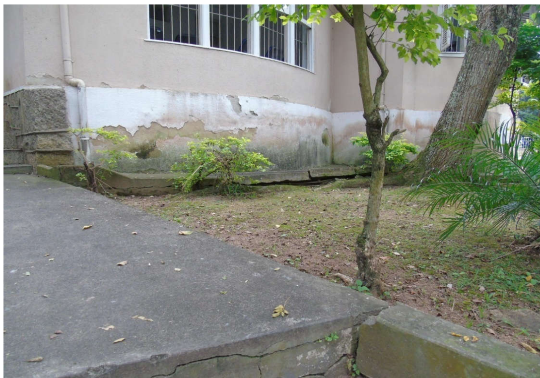
Figura 28: Rachaduras na calçada junto à edificação
