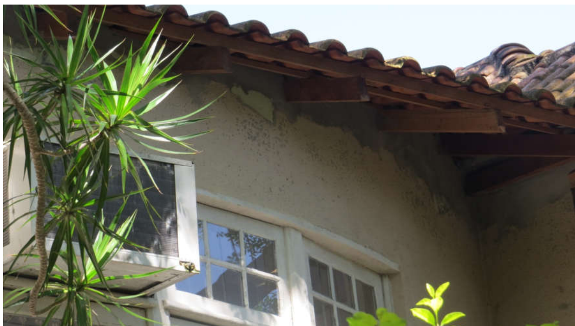
Figura 15: Estrutura de madeira do telhado trocada e preenchimento em argamassa sem nova pintura
