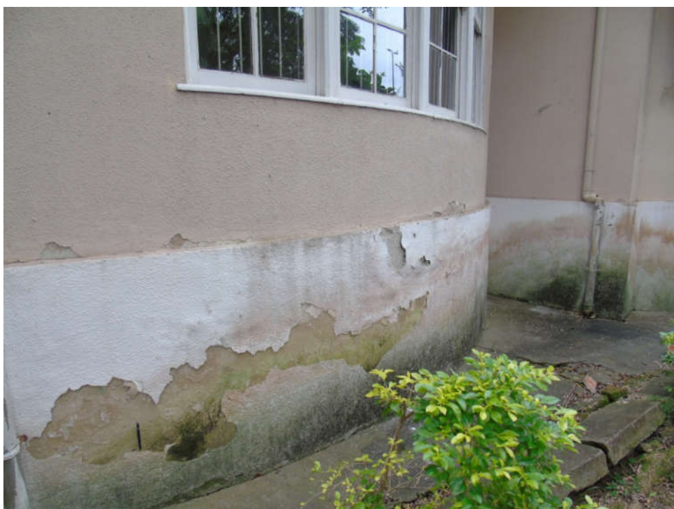
Figura 36: Fungos na parede da fachada oeste ao lado do canteiro e da árvore
