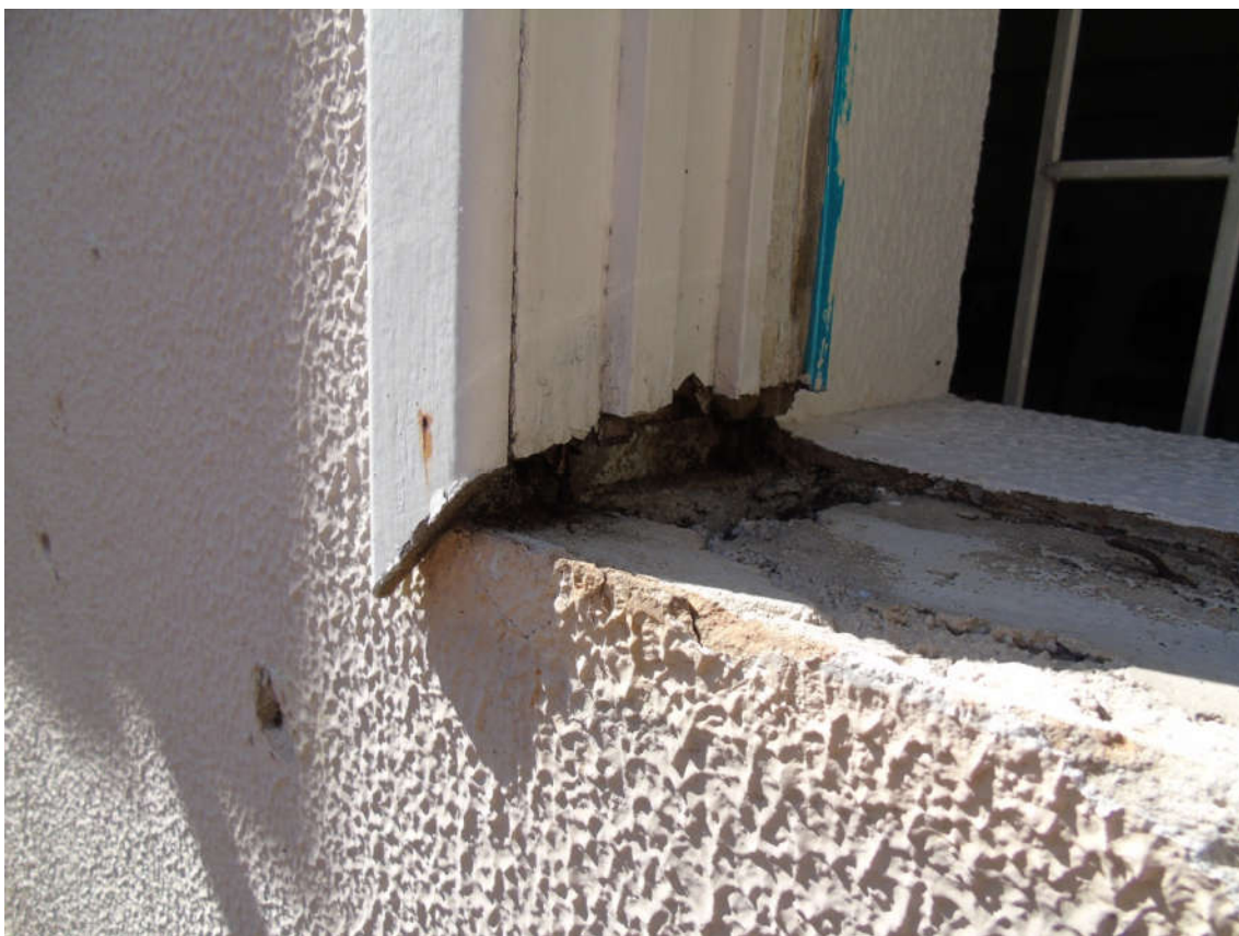
Figura 50: Detalhe de janela com parte da esquadria apodrecida, fachada norte
