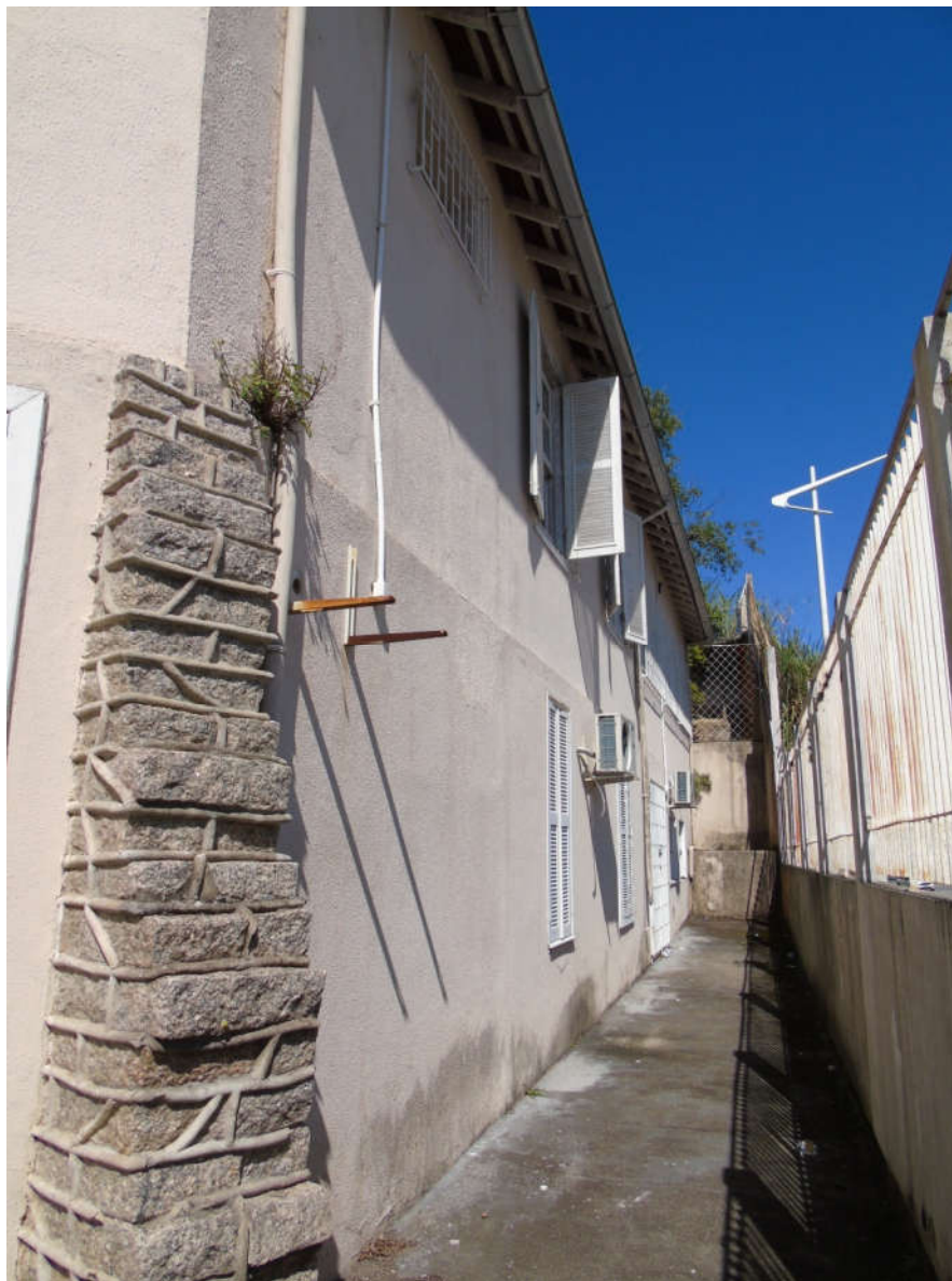
Figura 35: Fungos na fachada norte. Percebe-se uma mancha escura abaixo do ar condicionado onde a água cai livremente do mesmo
