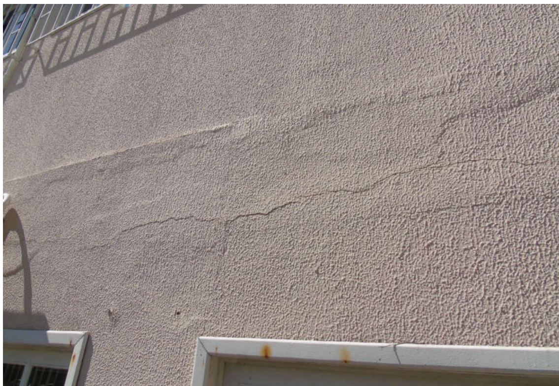
Figura 23: Fissura na viga da fachada norte
