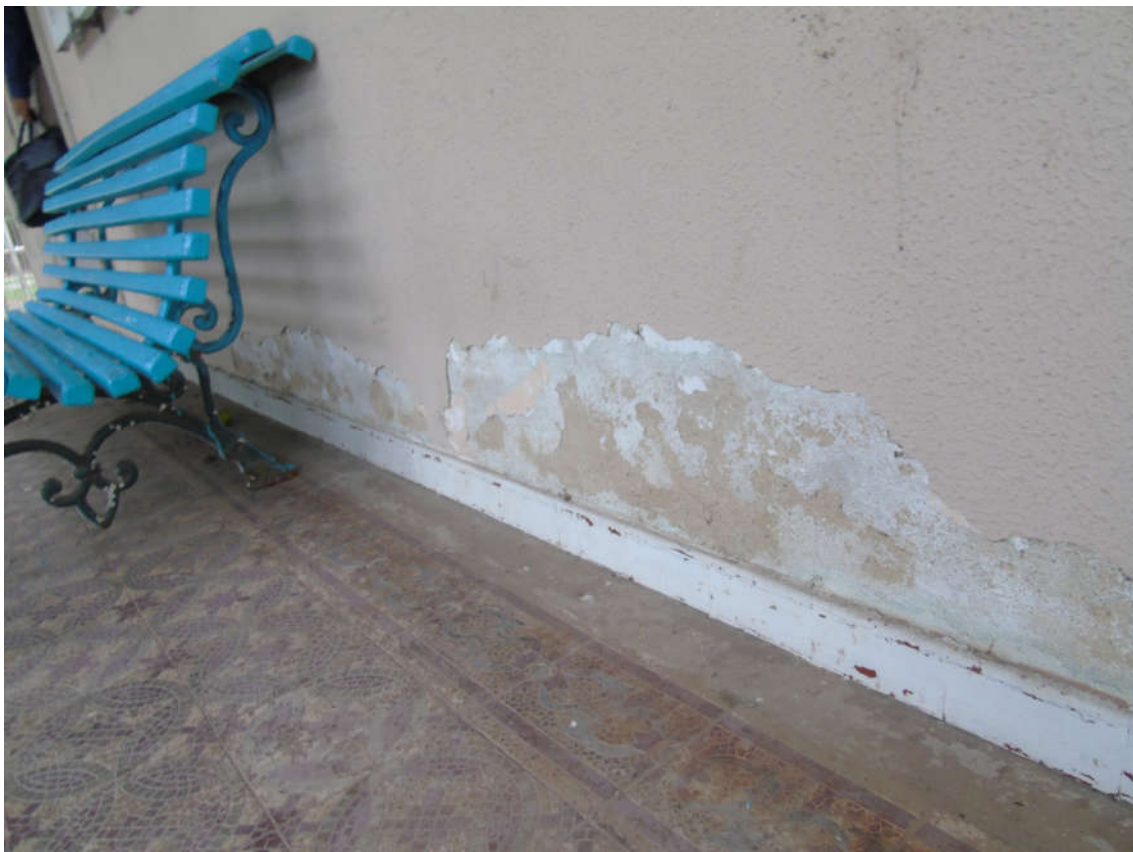
Figura 41: Pintura descascando na região inferior, ao lado da entrada principal na fachada sul
