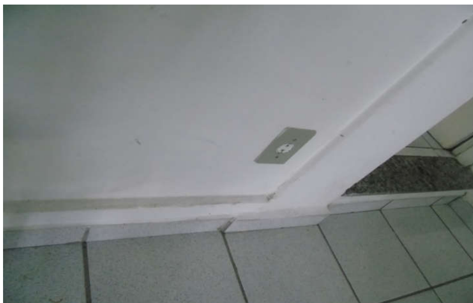
Figura 18: Recuo da parede por falta de prumo
