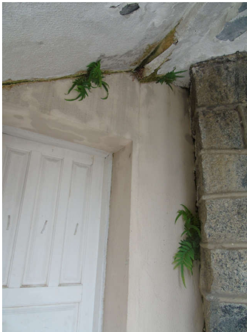
Figura 38: Vegetação embaixo da escada e da laje da varanda, face virada para norte
