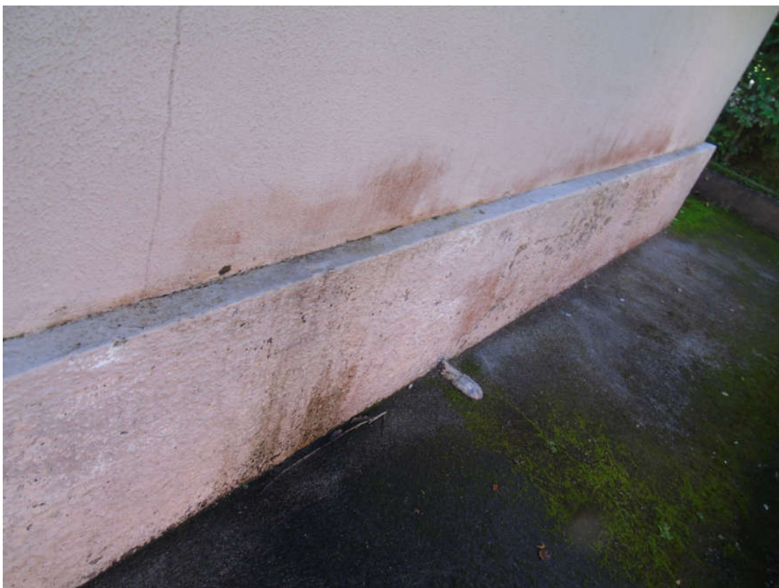
Figura 34: Fungos e algas em parede da fachada oeste.
