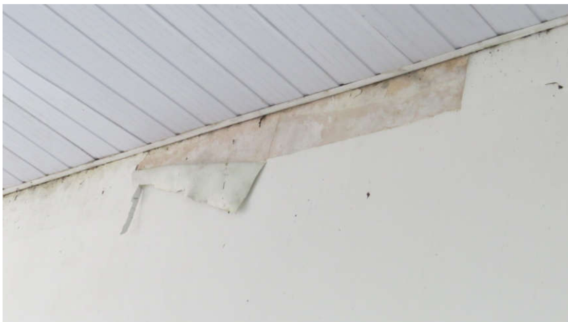
Figura 44: Descolamento da tinta na região interna da edificação
