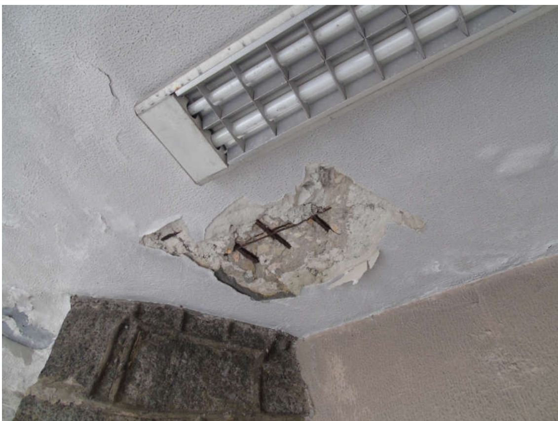
Figura 19: Armadura aparente na face inferior da laje da varanda
