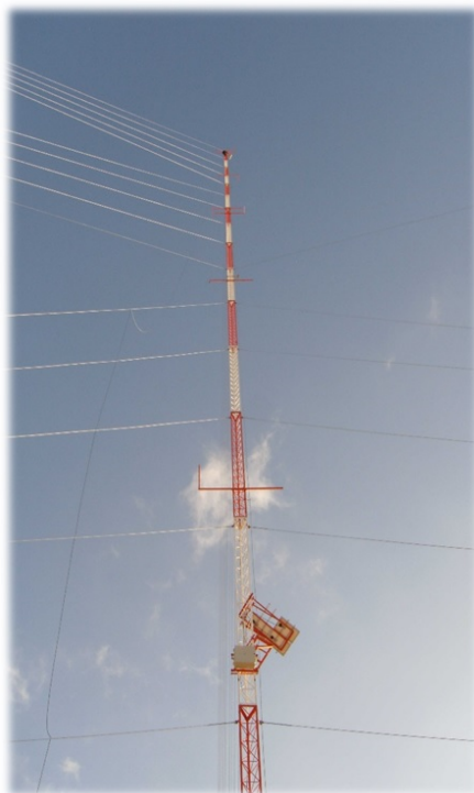
Figura 11 – Torre de 100 m instalada em Beberibe.
