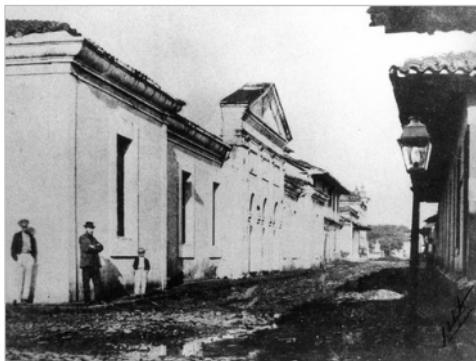
Figura 2. Fotografía del edificio de la Casa de Enseñanza de Santo Tomás
