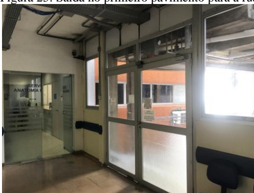
Figura 25: Saída no primeiro pavimento para a rua por passarela
