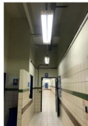
Foto 17: Corredor da lavanderia sem qualquer indicação de rota de fuga
