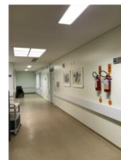
Foto 10: Corredor com equipamentos de segurança porém com depósito de materiais que diminuem sua largura útil
