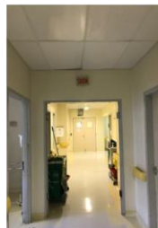
Foto 13: Corredor da ala dos leitos de ambulatório devidamente sinalizado com placas fotoluminescentes
