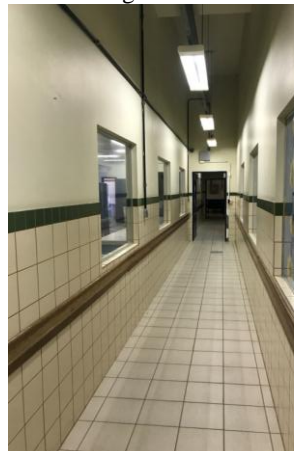
Figura 36: Corredor da lavanderia sem sinalização de rota de fuga
