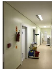
Foto 19: Corredor no interior da UTI com equipamentos de segurança
