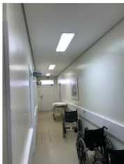
Foto 16: Corredor que comunica com saída de emergência ocupado por cadeiras de rodas e macas que dificultam a passagem
