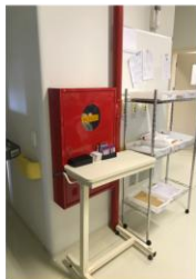
Foto 12: Hidrante com acesso dificultado por depósito de mobiliário em frente
