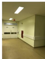
Foto 9: Corredor com iluminação de emergência, placa indicativa de rota e hidrante
