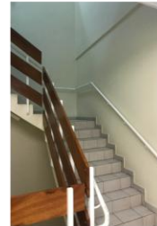
Foto 3: Escada bloco G
