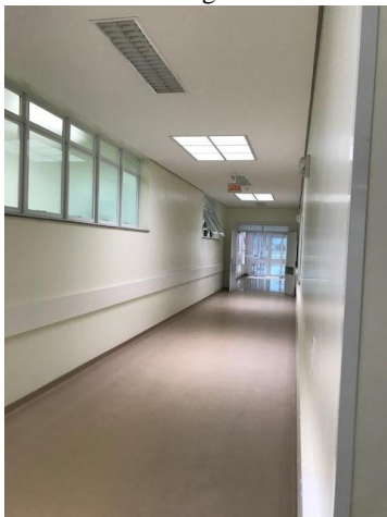
Figura 46: Porta de saída com abertura inversa ao sentido da fuga
