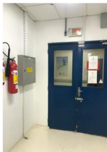
Foto 8: Extintores sem sinalização
