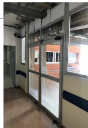
Foto 5: Saída por rampa
