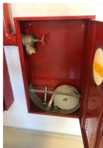
Foto 9: Hidrante sinalizado e em bom estado
