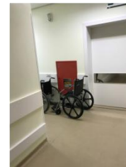
Foto 15: Cadeira de rodas estacionada em frente à hidrante, dificultando o acesso ao mesmo
