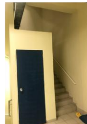
Foto 3: escada meio do bloco
