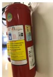
Foto 17: Extintor no corredor do ambulatório estava fora da validade
