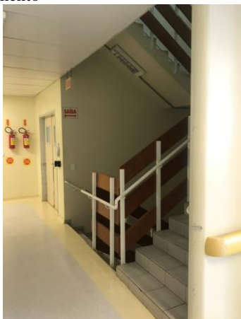
Figura 28: Escada no Terceiro Pavimento
