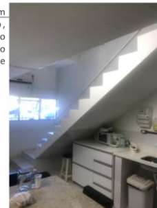
Foto 8: Escada que dá acesso ao primeiro pavimento
