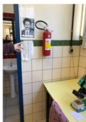
Foto 24: Extintor sem sinalização e com mobiliário abaixo o que poderia dificultar o acesso
