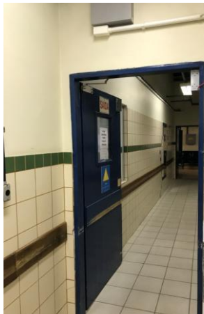
Figura 35: Porta em corredor de acesso à lavanderia
