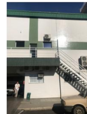
Foto 20: Foto da saída de emergência por fora (diferença de nível devido à declive do terreno)
