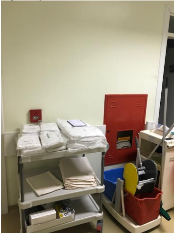
Figura 52: Equipamentos de segurança com acesso obstruído
