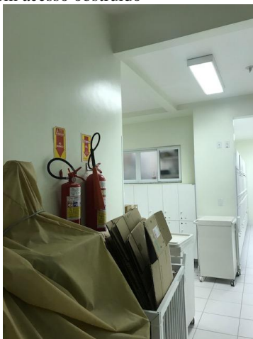
Figura 54: Equipamentos de segurança com acesso obstruído
