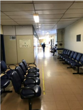
Figura 33: Área de espera sem sinalização com indicação de rota de fuga
