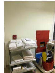
Foto 8: Equipamentos de proteção ativa com material depositado em frente
