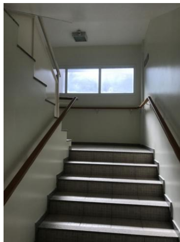
Figura 51: Escada protegida
