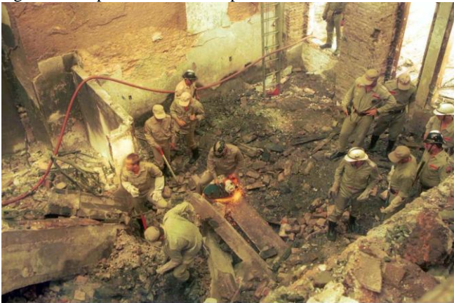
Figura 1: Hospital de Caridade após incêndio de 1994
