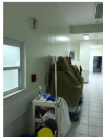
Foto 13: Equipamentos de segurança bloqueados por objetos depositados em frente
