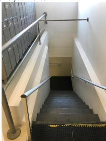
Figura 32: Escada que desce para primeiro pavimento
