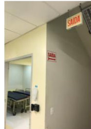
Foto 2: Escada bloco G
