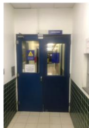
Foto 12: Porta de acesso aos laboratórios. Sentido correto de fuga, porém não possui sinalização
