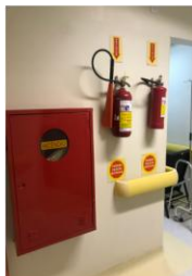
Foto 12: Equipamentos de proteção ativa devidamente sinalizados
