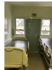
Foto 2: Saída de Emergência direto para escada externa
