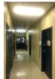
Foto 14: Corredor dos laboratórios sem qualquer sinalização indicativa da rota de fuga
