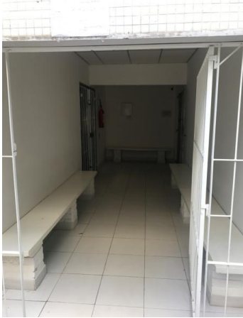
Figura 37: Corredor de saída pavimento térreo com largura reduzida por bancos fixos
