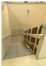
Foto 3: Escada que conecta o quarto pavimento ao primeiro
