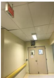
Foto 11: Porta de saída do ambulatório com botão que permite saída de qualquer um, porém no sentido inverso ao da fuga
