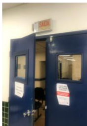
Foto 11: Porta de saída da ala de exames para o corredor central do bloco, com sinalização fotoluminescente, porém com abertura no sentido inverso ao da fuga.
