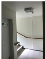
Foto 6: Interior da escada que comunica com o pavimento superior
