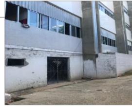
Foto 2: Acesso ao porão que serve como depósito abaixo da lavanderia com porta trancada.
