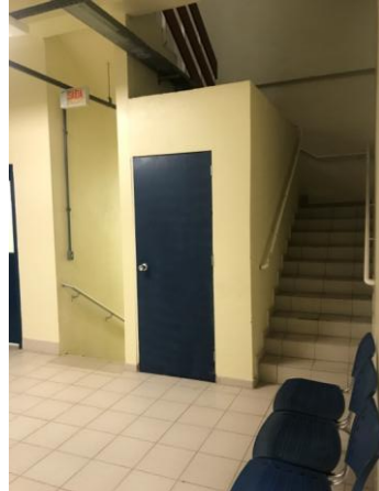
Figura 27: Escada no Segundo Pavimento
