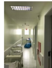
Foto 4: Acesso a uma das saídas de emergência
