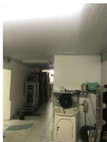
Foto 10: Corredor para depósito
