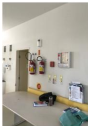
Foto 14: Equipamentos de proteção com acesso dificultado por depósito de mobiliário em frente
