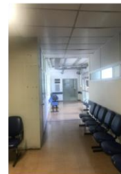
Foto 10: Corredor com cadeiras de espera que reduzem a largura útil da rota. Ausência de sinalização indicativa de rotas
