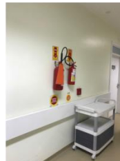
Foto 7: Equipamentos de proteção ativa com material depositado em frente
