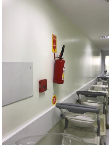
Figura 53: Equipamentos de segurança com acesso obstruído
