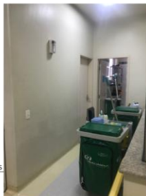
Foto 7: Corredor acesso banheiros UTI
