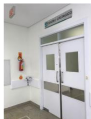
Foto 7: Acesso centro cirúrgico com porta tipo vai-e-vem
