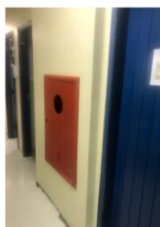
Foto 25: Hidrante sem sinalização e com vidro danificado
