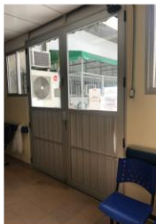
Foto 7: Porta com acesso direto para a rua porém com acesso exclusivo para portadores de cartão
