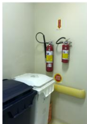
Foto 13: Extintores com acesso dificultado por depósito de lixeiras em frente
