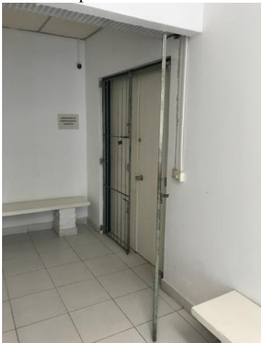
Figura 21: Saída para o corredor de saída do térreo com grade aberta
