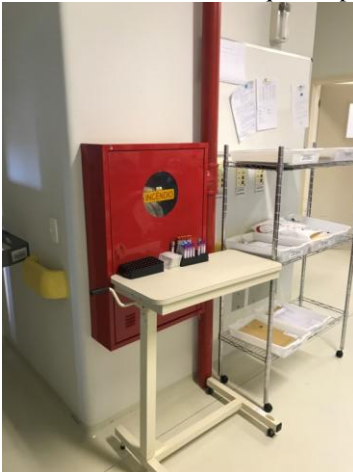
Figura 42: Hidrante da UTI bloqueado por mesa
