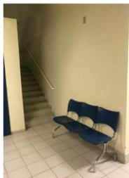
Foto 4: Cadeiras bloqueando a rota de fuga, bem em frente à escada
