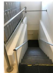
Foto 7: Escada metálica desprotegida
