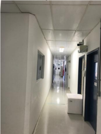
Figura 39: Caixa de isopor reduzindo largura da rota de fuga
