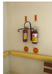
Foto 14: Extintores de incêndio devidamente sinalizados. um deles estava fora da data de validade.
