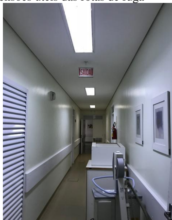
Figura 45: Materiais reduzindo as dimensões úteis das rotas de fuga
