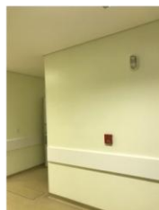
Foto 8: Corredor com iluminação de emergência e alarme
