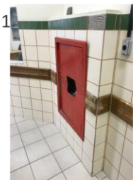
Foto 23: Hidrante sem sinalização e com vidro e porta danificados
