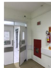
Foto 6: Hall do pavimento de acesso pelo elevador
