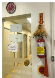
Foto 16: Extintor na sala de pesquisas servindo como suporte para objetos
