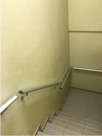
Figura 30: Corrimão descontínuo no terceiro pavimento
