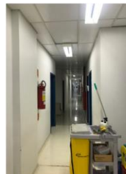
Foto 6: Corredor obstruído por carrinho de limpeza
