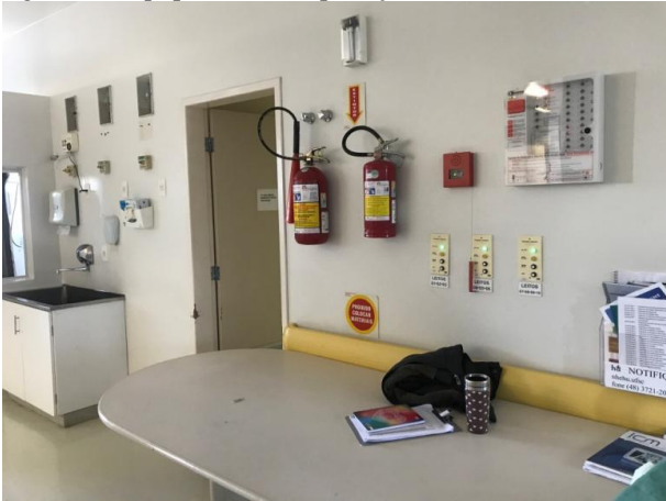
Figura 41: Equipamentos de proteção na UTI
