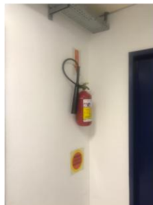
Foto 13: Extintor devidamente sinalizado e em bom estado
