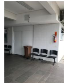
Foto 14: Extintor bloqueado por cadeiras de espera
