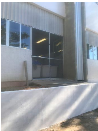
Figura 23: Saída primeiro pavimento pela lavanderia
