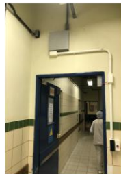
Foto 16: Porta no corredor da lavanderia com placa indicando a saída colada, impedindo a visualização da mesma que ainda não é fotoluminescente.
