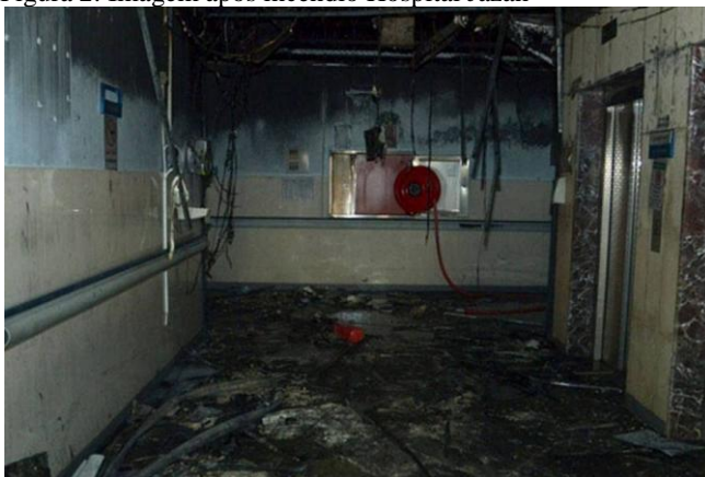
Figura 2: Imagem após incêndio Hospital Jazan
