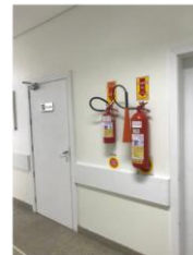
Foto 5: Acesso à escada que comunica com o pavimento superior
