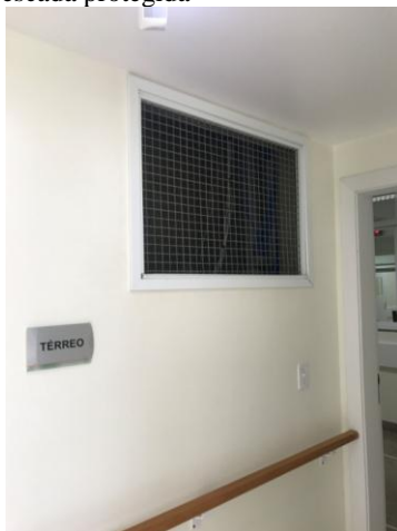
Figura 50: Duto de ventilação da escada protegida
