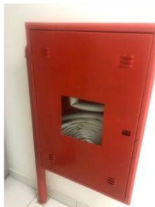
Foto 12: Hidrante sem sinalização e com vidro danificado
