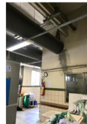
Foto 18: Lavanderia com extintores sem sinalização
