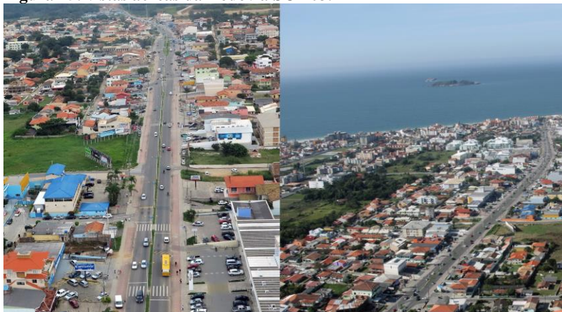
Figura 45: vistas aéreas da Rodovia SC-403.
