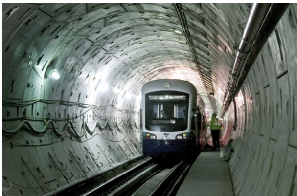
Figura 4.1 – Túnel do metrô de Seattle
