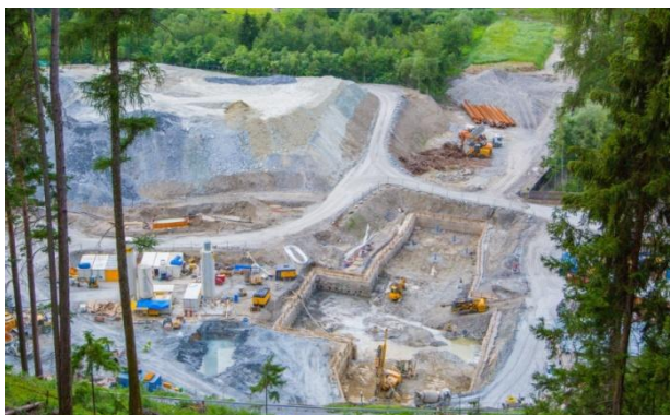
Figura 5.6 – Canteiro de obras no município de Maria Stein (GKI, 2014)
