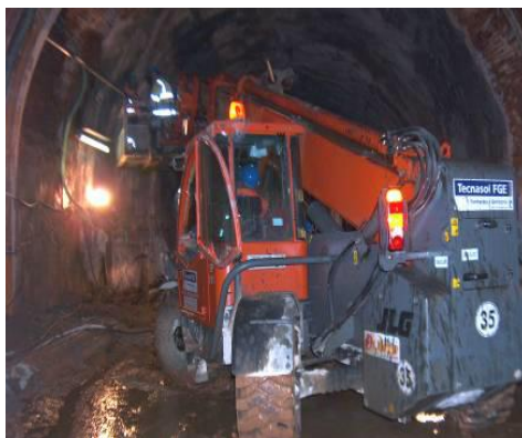
Figura 2.3 – Máquina para instalação das cambotas metálicas.
