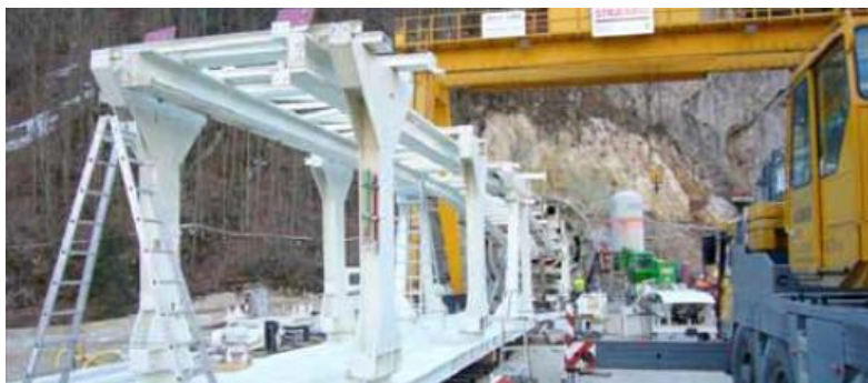
Figura 5.7 – Correias transportadoras do material de escavação (GKI, 2014)
