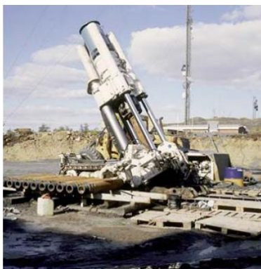
Figura 2.10 - Escavação para Poço Inclinado na Mina de Copper - Bolívia 1986
