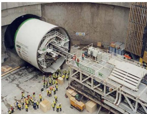
Figura 2.9- TM – Escavação na Via Mockingbird, DART – Dallas
