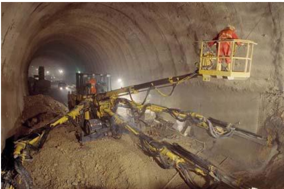
Figura 2.12 - Perfuratriz tipo “Jumbo” Automática, Túnel em Graz, Áustria
