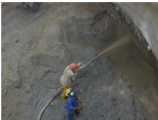
Figura 2.1 - Aplicação de concreto projetado na calota do Lehigh Tunnel
