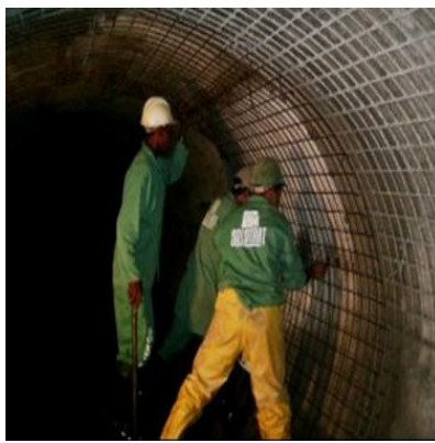
Figura 2.2 – Cambotas metálicas utilizadas como sistemas de suporte
