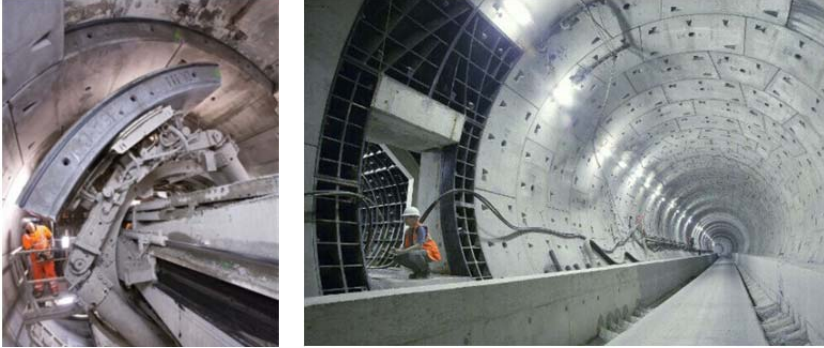
Figura 15 – Destaque para posicionamento e túnel finalizado com segmentos pré-moldados de concreto
