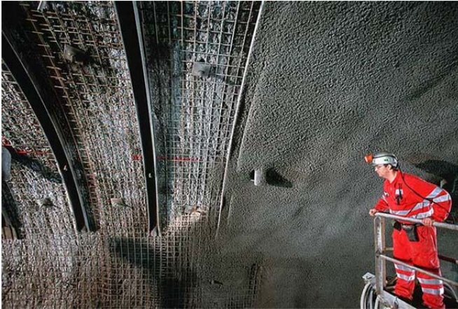
Figura 16 - Concreto projetado reforçado com cambotas metálicas e tirantes.
