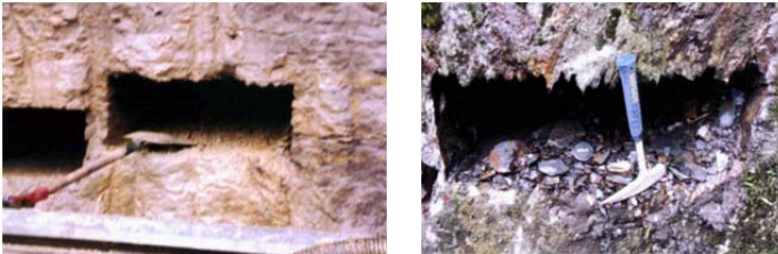
Figura 22 - Cavidades abertas por hidrodemolição em arenito (esquerda) e ardósia (direita)
