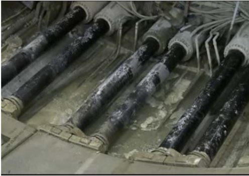
Figura 40 – Cilindros hidráulicos utilizados para movimentar TBM.
