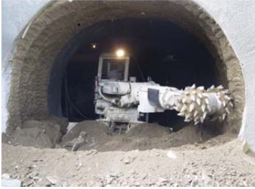
Figura 7 - Escarificadora transversal e processo de escavação
