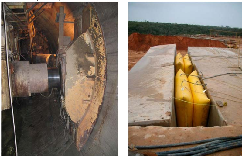
Figura 39 - Sistemas que utilizam sapatas hidráulicas (esquerda) e colchões hidráulicos (direita)
