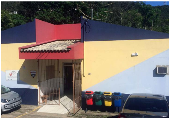
Figura 6 – Fachada da EBMJJC. Fonte: Nydia Lorenzini, coordenadora pedagógica, Arquivo da Escola.
