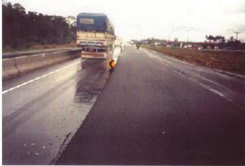
Figura 4 – Trecho com camada porosa de atrito entre os km 10 e 11 da BR-101/SC.
