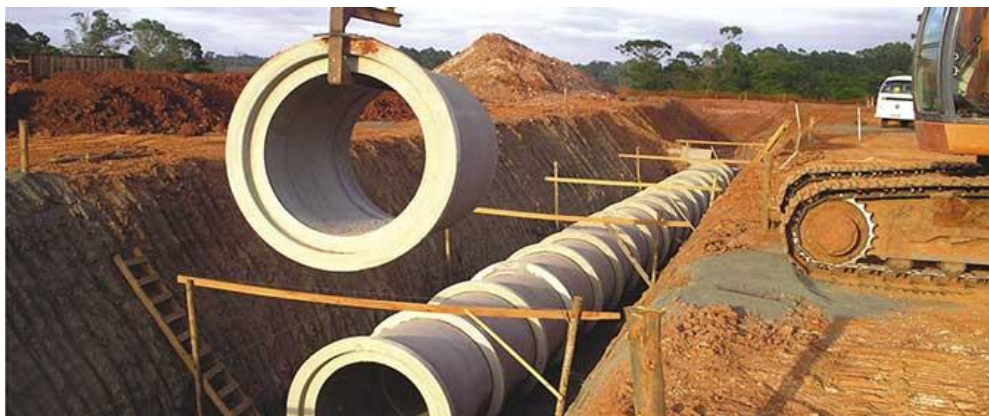
Figura 19 - Instalação de manilhas de concreto
