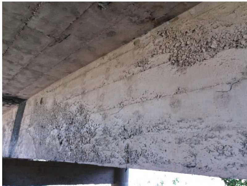
Figura 18 – Nichos de Concretagem em Longarina de Ponte Fonte: Ana Elisa Boettger (2017).
