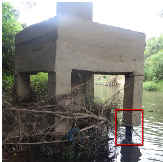
Figura 61 – Bloco de estacas da ponte Guarani; em destaque, esqueleto metálico da estaca exposto Fonte: Ana Elisa Boettger (2018).
