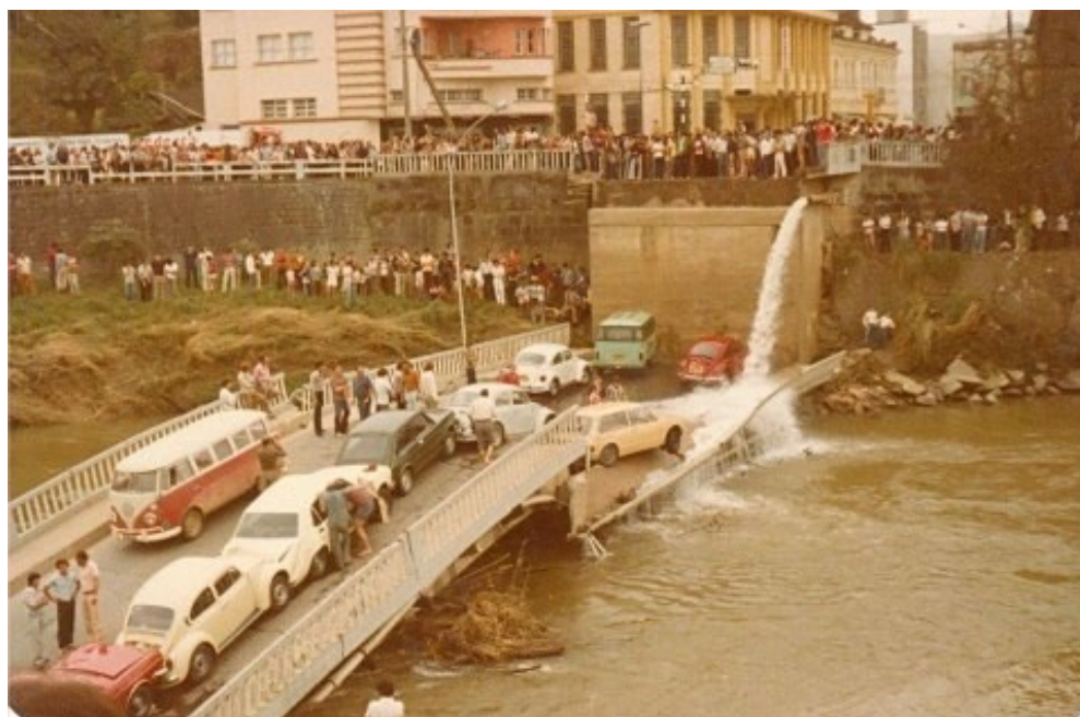
Figura 68 – Queda da ponte em Brusque
