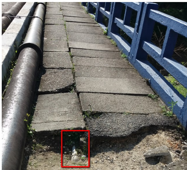
Figura 64 – Anormalidades na calçada da ponte
