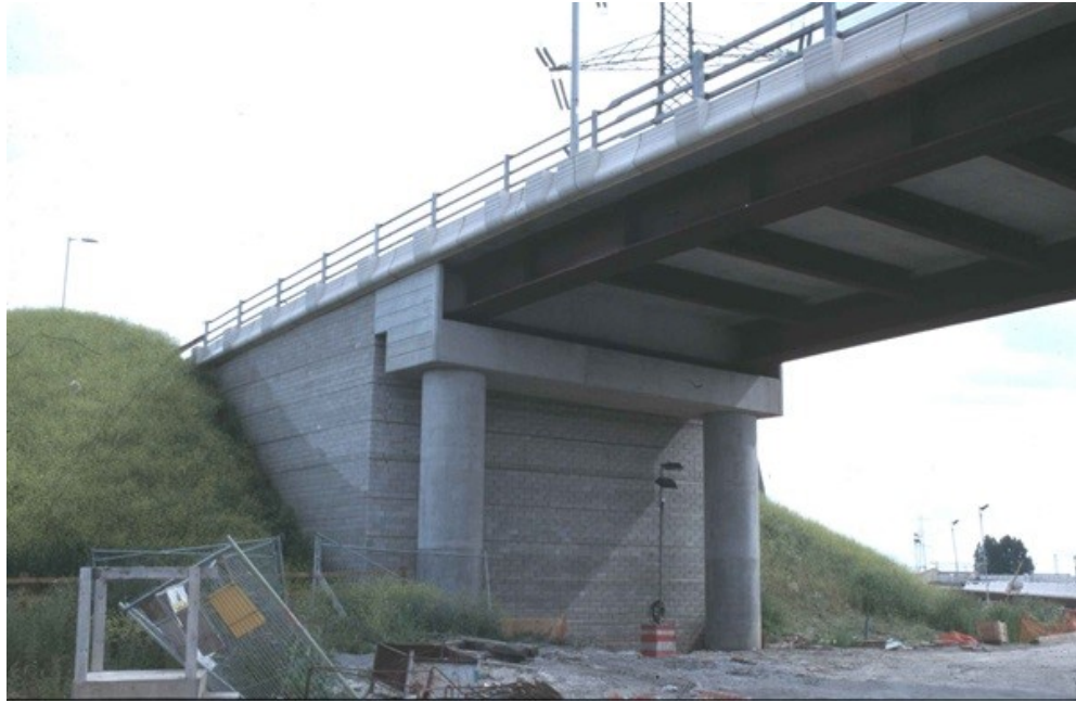
Figura 3 – Ponte com encontro
