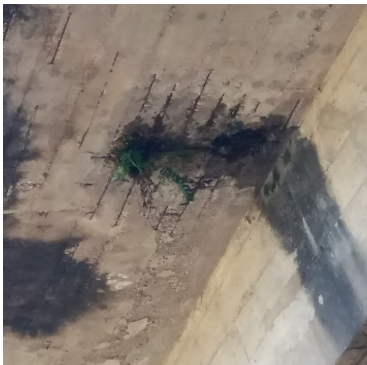
Figura 66 – Crescimento de vegetação ao redor da tubulação de drenagem
