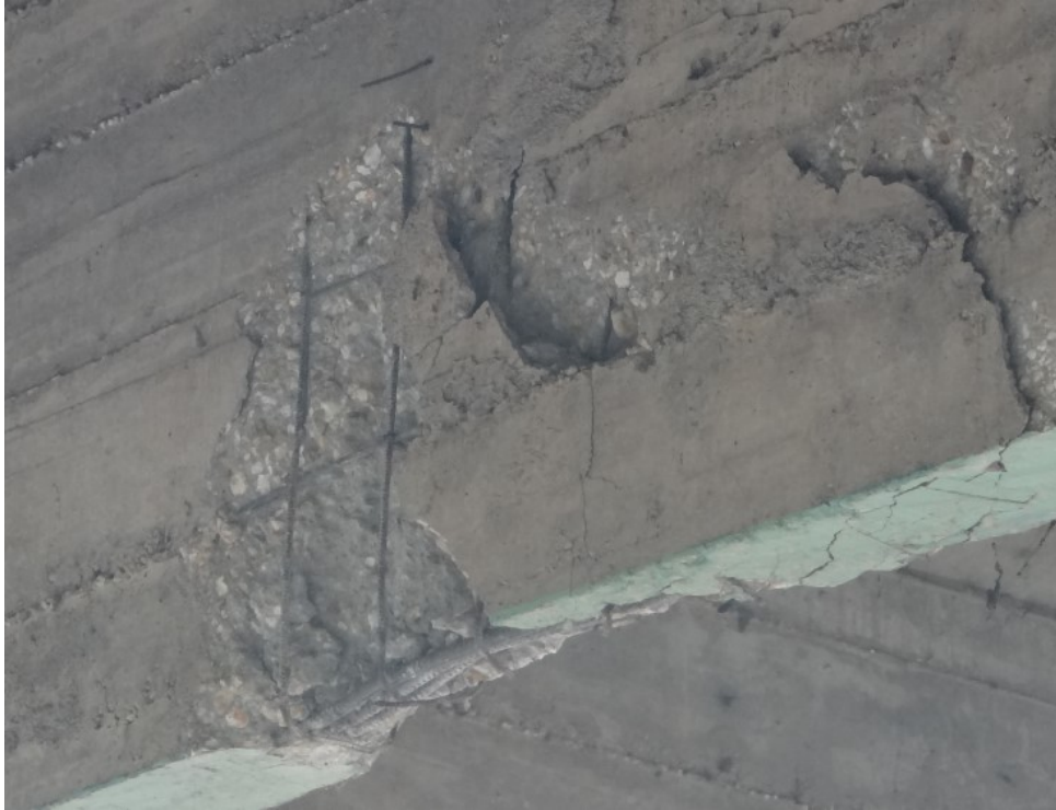
Figura 32 – Dano por colisão em uma das transversinas da ponte Fonte: Ana Elisa Boettger (2017).
