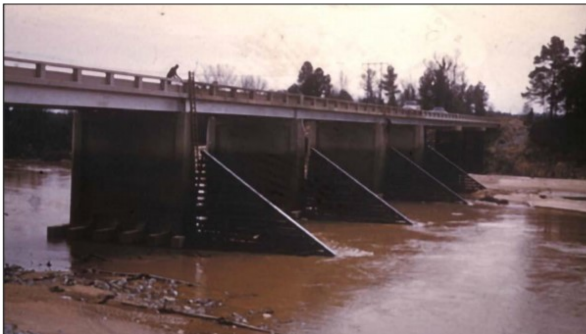
Figura 74 – Aparelho defletor de água e entulhos independente da ponte
