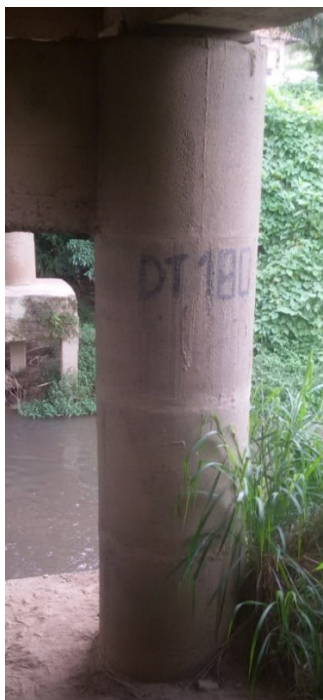
Figura 60 – Pilar da ponte Guarani
