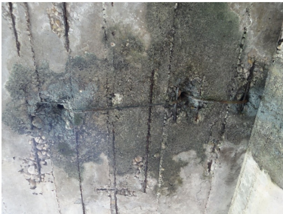
Figura 47 – Agregados expostos, baixo cobrimento, corrosão e infiltrações na ponte
