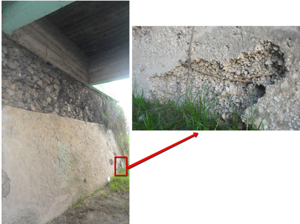
Figura 36 – Encontro sul; em destaque, nicho de concretagem na base da estrutura de contenção de terra
