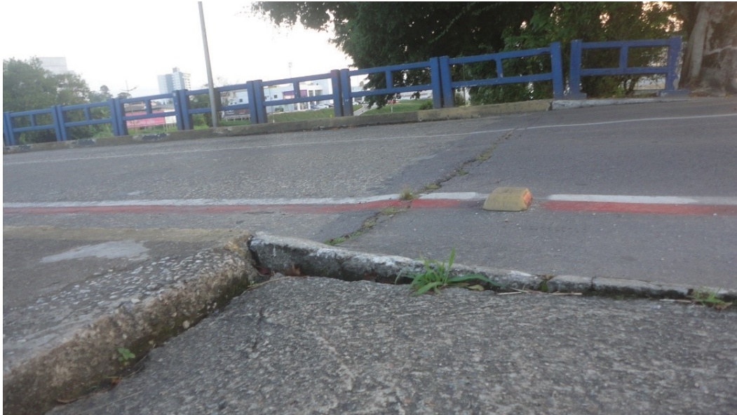
Figura 35 – Acesso da ponte com a via; variação abrupta de angulação e alto desnível no acesso de pedestres
