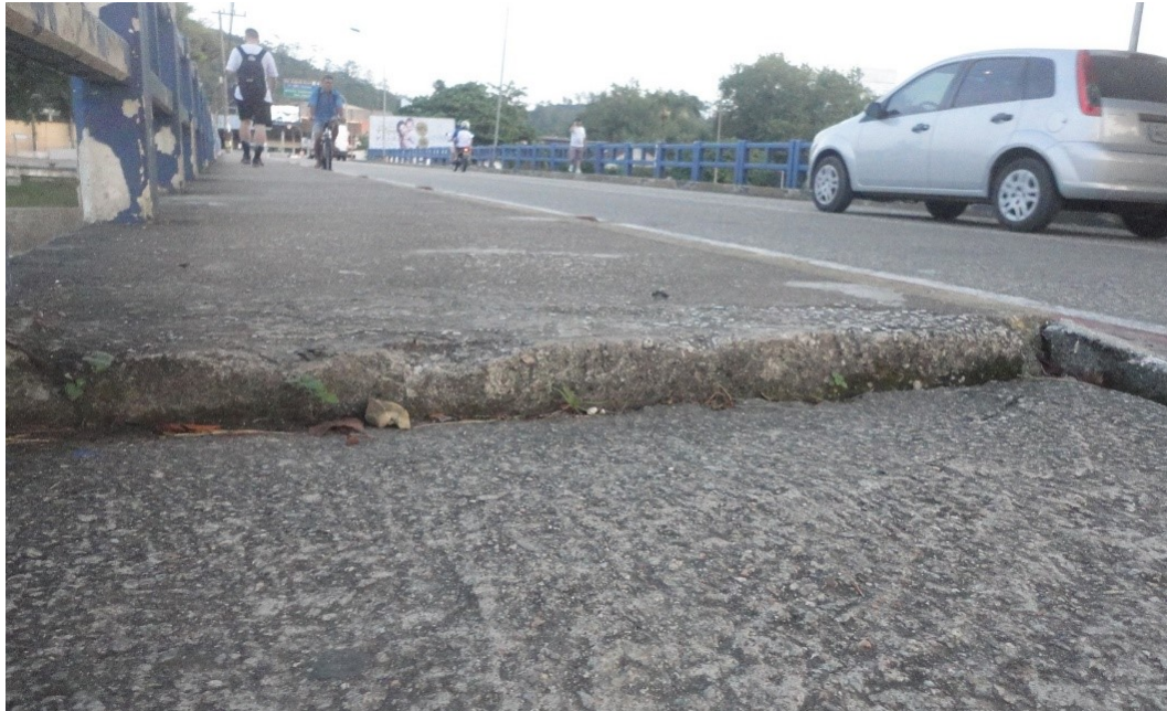
Figura 34 – Desnível significativo no acesso de pedestres da ponte
