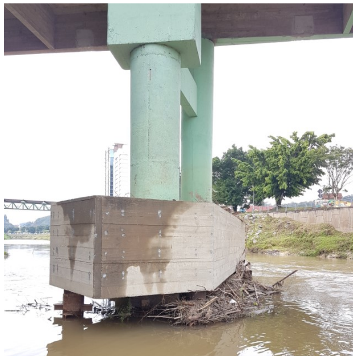
Figura 71 – Acúmulo de sedimentos no bloco de fundação referente a parte interna da curva - Ponte Arthur Schlosser
