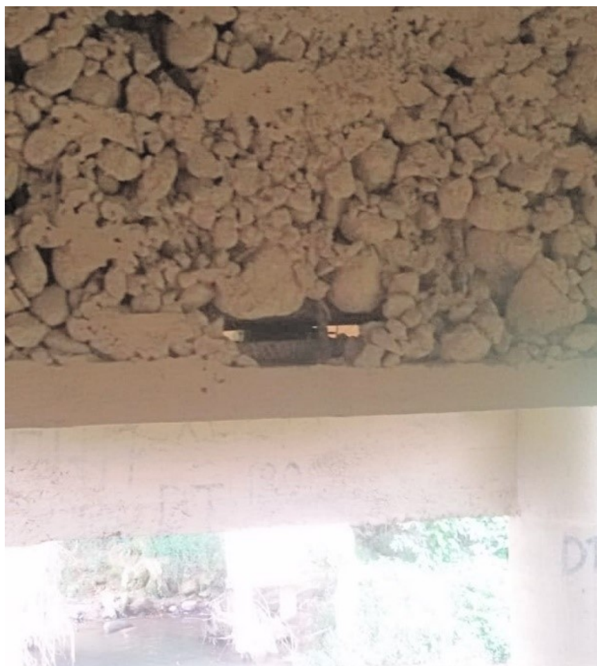
Figura 53 – Nicho de concretagem severo em transversina
