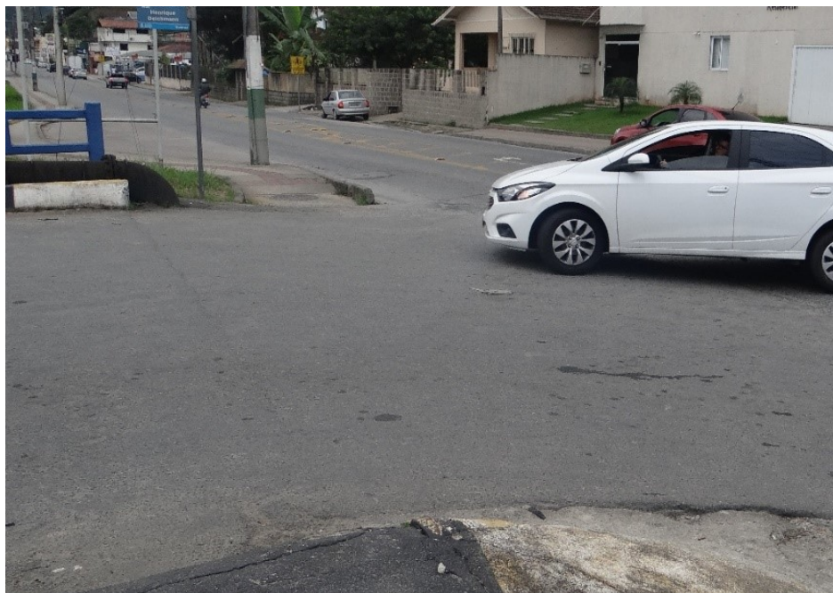
Figura 55 – Acesso da ponte Fonte: Ana Elisa Boettger (2018).
