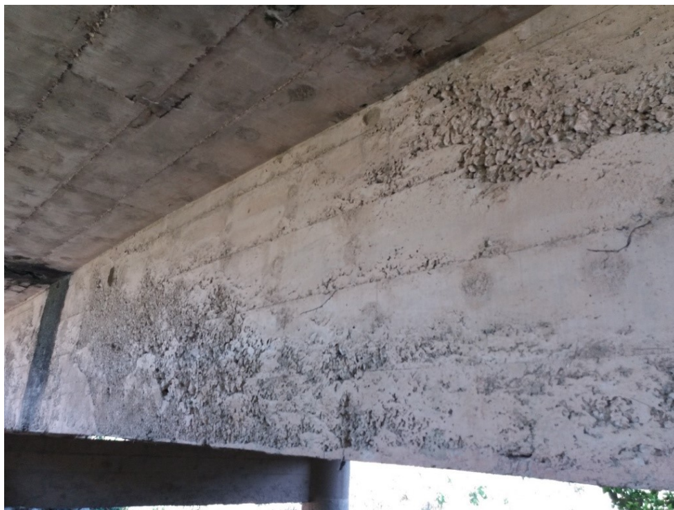
Figura 51 – Longarina com nichos de concretagem
