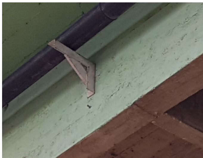
Figura 42 – Suporte das Tubulações
