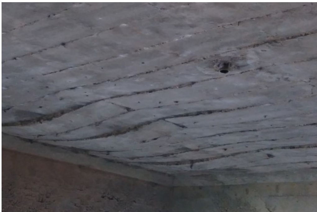
Figura 50 – Deformação na laje
