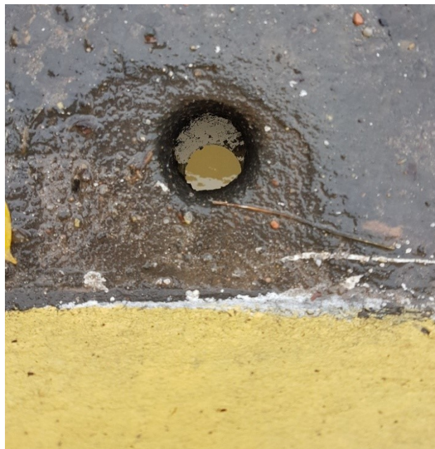
Figura 40 – Dreno da Ponte
