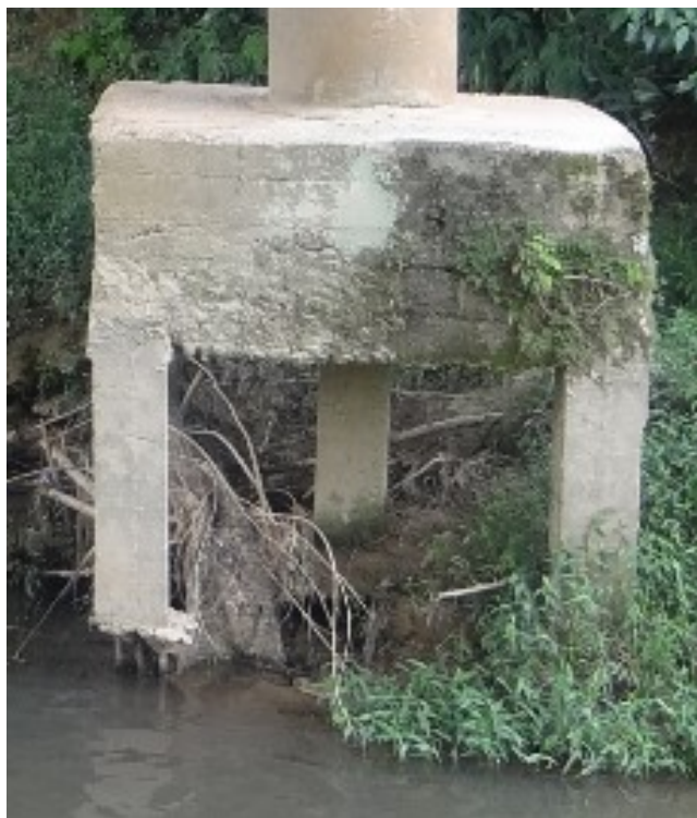
Figura 63 – Bloco de fundação com nicho de concretagem e crescimento de vegetação
