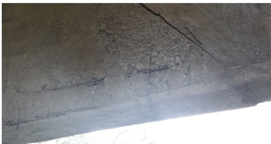
Figura 52 – Transversina e longarina com armadura exposta e corroída
