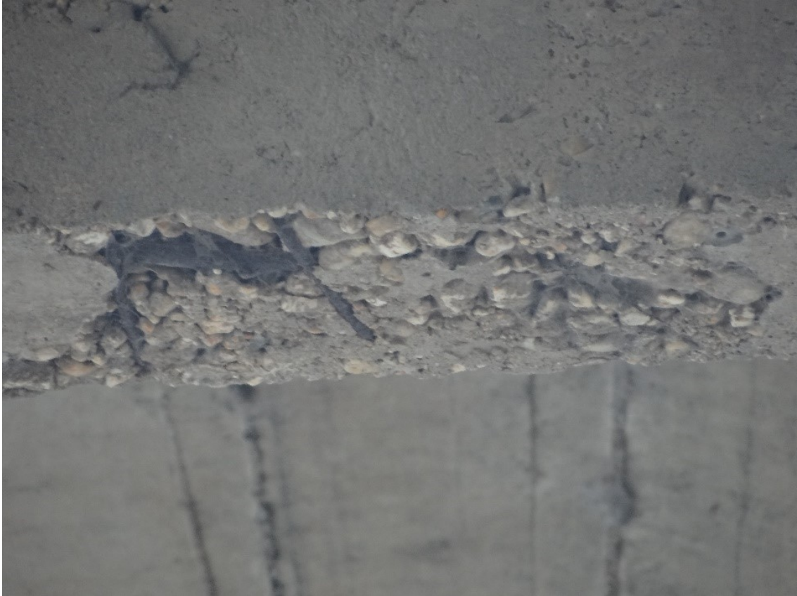
Figura 29 – Transversina com armadura exposta, corrosão e concreto deteriorado
