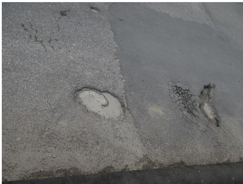
Figura 57 – Pavimento da ponte com anomalias
