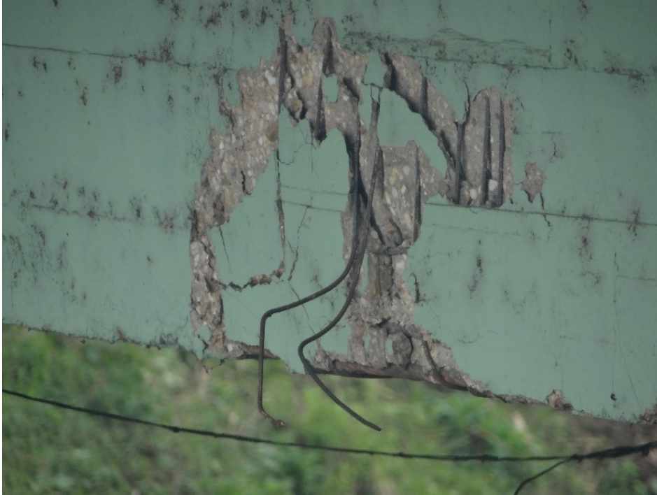
Figura 30 – Dano por colisão na longarina oeste da ponte
