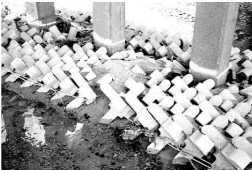
Figura 73 – Enrocamento artificial em pilar de ponte
