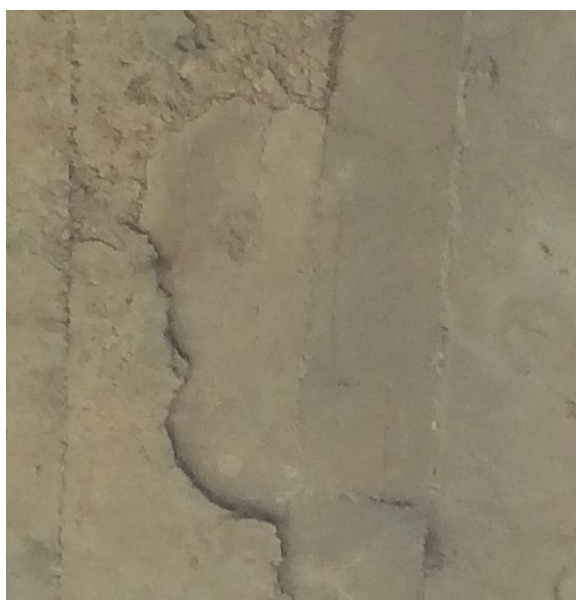
Figura 49 – Deslocamento do concreto da laje Fonte: Ana Elisa Boettger (2018).
