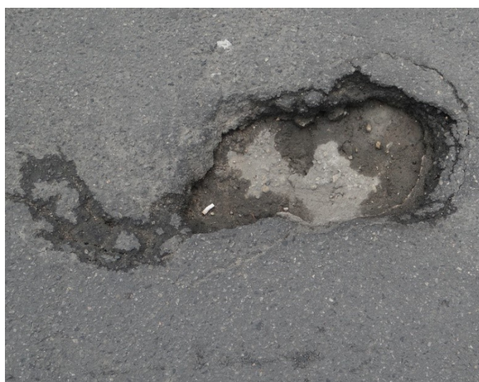
Figura 58 – Buraco severo na ponte
