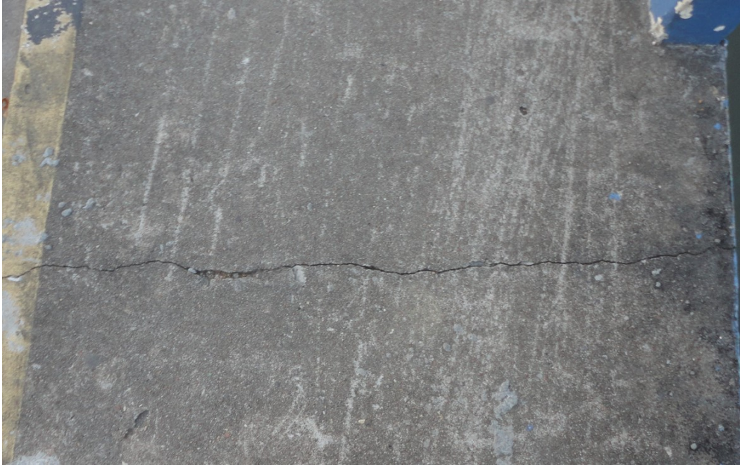
Figura 39 – Trinca na calçada da ponte
