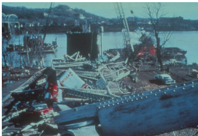
Figura 19 – Ponte Silver após desabamento
