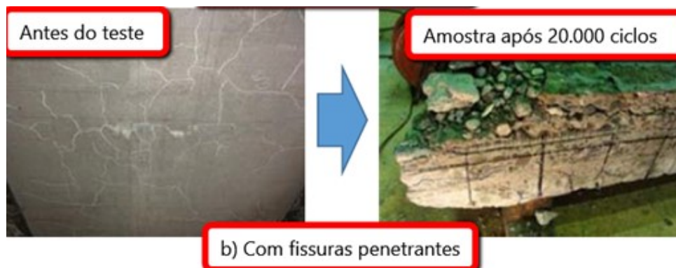
Figura 21 - Teste de Fadiga em Amostra de Ponte com Fissuras Penetrantes
