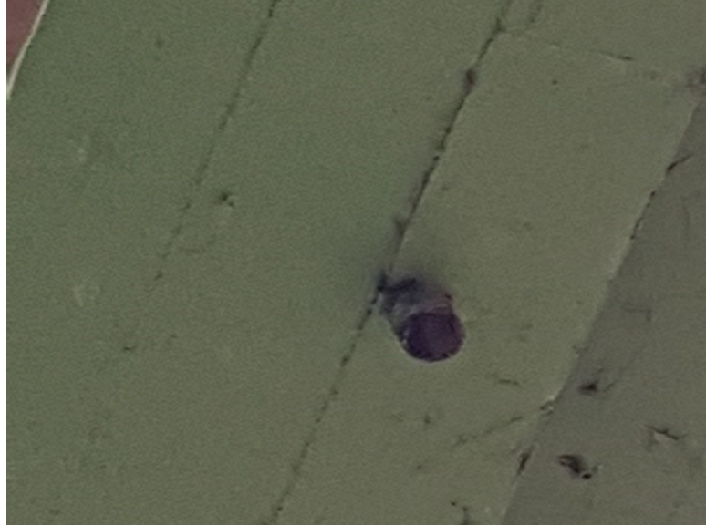
Figura 41 – Tubulação de Drenagem
