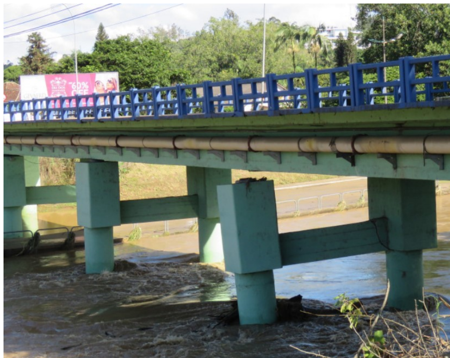
Figura 69 – Pilar descalçado durante a cheia
