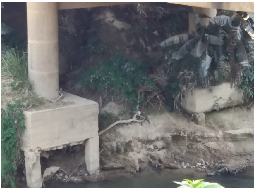
Figura 56 – Talude da ponte
