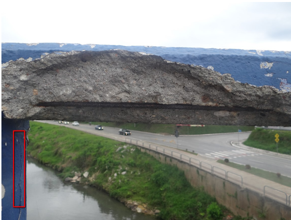
Figura 37 – Armadura exposta e corroída no peitoril; em destaque, fissura devido à corrosão da barra vertical
