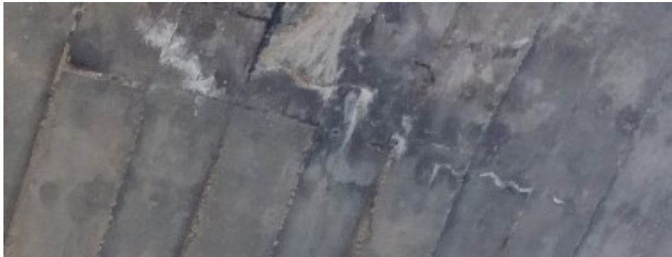
Figura 46 – Pontos com eflorescência sobre a laje abaixo da pista Fonte: Ana Elisa Boettger (2018).
