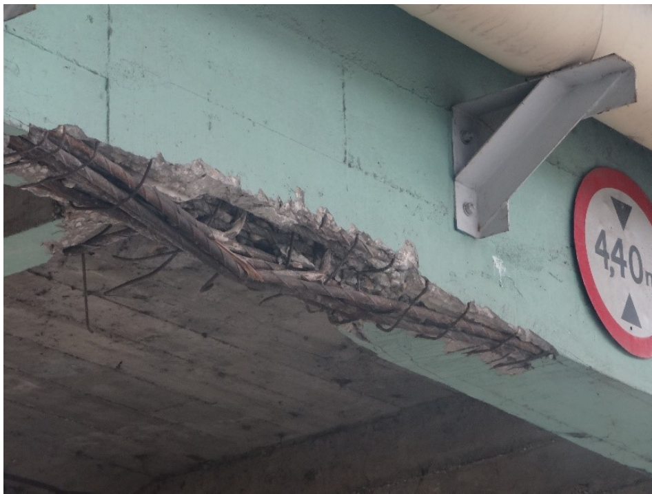
Figura 31 – Dano por colisão na longarina leste da ponte
