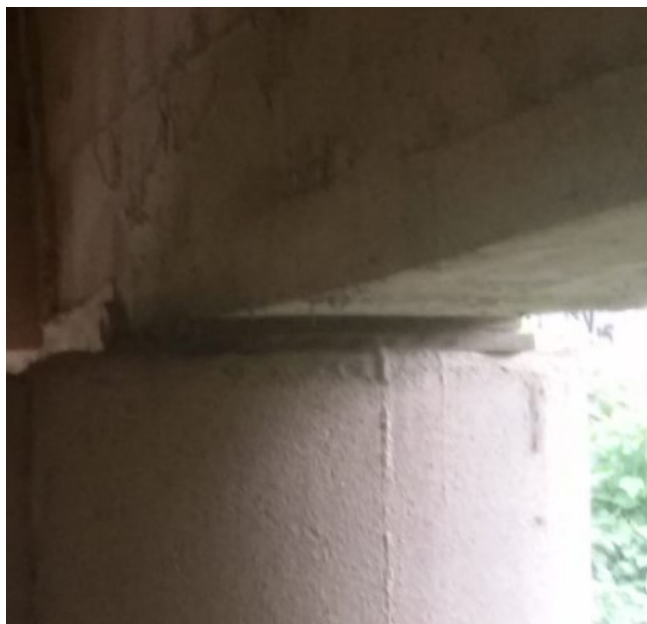
Figura 67 – Aparelho de apoio da ponte
