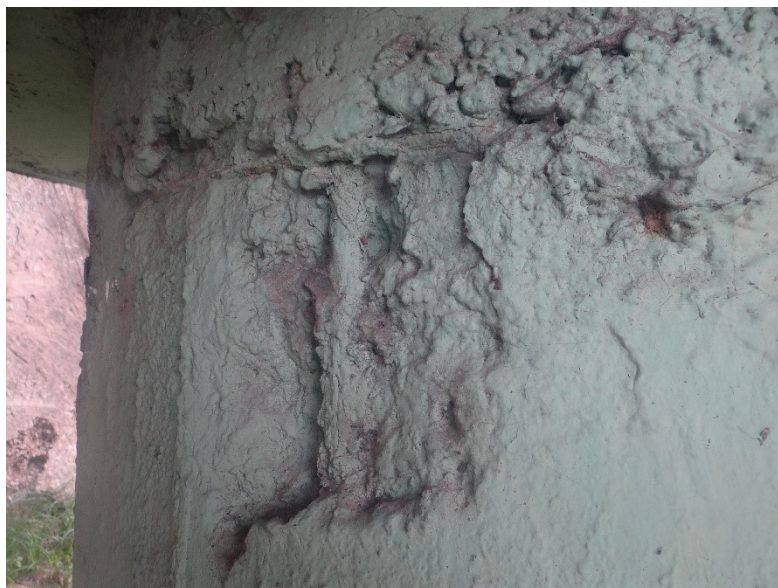
Figura 38 – Topo de pilar sul com nicho de concretagem e armadura exposta
