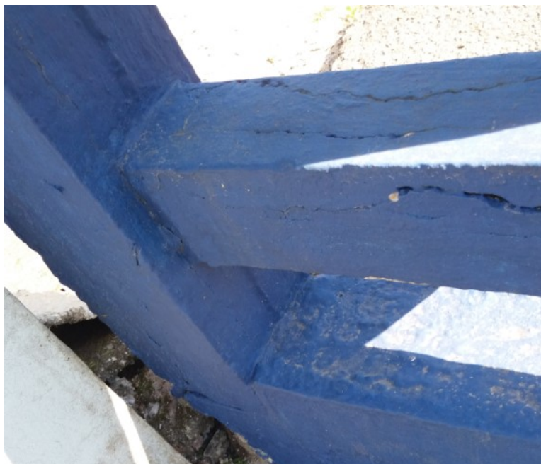
Figura 59 – Fissuras no peitoril da ponte
