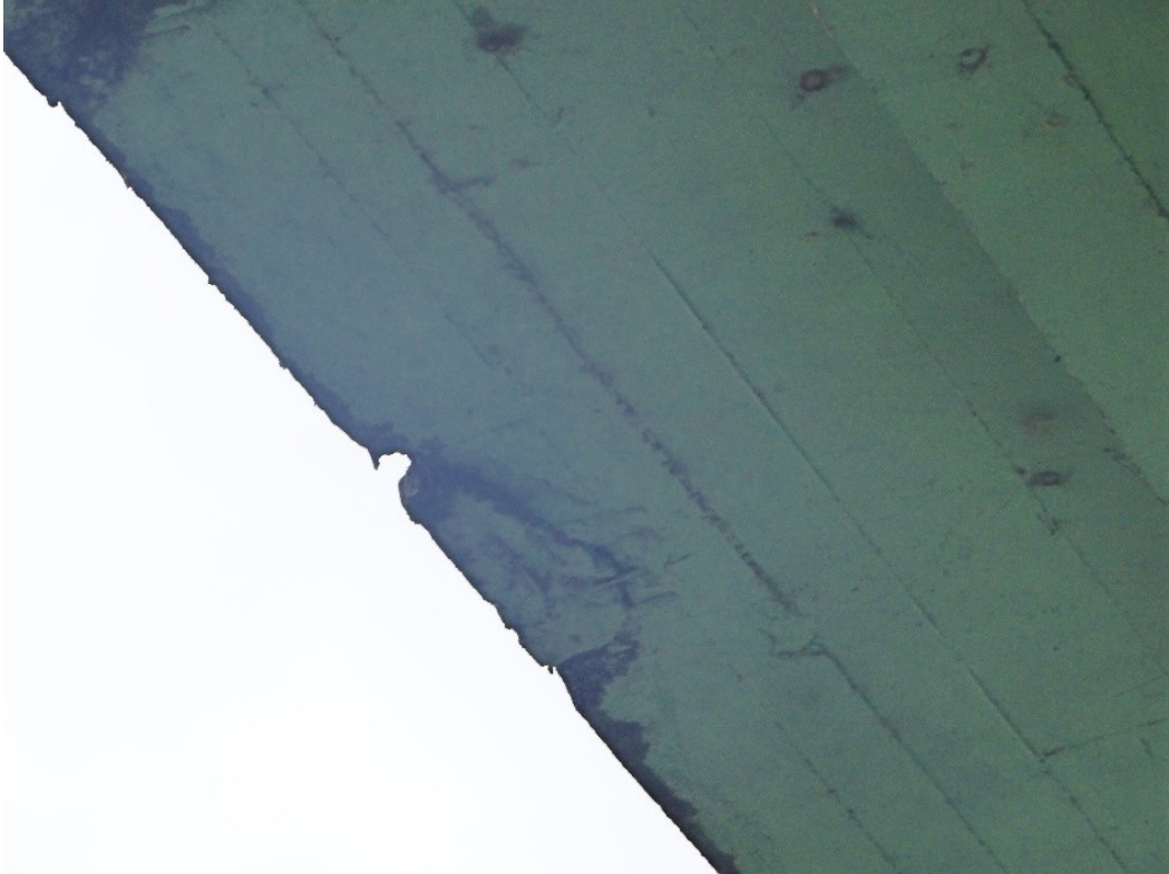
Figura 28 – Laje da ponte apresentando armadura exposta, infiltrações e desprendimento do concreto
