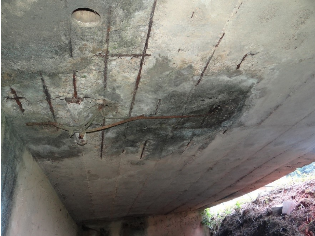
Figura 45 – Laje sob a passagem de pedestres da Ponte Fonte: Ana Elisa Boettger (2018).
