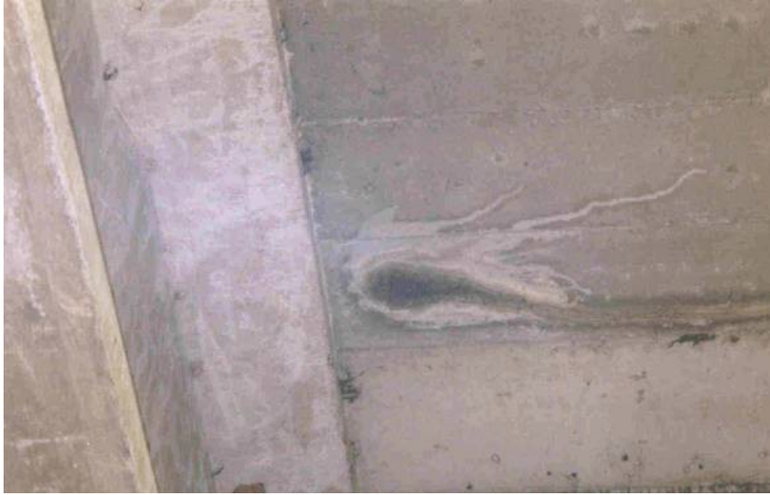
Figura 17 – Lixiviação em Ponte por ausência de elementos de drenagem Fonte: Julia Wippich Lencioni (2004).
