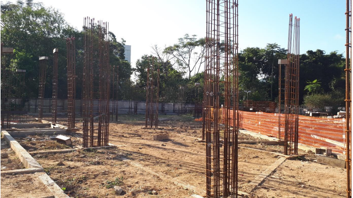
Figura 25 - Foto do local onde as inspeções foram realizadas.
