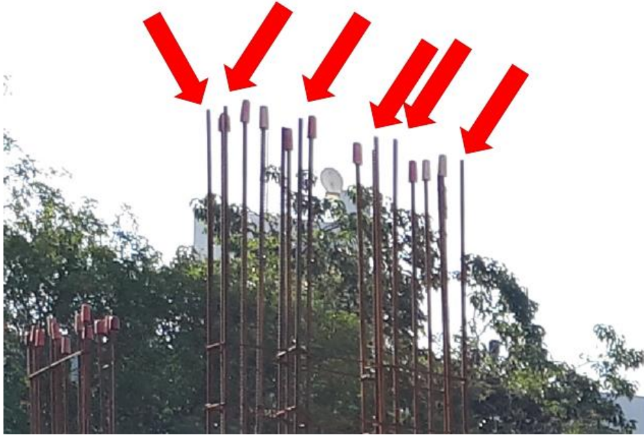
Figura 29 - Pontas das barras sem proteção.
