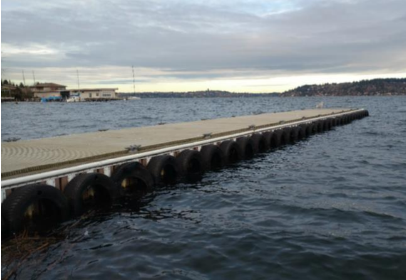
Figura 12 – Doca flutuante com para-choques instalados Fonte: FAA (2017)
