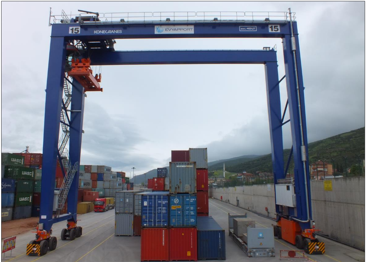
Figura 17 - Equipamentos de retroárea - RTG
