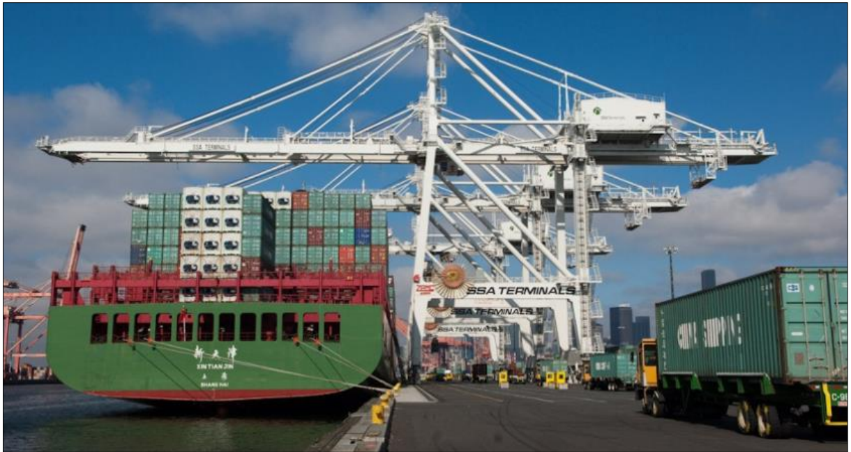
Figura 14 - Equipamentos de cais - Portêiner
