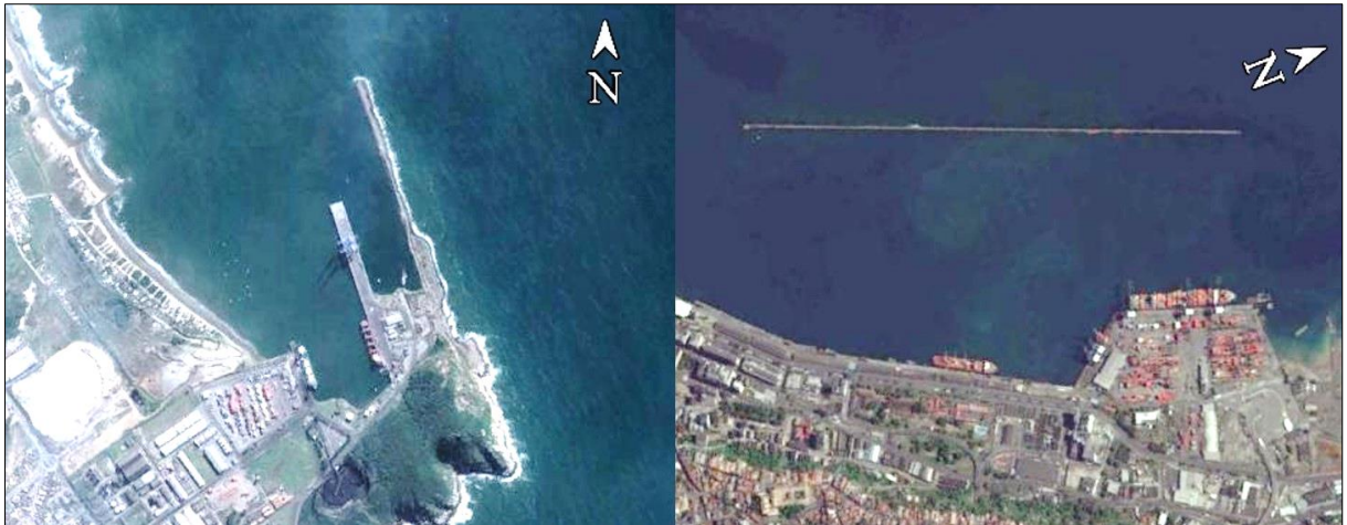
Figura 19 – Molhe do Porto de Imbituba e quebra-mar do Porto de Salvador
