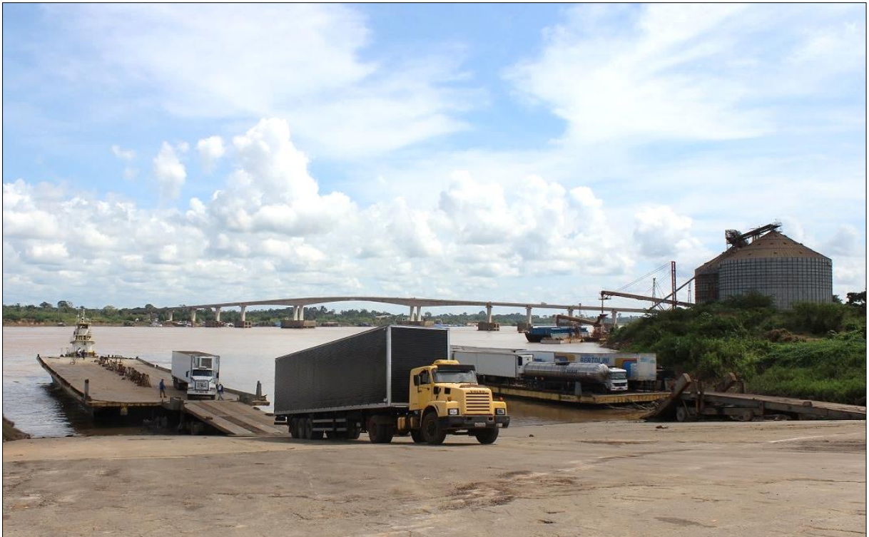
Figura 9 - Exemplo de estrutura de acostagem do tipo rampa Ro-Ro
