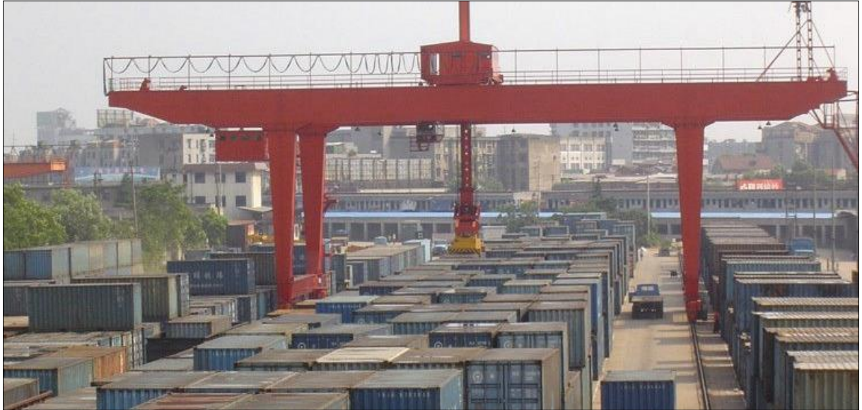
Figura 16 - Equipamentos de retroárea - RMG
