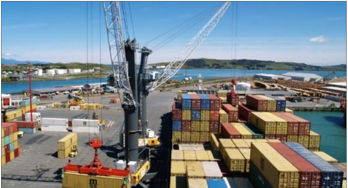
Figura 15 - Equipamentos de cais - MHC
