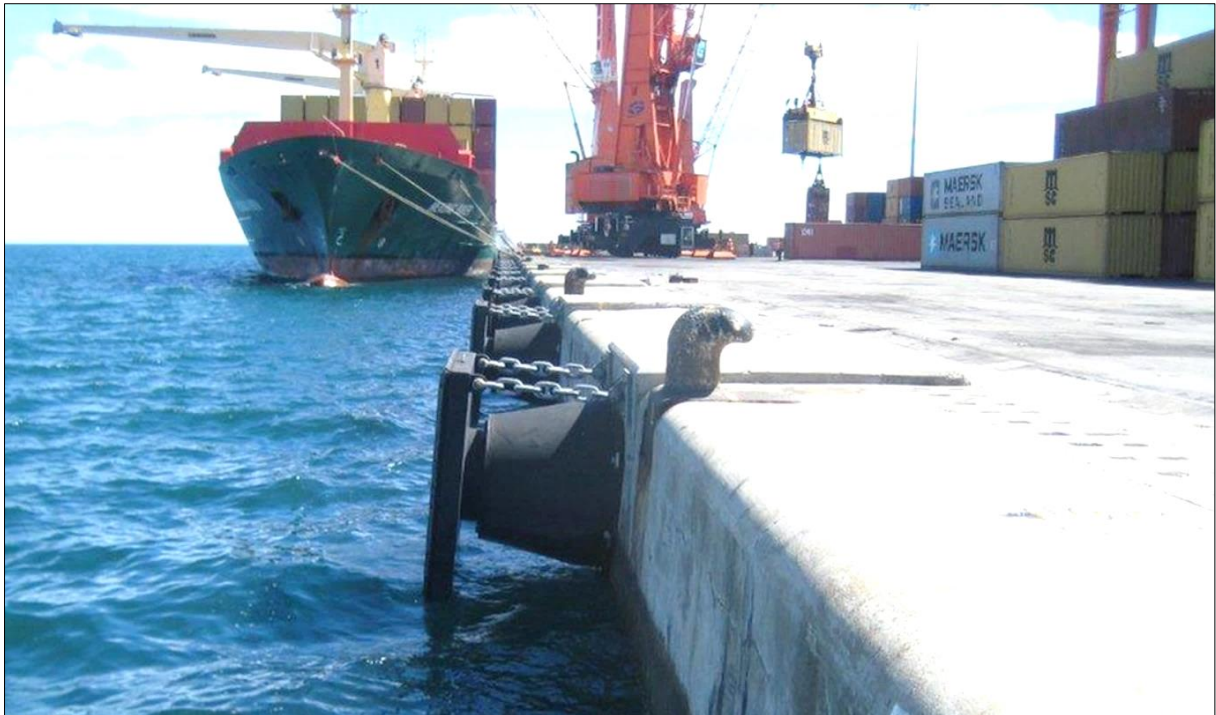
Figura 10 - Exemplo de defesa e cabeço de amarração
