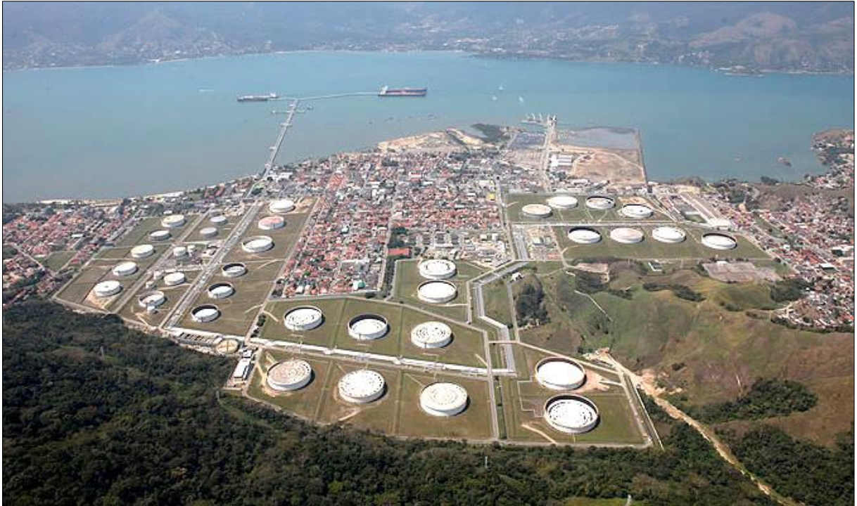
Figura 12 - Armazenagem de graneis líquidos no TEBAR
