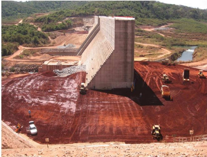
Figura 3 – Barramento de Gravidade em CCR da Barragem Ribeirão João Leite (GO).
