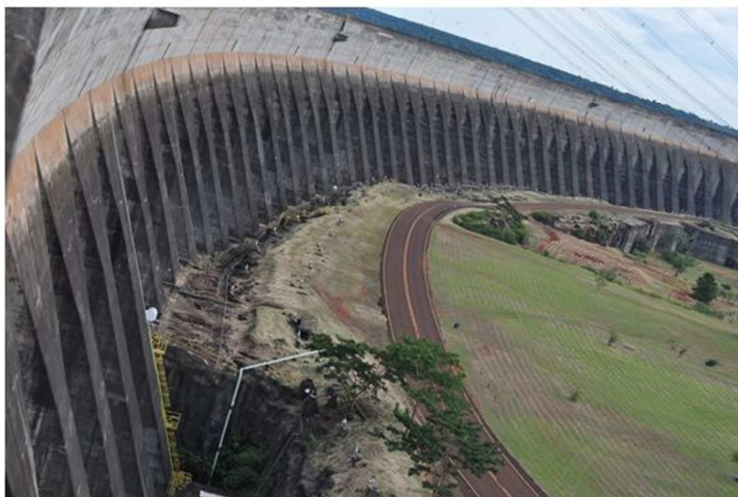
Figura 6 – Barragem em contraforte da UHE Itaipu, Foz do Iguaçu (PR).
