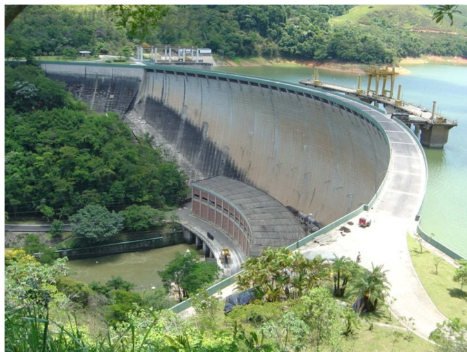
Figura 5 – Barragem em arco da UHE Funil, Rio Grande (MG).
